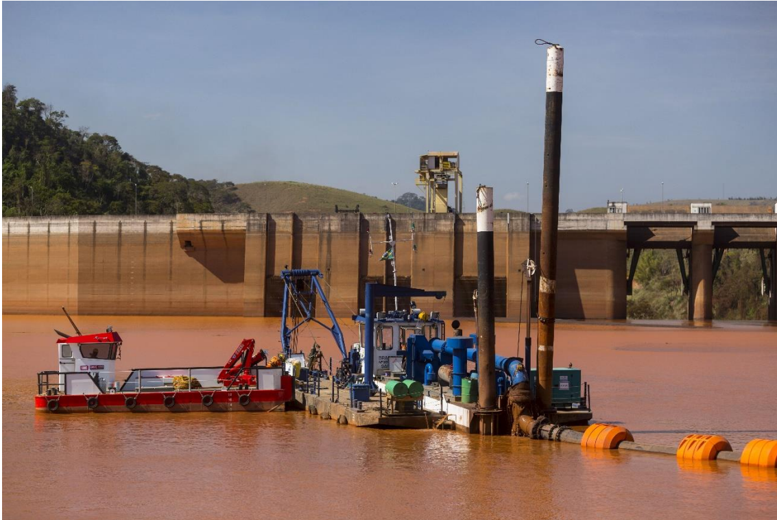
Dragagem Usina Hidrelétrica Risoleta Neves (Leo Drumond/Nitro)
