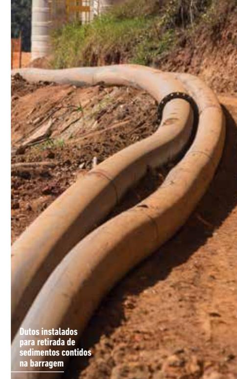
Dutos instalados para retirada de sedimentos contidos na barragem
