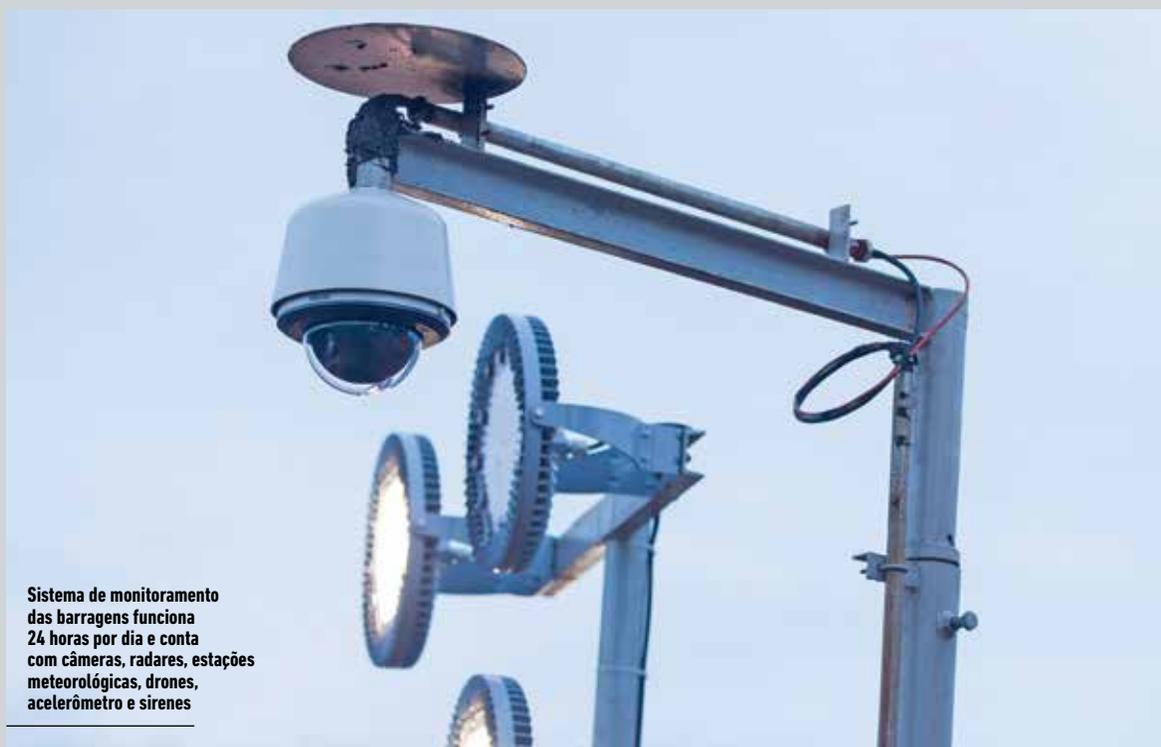
Sistema de monitoramento das barragens funciona 24 horas por dia e conta com câmeras, radares, estações meteorológicas, drones, acelerômetro e sirenes
