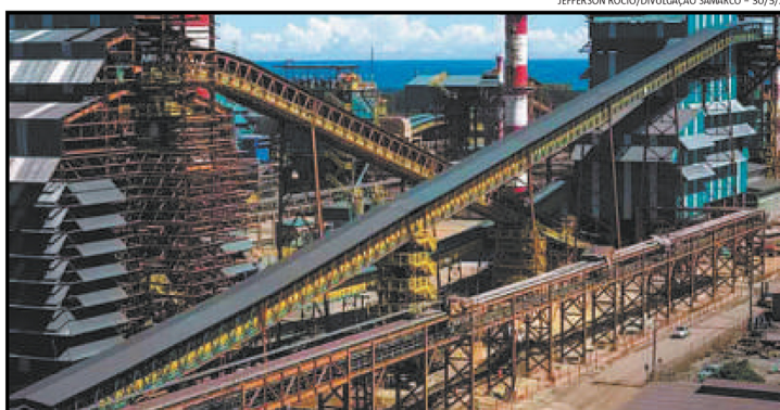
Sistema de filtragem de rejeitos da Samarco, que informou não utilizar mais barragens em seu processo operacional
