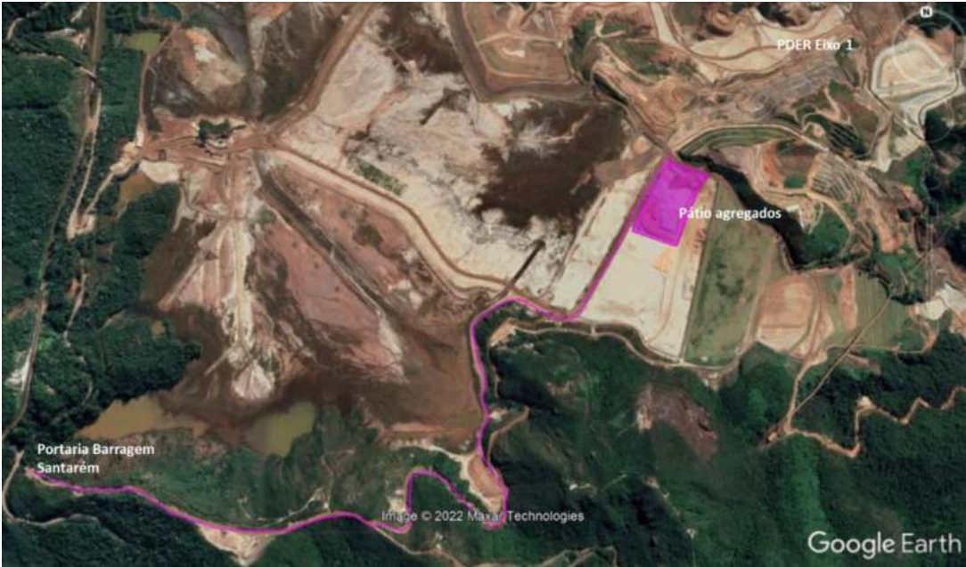
Acesso dos caminhões de agregados pela portaria da Barragem Santarém até o pátio de estocagem de agregados na Barragem Germano.
