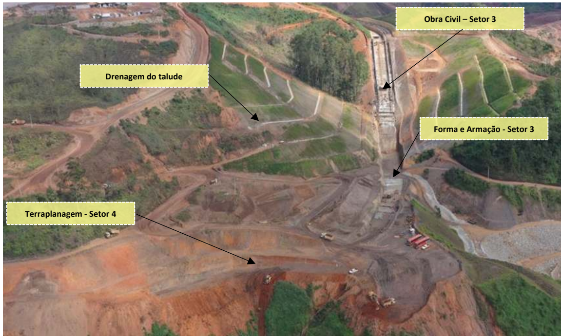
Foto 7 – Vista das obras dos Setores 3 e 4 em andamento
