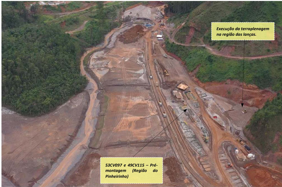
Foto 15: Área de Pré-Montagem do 53CV097 e 49CV115 na Região do Pinheirinho
