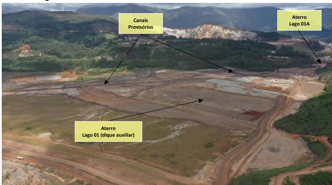
Foto 1 – Regrade do Lago 01 (dique auxiliar) e Canais Provisórios
