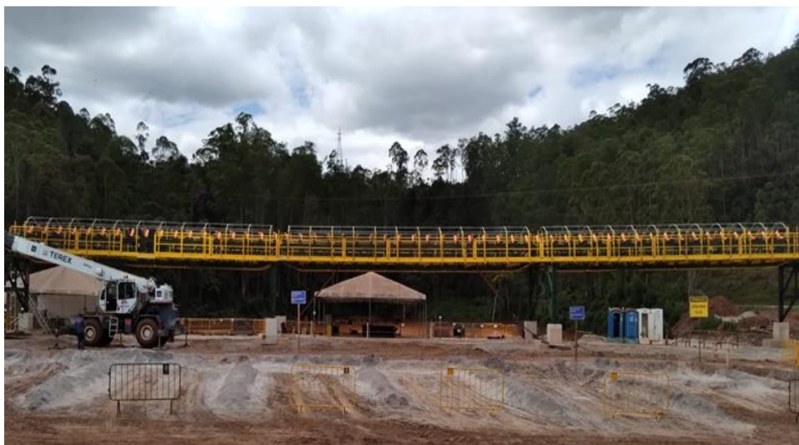
Foto 14: Montagem do trecho 31 ao 41 - Bacia do Chico
