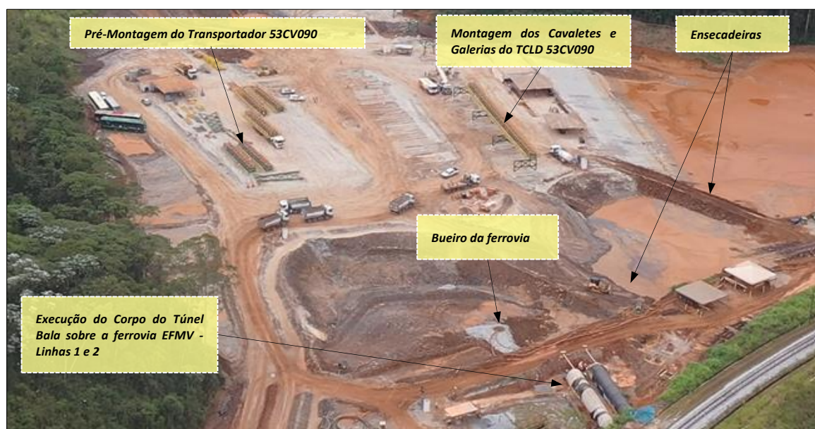
Foto 16: Execução dos túneis bala, pré-montagem e montagem do 53CV090
