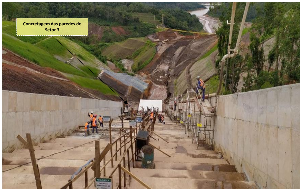
Foto 9 – Concretagem de paredes no canal do Setor 3 (escada hidráulica)
