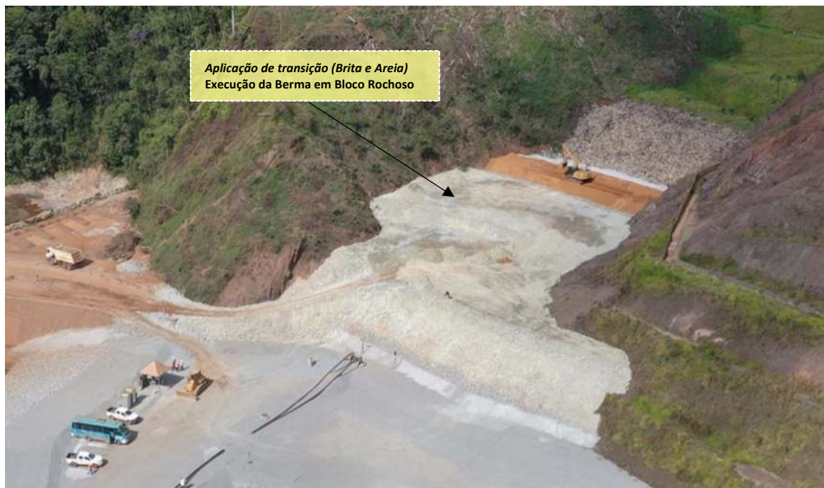
Foto 11 – Reforço do Barramento principal em andamento – Visão Geral
