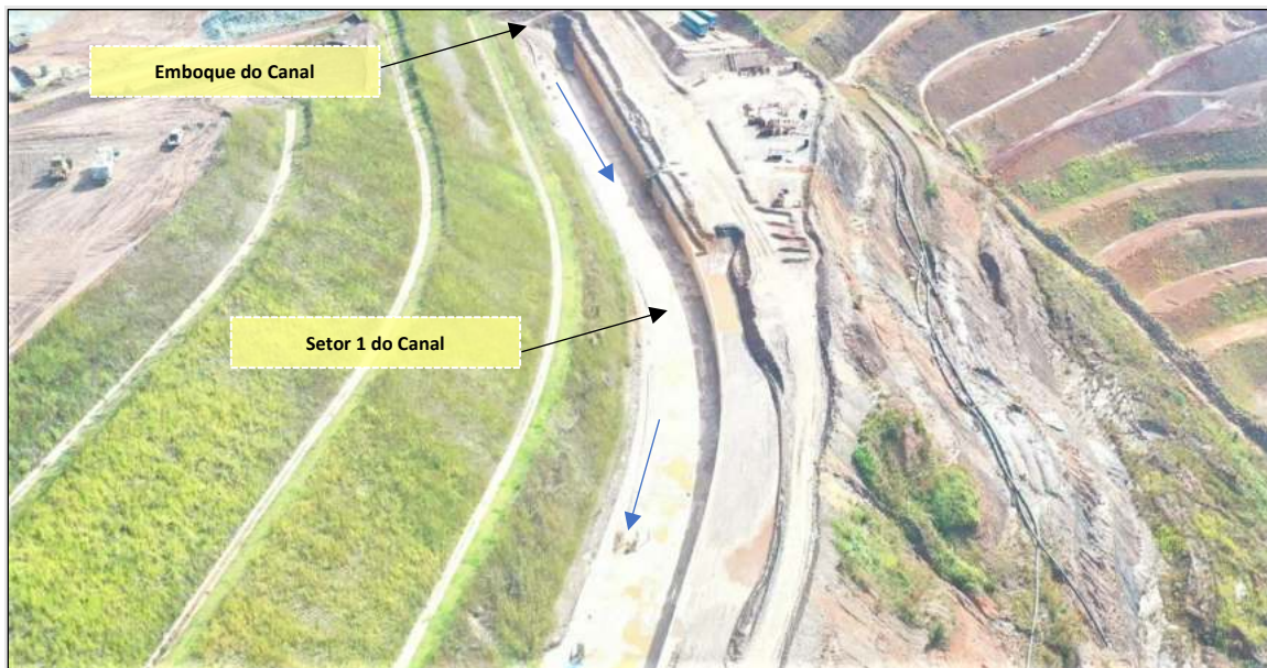
Foto 5 – Vista das obras do Setor 1
