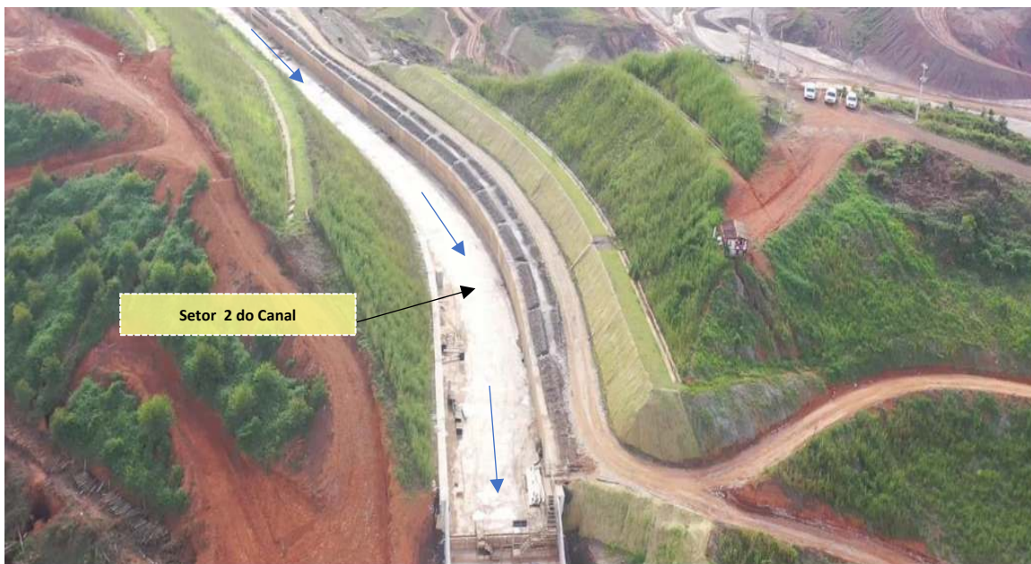
Foto 6 – Vista das obras do Setor 2
