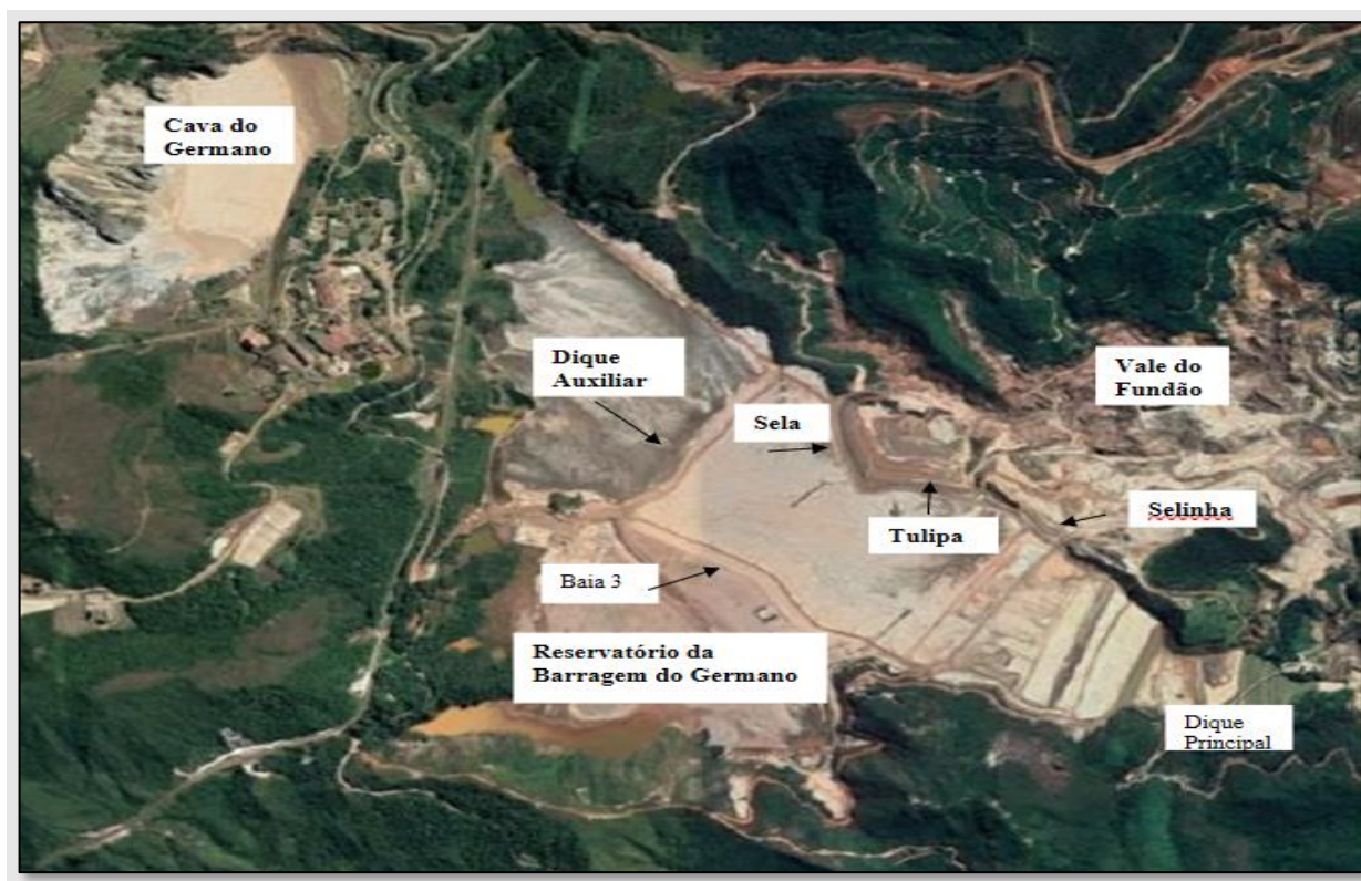
Figura 1 - Vista geral das Barragens da Samarco
