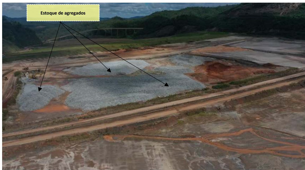
Foto 4 - Baía da crista da barragem de Germano
