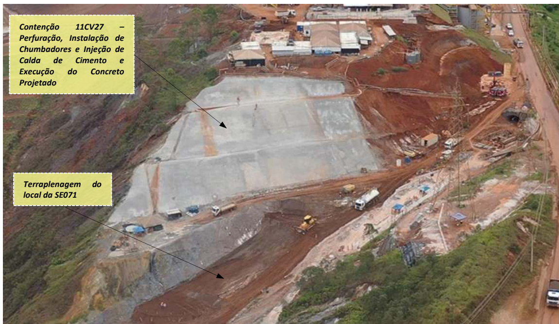
Foto 17: Execução da Contenção 1/ 1A, Contenção 3 e Contenção 11CV027
