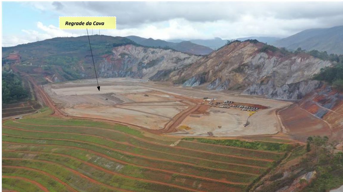
Fotos 19: Execução do regrade da Cava
