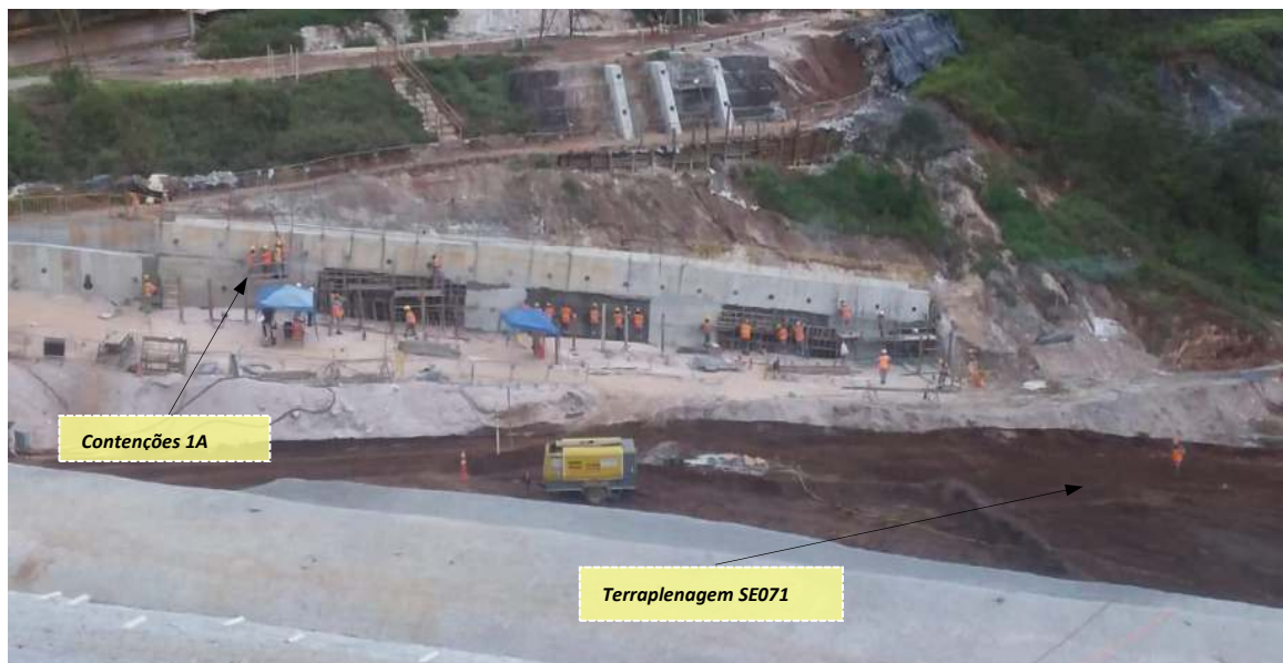
Foto 18: Execução da Contenção 1/ 1A
