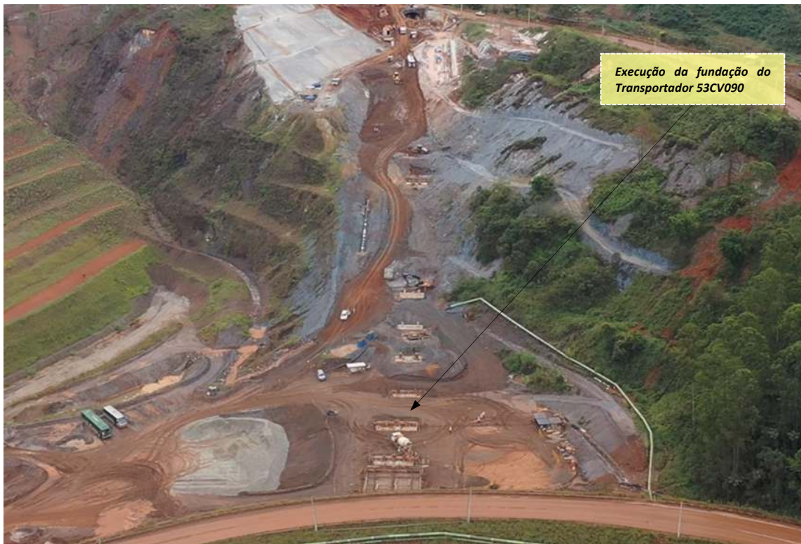
Foto 13: Execução das bases de fundação na região da Cava – Trecho entre Filtragem e Bacia do Chico
