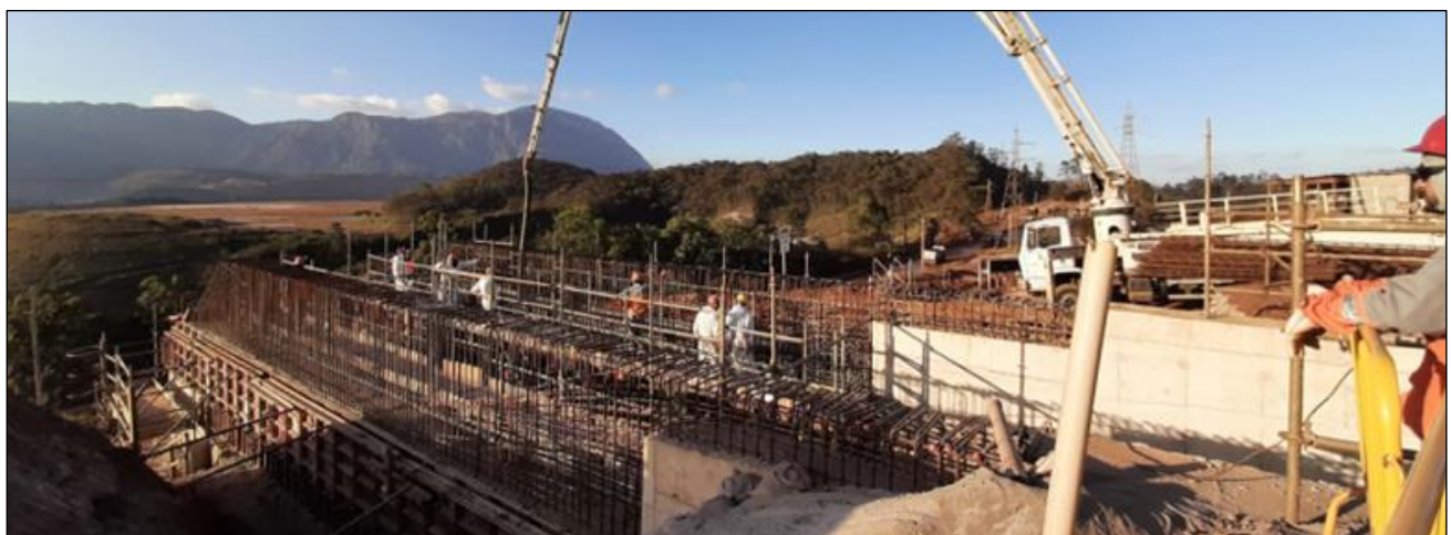
Foto 14 - Execução da concretagem da galeria do CV088
