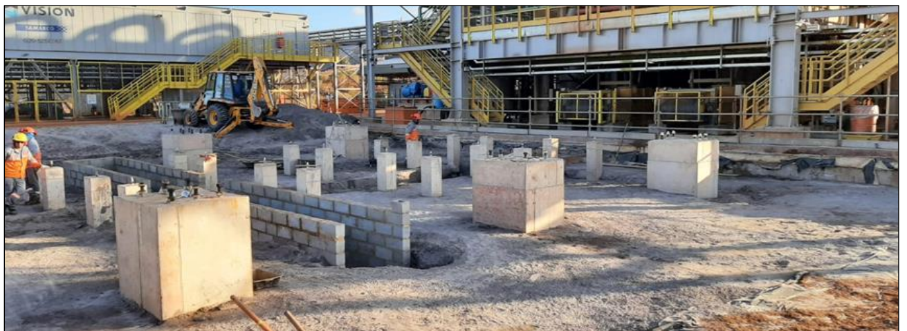
Foto 13 - Execução de canaletas de drenagem e reaterro das bases civis do CV081/082
