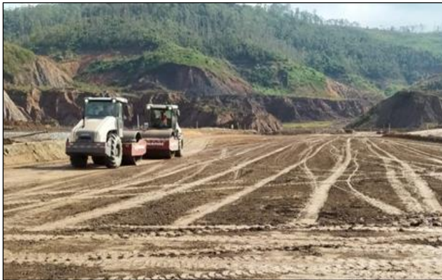
Foto 5 – Aterro controlado Montante eixo 01
