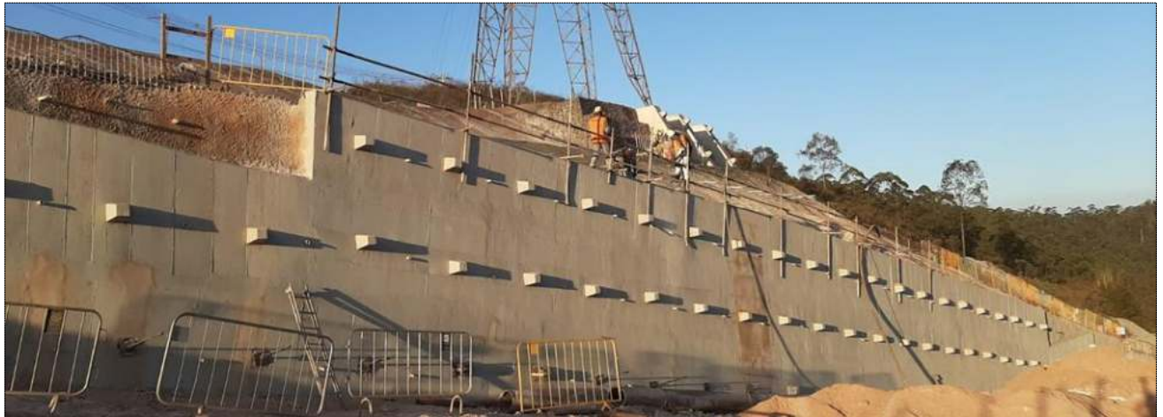
Foto 22 - Execução da contenção 01 – trecho A
