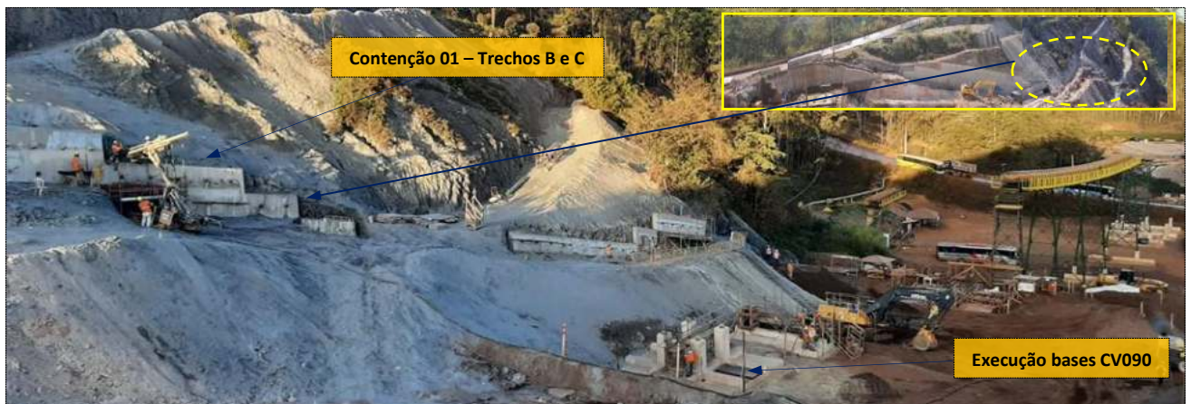
Foto 23 - Execução da contenção 01 - trechos B e C
