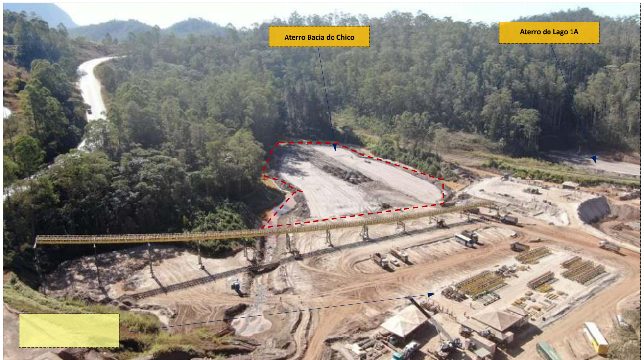
Foto 20 - Execução dos aterros da fase 2 da bacia e do Lago 1A
