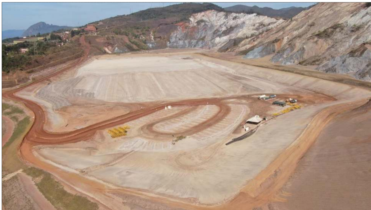
Foto 27 - Execução da reconformação do reservatório
