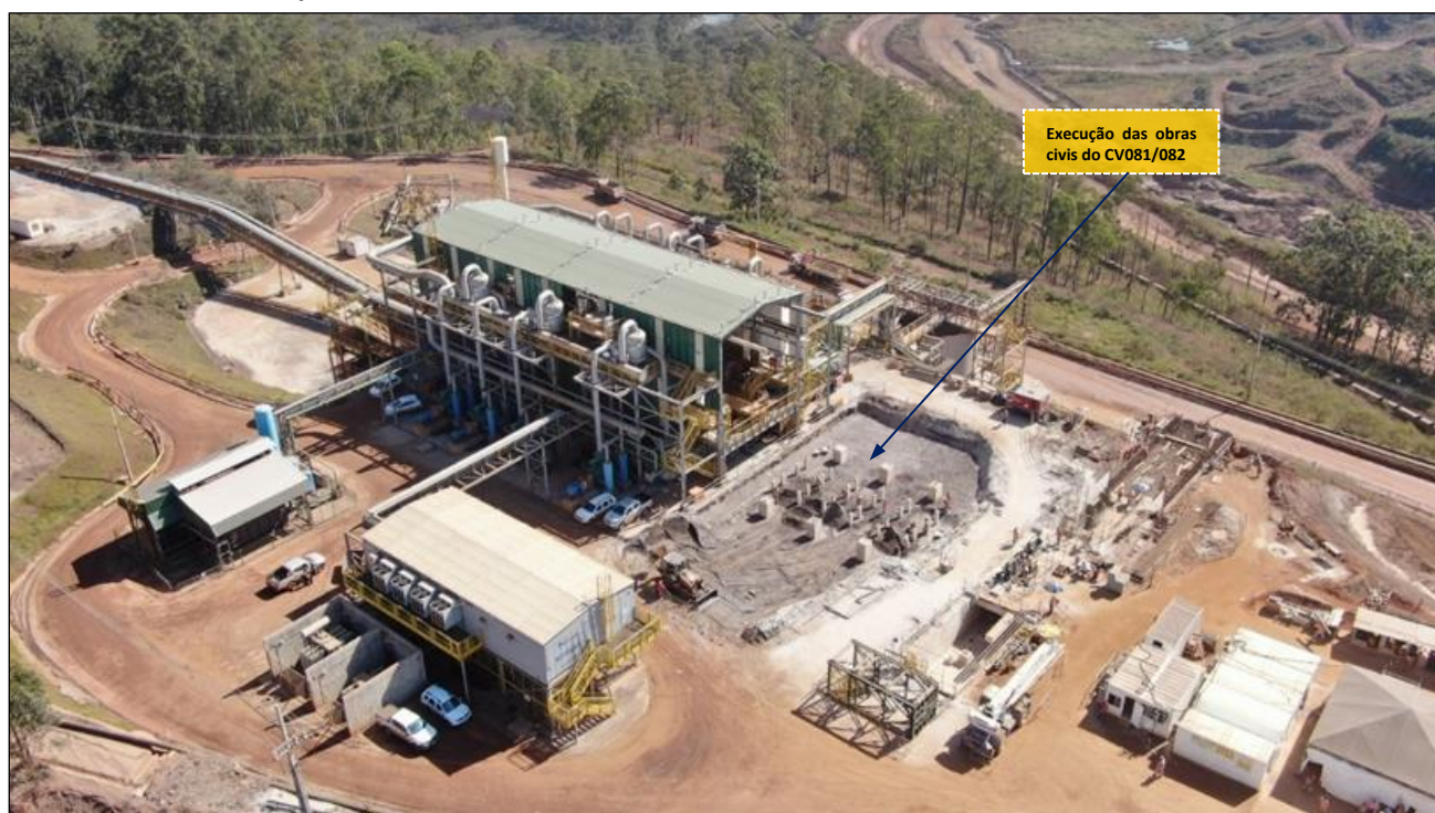
Foto 11 - Vista das obras civis do CV081/082/088
