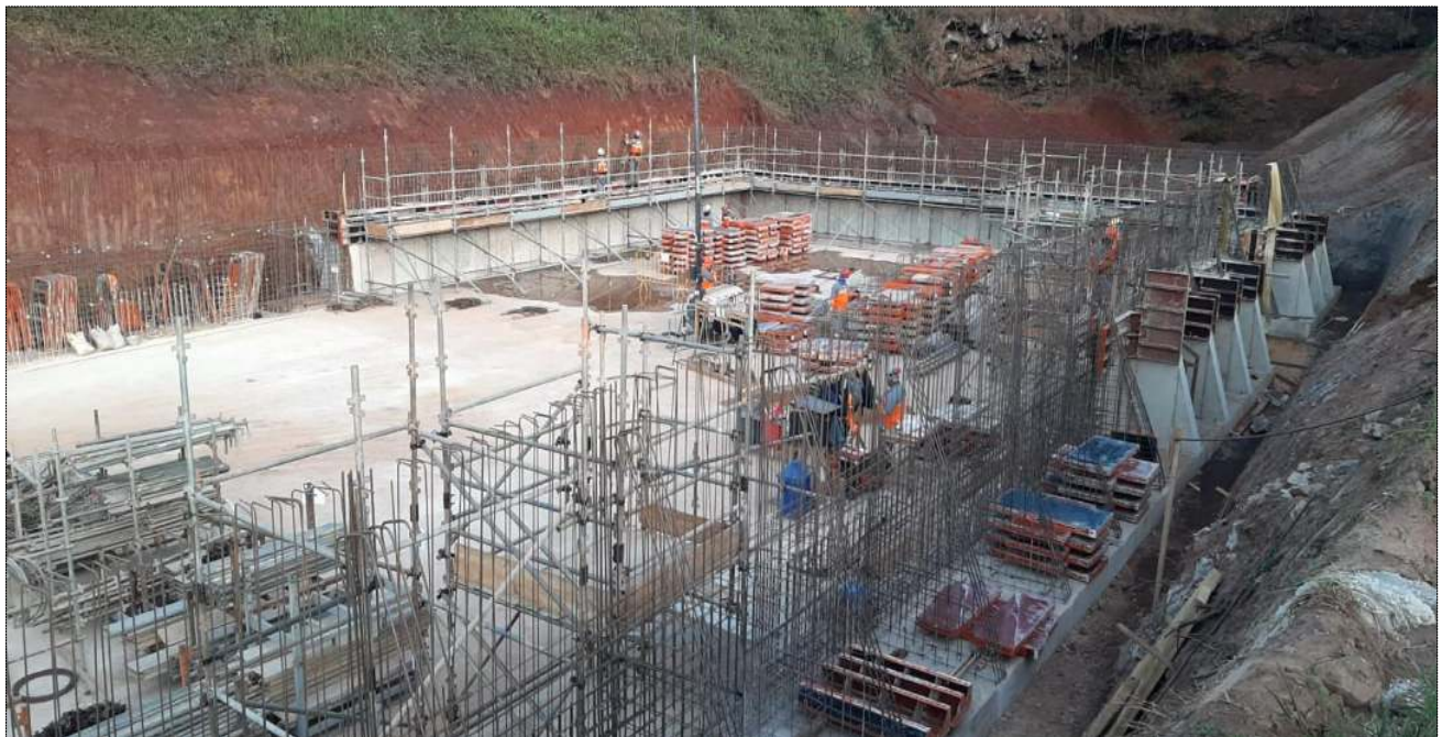
Foto 26 - Execução da bacia de dissipação superior
