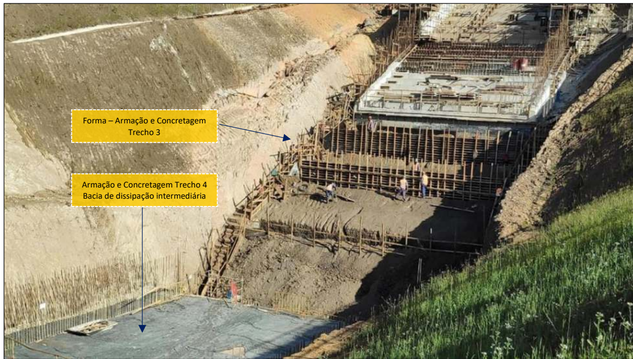
Foto 3 – Escada Hidráulica – Setor 3 e Bacia de dissipação intermediária
