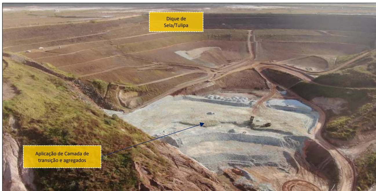
Foto 10 – Dique de Sela/Tulipa – aplicação de agregados
