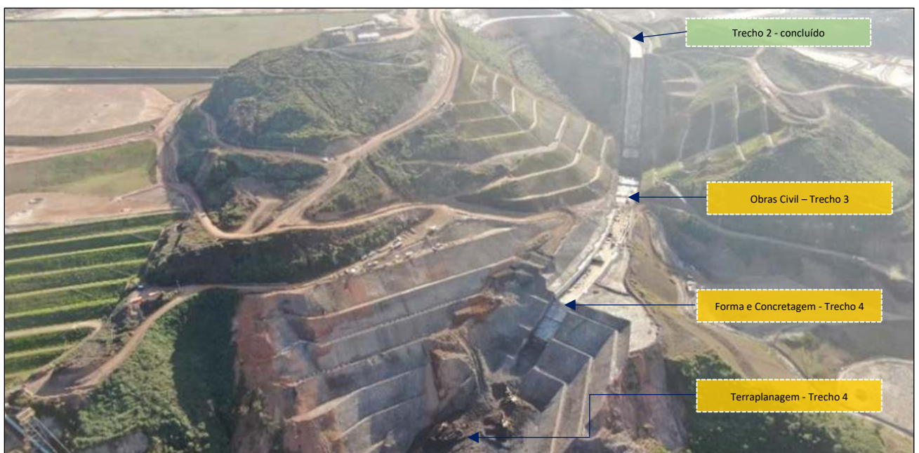
Foto 2 – Vista das obras nos setores 2, 3 e 4
