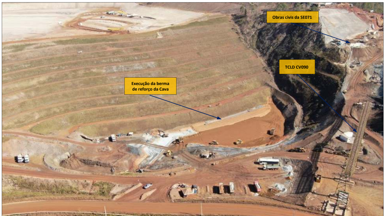
Foto 25 - Execução do aterro controlado de estéril e dreno de fundo da berm de reforço
