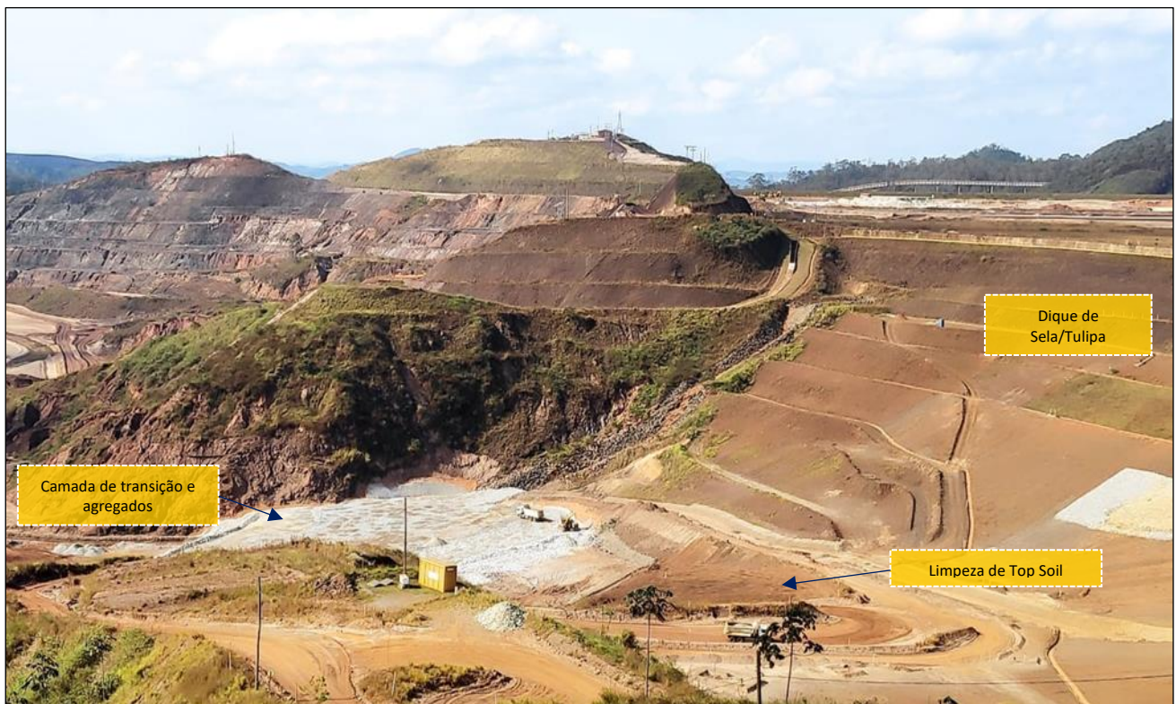
Foto 9 – Dique de Sela/Tulipa – limpeza de top soil e aplicação de agregados
