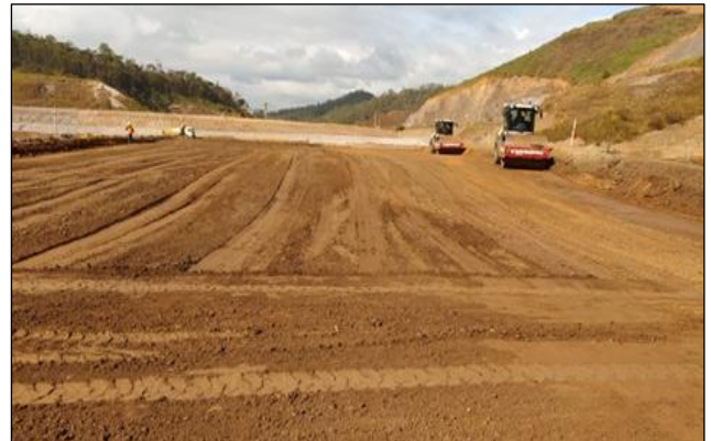
Foto 6 – Aterro controlado Montante eixo 01
