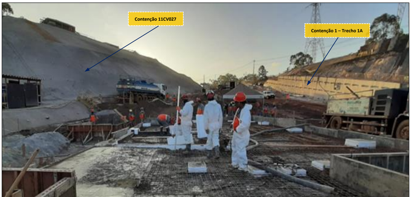
Foto 16 - Execução de concretagem da laje de piso do eletrocentro SE071
