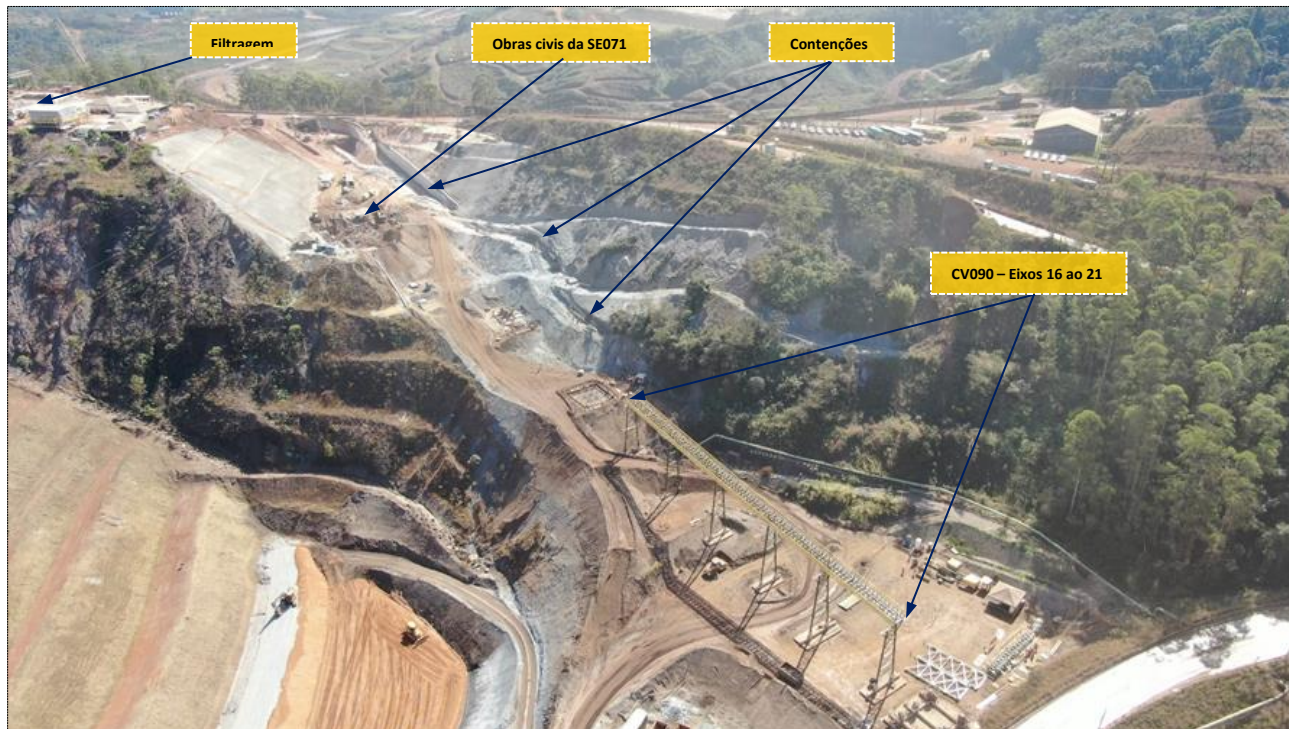
Foto 17 - Execução de montagem no trecho da Cava – trecho CT089 até Rodovia
