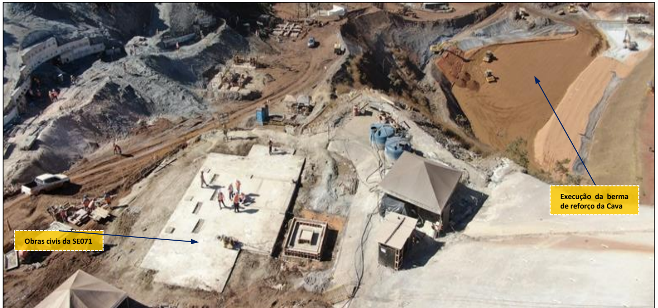
Foto 15 - Execução das obras civis do eletrocentro SE071
