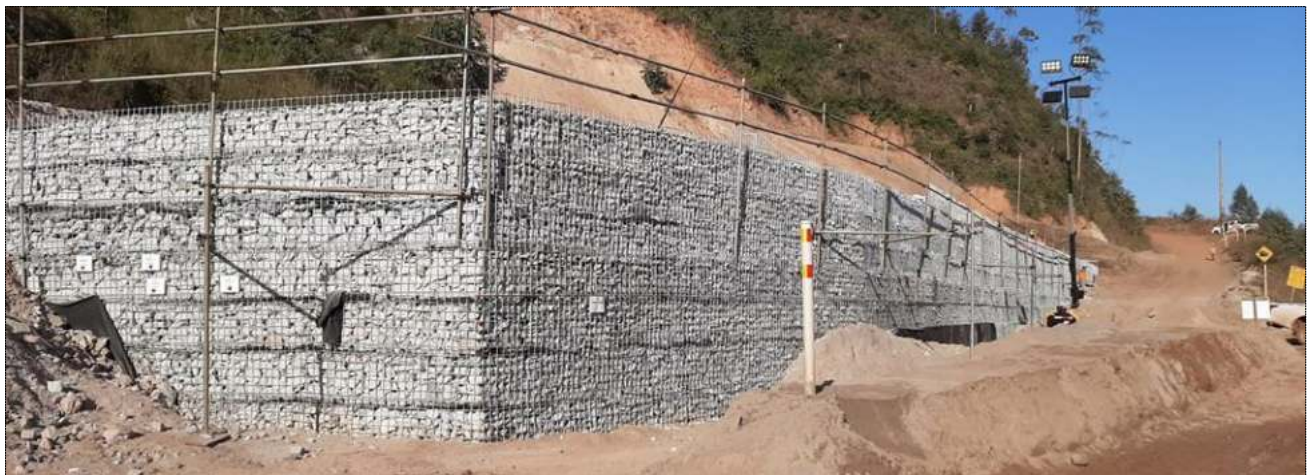
Foto 24 - Execução da contenção 7 – Quadratum
