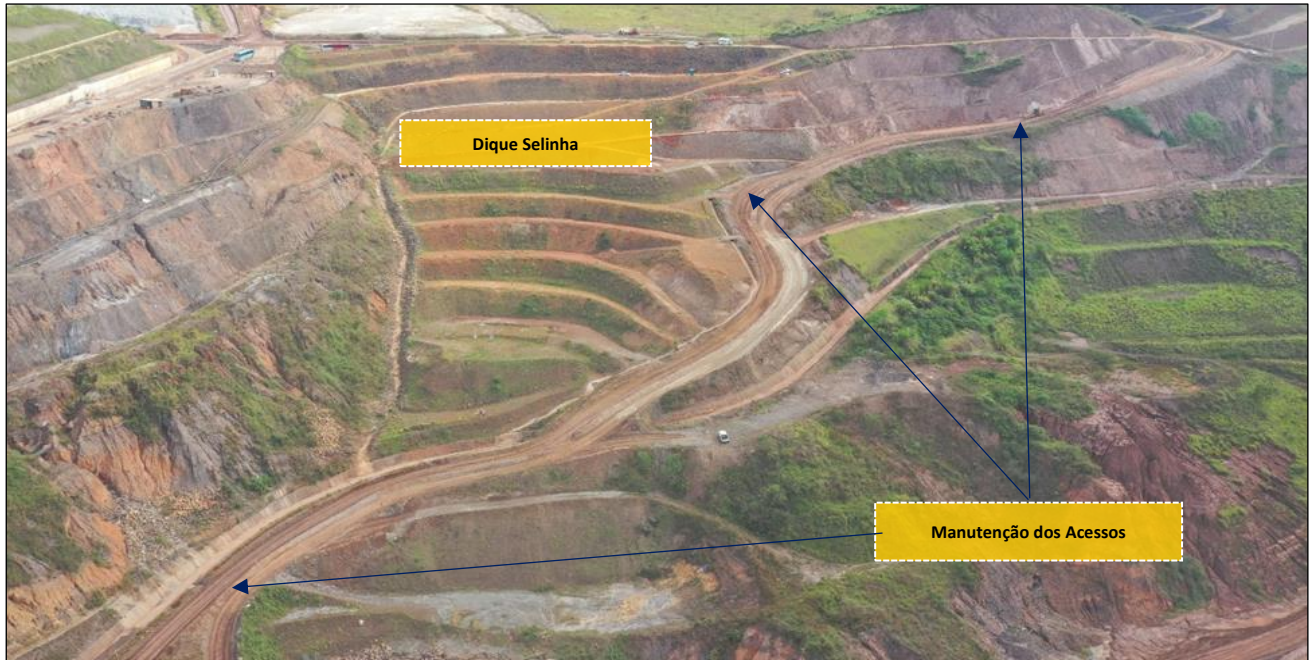
Foto 8 - Dique de Selinha – Manutenção dos Acessos
