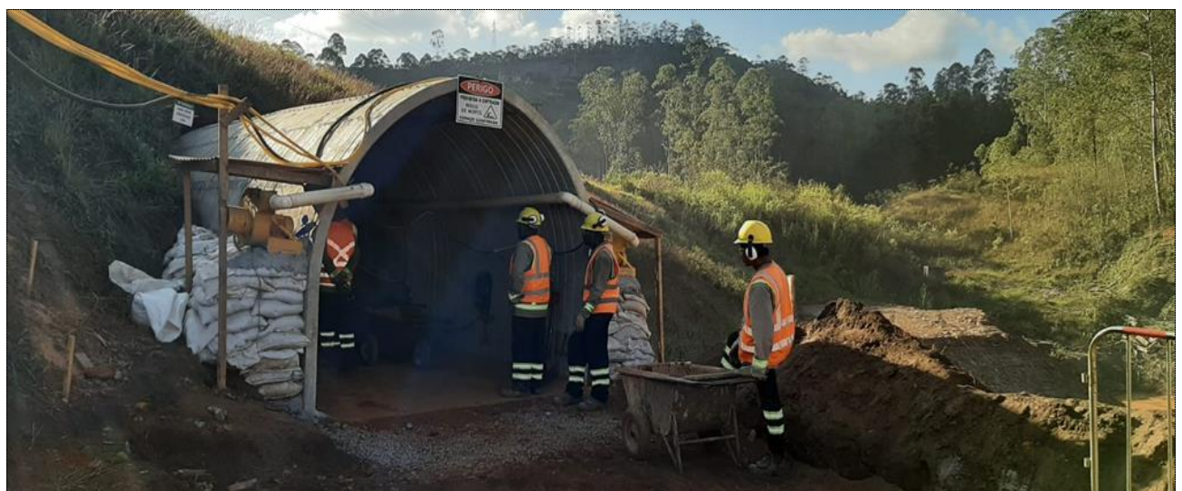
Foto 21 - Execução do túnel bala - linha 02 sob a EFVM
