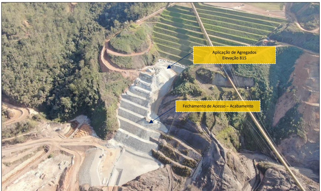
Foto 7 – Reforço do Barramento principal em andamento – Visão Geral
