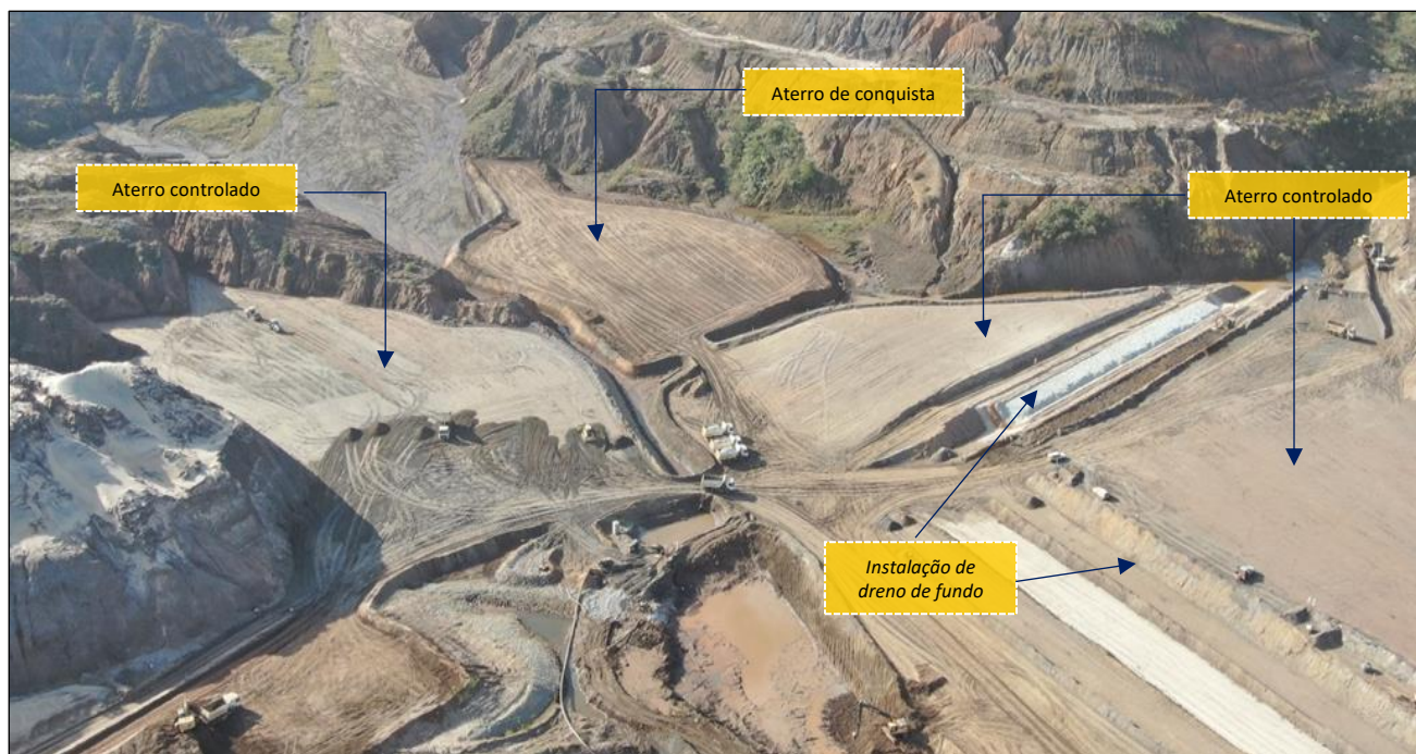
Foto 4 – Preenchimento do Eixo 1 etapa 2
