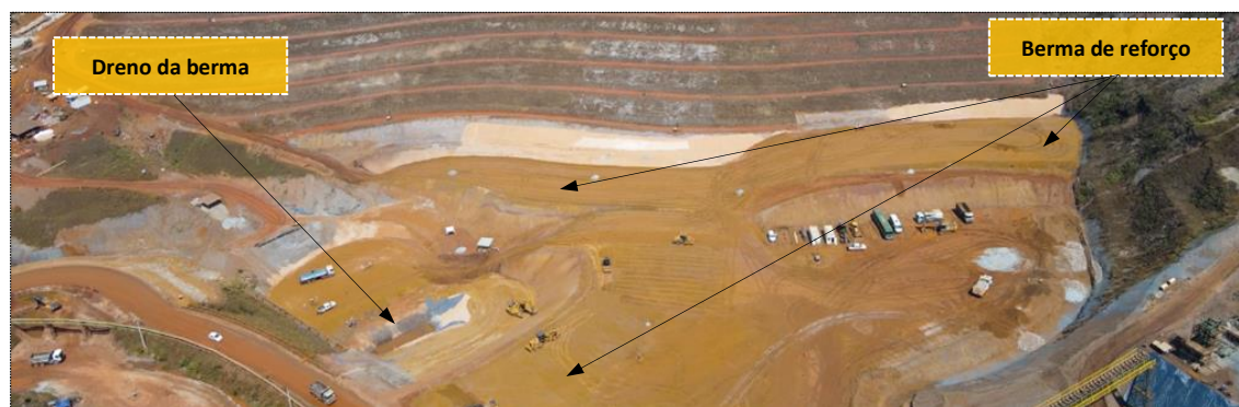
Foto 51: Execução de limpeza, dreno e aterro controlado no pé da Cava do Germano
