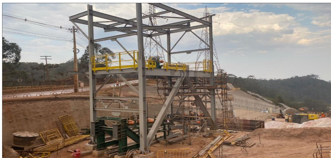
Foto 30 – Montagem da caixa de transferência do CT089
