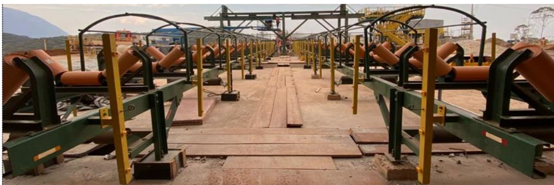
Foto 25 - Montagem de módulos CV081 e CV082
