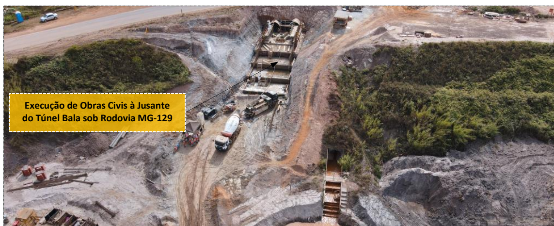
Foto 45: Execução de obras civis de drenagem à jusante do túnel bala e plugagem do túnel liner sob a MG-129
