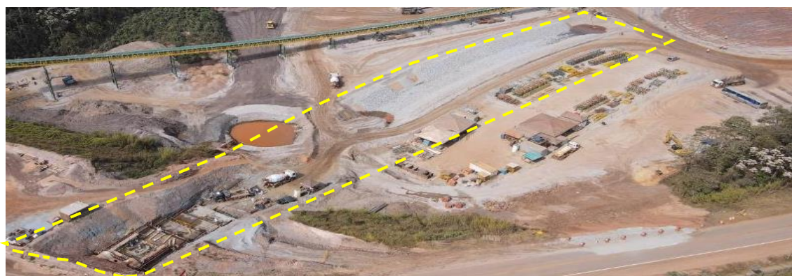
Foto 57 - Execução do canal de transposição da bacia do Chico
