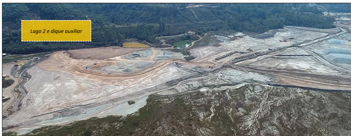
Foto 19 – Aterro de conquista no lago 2 e dique auxiliar
