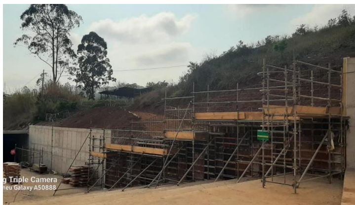
Fotos 54 e 55 - Execução das travessias em pré-moldados e paredes moldadas in loco
