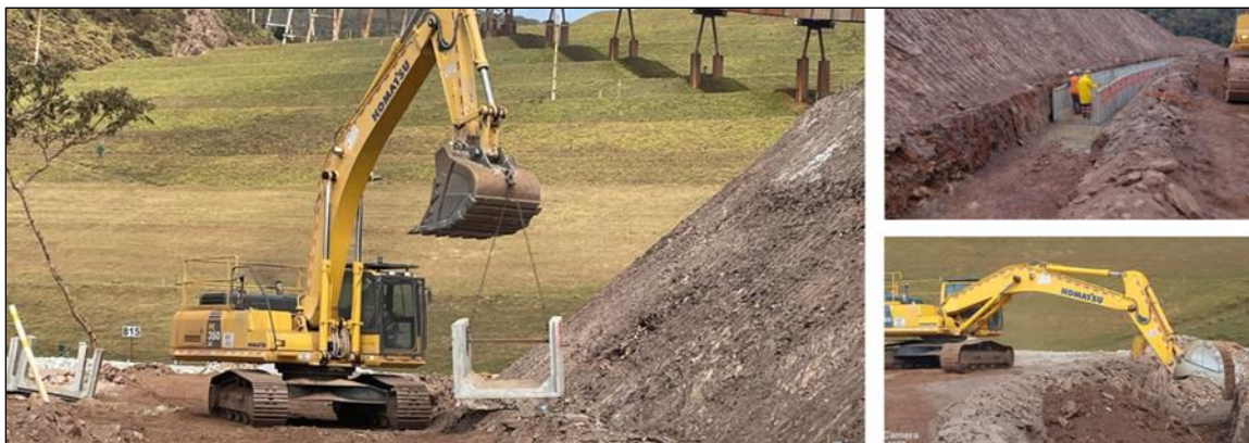
Fotos 5, 6 e 7 – Implantação dos canais superficiais
