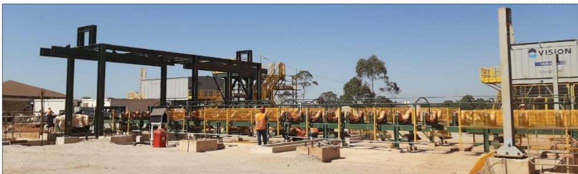
Foto 24 - Montagem de módulos CV081 e CV082 e extrator de sucata
