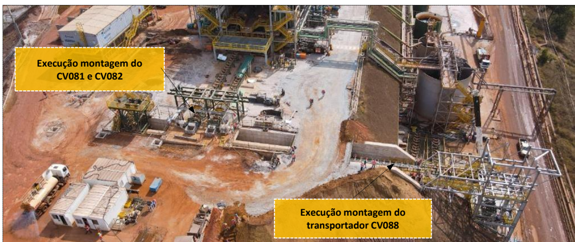
Foto 23 - Montagem dos transportadores CV081, CV082, CV088 e casa de transferência CT088
