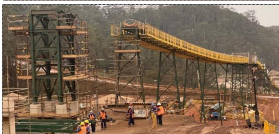
Fotos 36, 37, 38 e 39 – Montagem do transportador CV090
