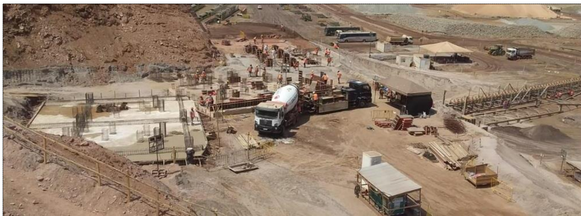
Foto 43: Concretagem de obras civis transportadores CV090, CV097, CV115 e eletrocentro 073
