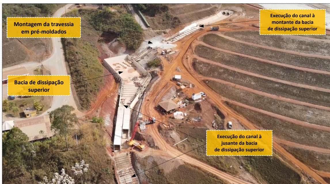
Foto 56 – Vista da execução da bacia de dissipação superior e do canal a montante
