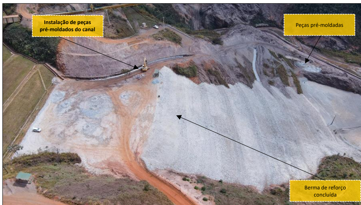
Foto 4 – Drenagem da berma de reforço do barramento principal – visão geral
