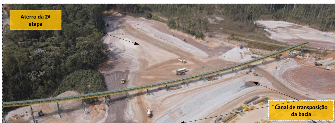
Foto 44: Execução de aterro controlado e canal de drenagem principal da bacia do Chico
