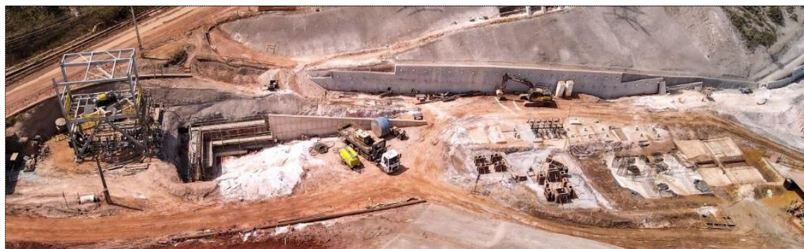
Foto 33 – Montagem do transportador CV090 próximo a contenção do 11CV027 – parte 1
