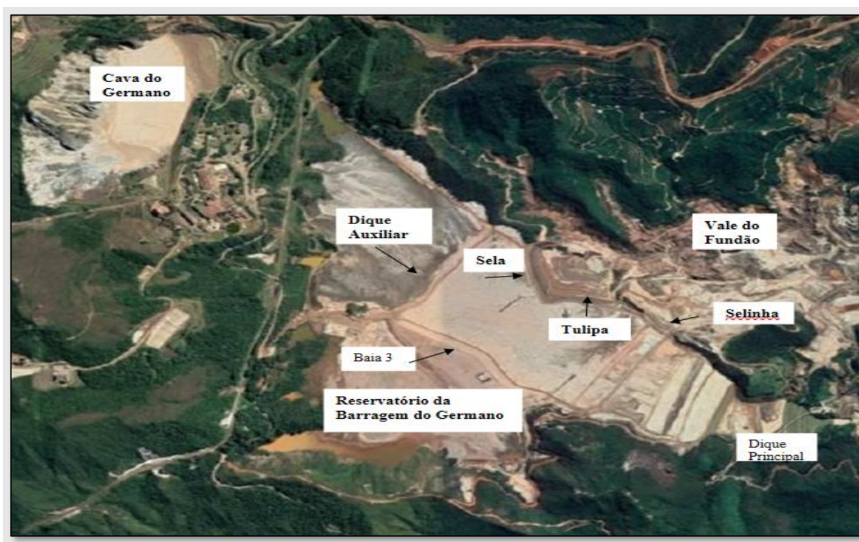
Figura 1 - Vista geral das Barragens da Samarco
