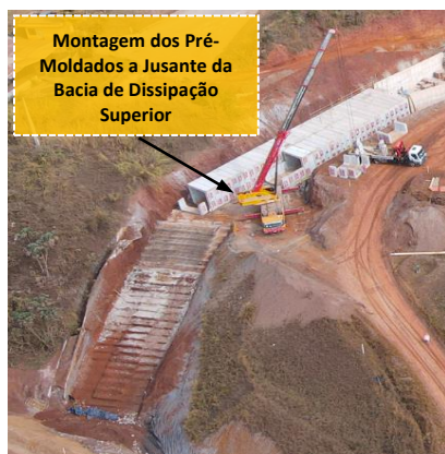
Fotos 54 e 55 - Execução das travessias em pré-moldados e paredes moldadas in loco
