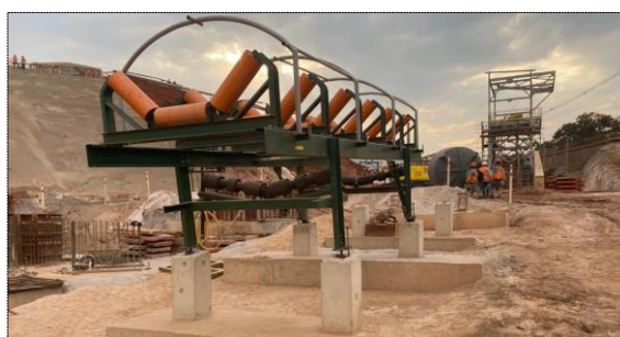
Foto 35 – Montagem do transportador CV090 próximo a contenção do 11CV027 – parte 2
