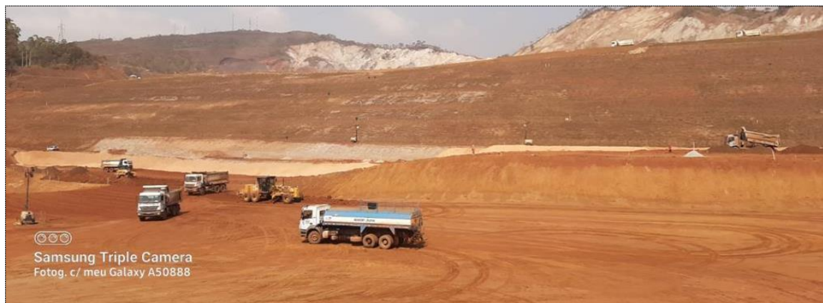
Foto 52: Execução de aterro controlado no pé da Cava do Germano
