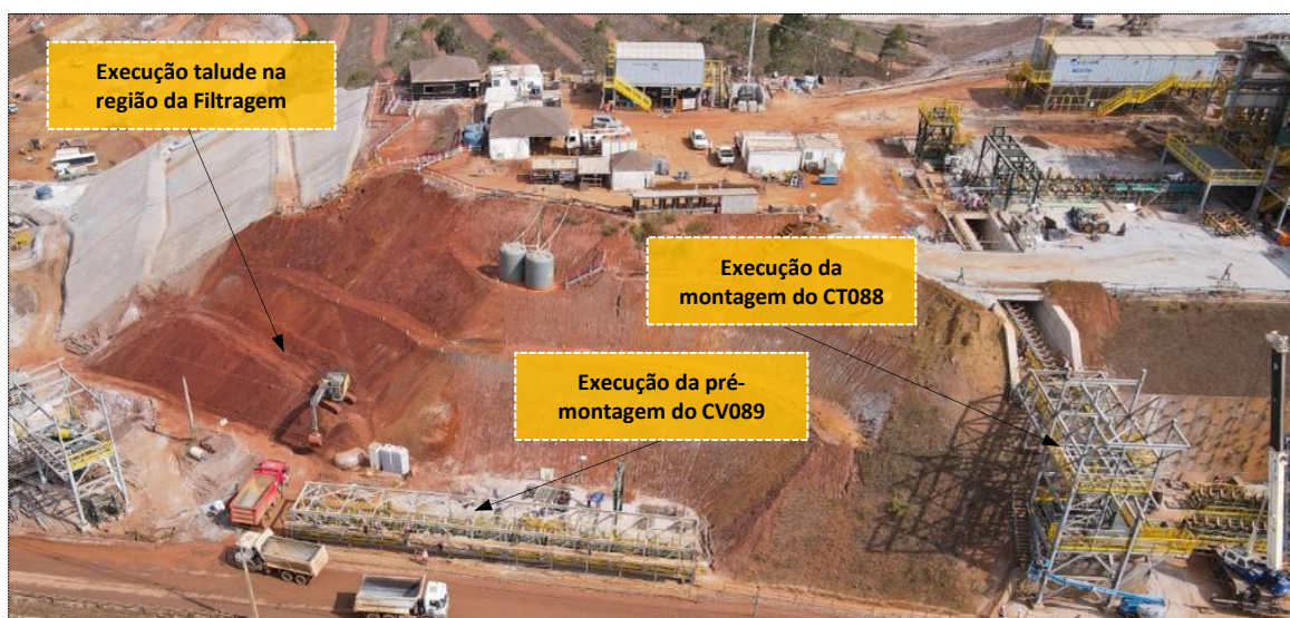
Foto 26 - Pré-montagem do transportador CV089, montagem do CV088 e casa de transferência CT088
