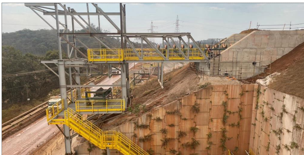
Foto 29 - Montagem da casa de transferência do CT088
