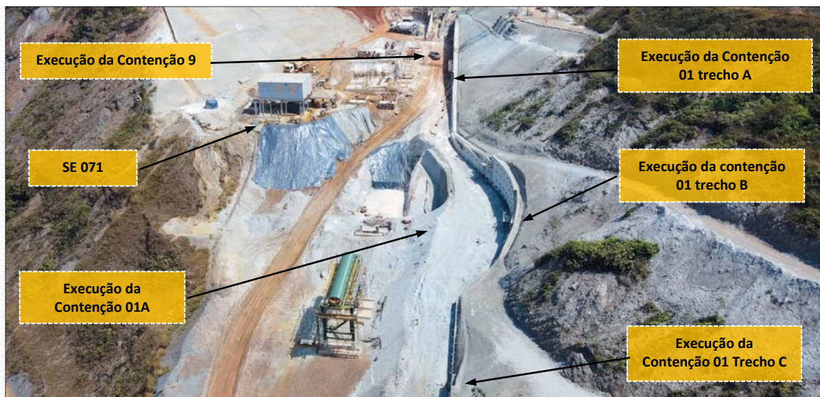
Foto 47: Execução da contenção 01 trechos A, B e C e contenção 01A do transportador CV090
