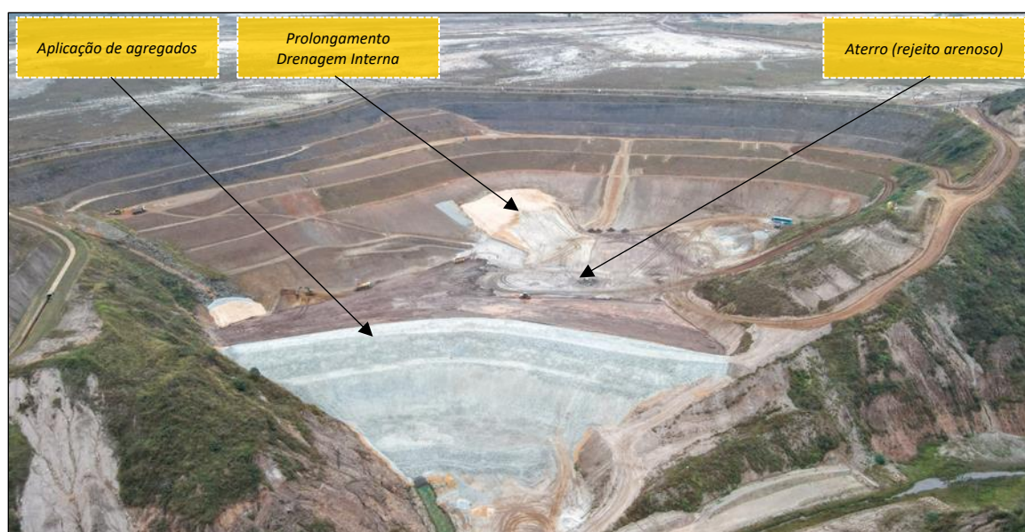
Foto 15 – Visão geral das obras
