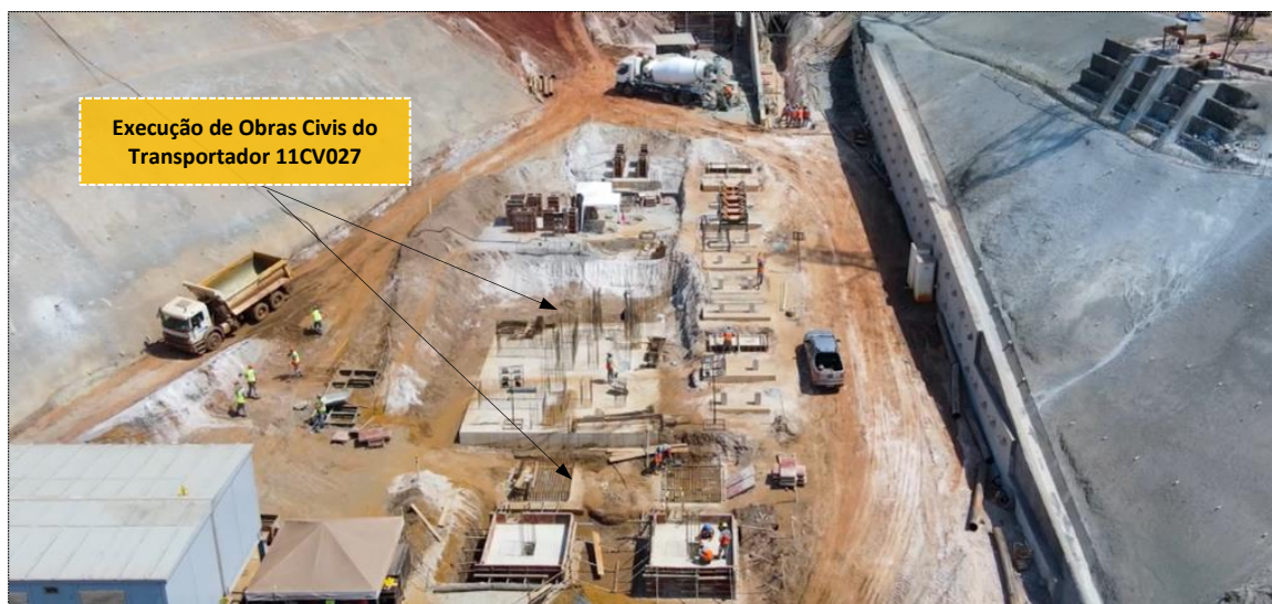
Foto 31 – Execução das obras cíveis do transportador 11CV027
