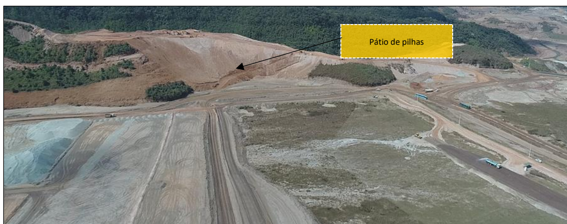
Foto 21 – Escavação do pátio de pilhas
