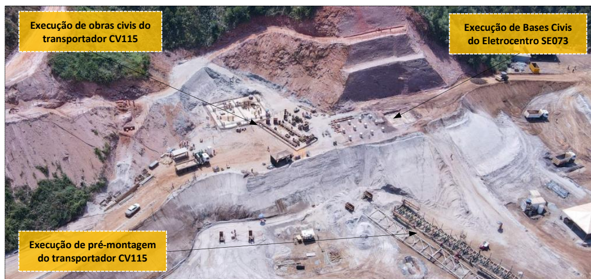
Foto 42: Execução de obras civis transportadores CV090, CV097, CV115 e eletrocentro 073
