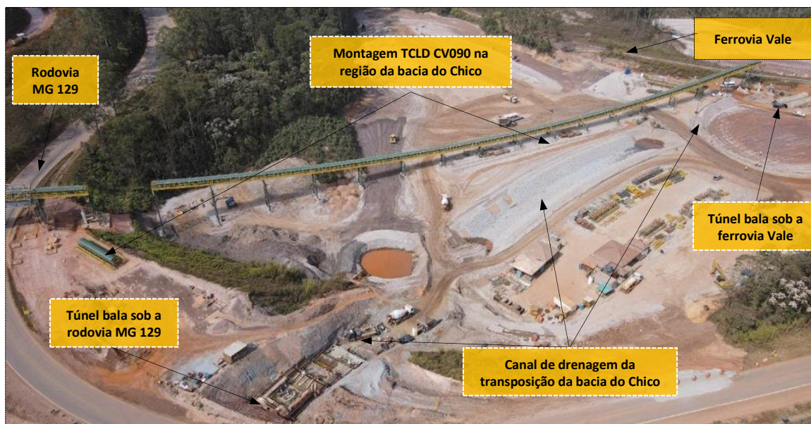
Foto 40 – Montagem do transportador CV090 na região da bacia do Chico
