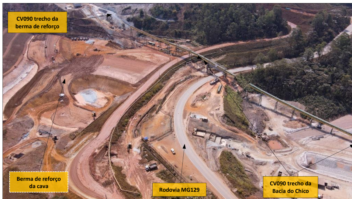
Foto 34 – Vista da montagem do TCLD 53CV090 nas regiões da berma e bacia do Chico
