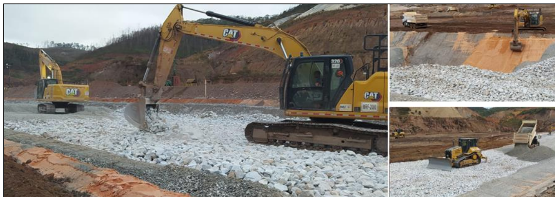
Fotos 9, 10 e 11 – Implantação dos ramais de drenagem (principal e secundários)
