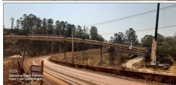
Fotos 36, 37, 38 e 39 – Montagem do transportador CV090
