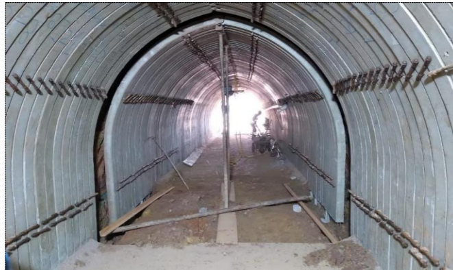
Foto 46: Execução do túnel bala 1 sob a ferrovia Vale na região da bacia do Chico
