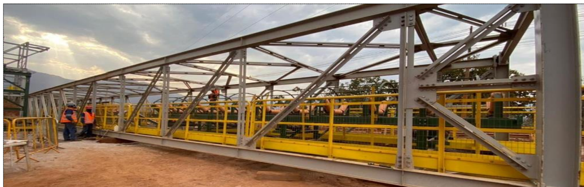
Foto 28 – Pré-montagem do CV089
