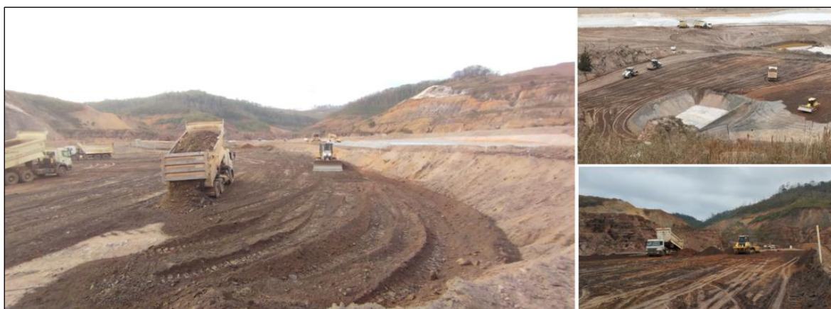
Fotos 12, 13 e 14 – Execução do aterro controlado
