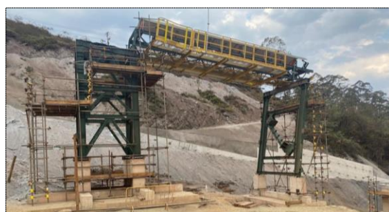
Foto 35 – Montagem do transportador CV090 próximo a contenção do 11CV027 – parte 2
