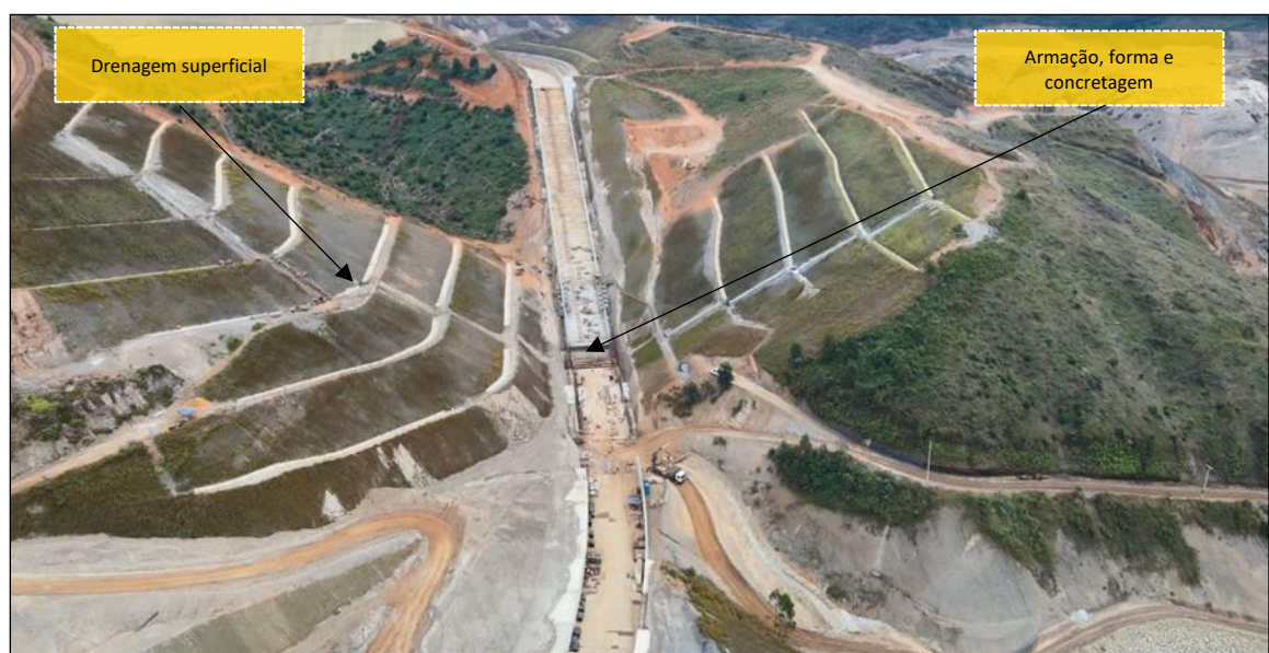
Foto 2 – Vista das obras no setor 3
