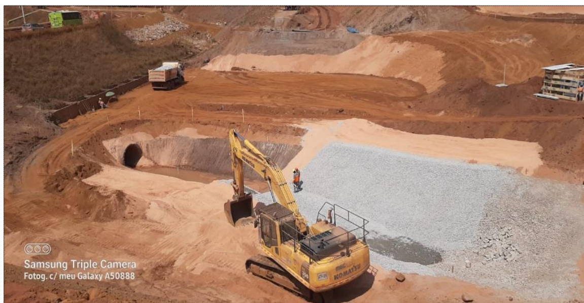
Foto 53: Execução de serviços de limpeza e drenagem no Pé da Cava do Germano
