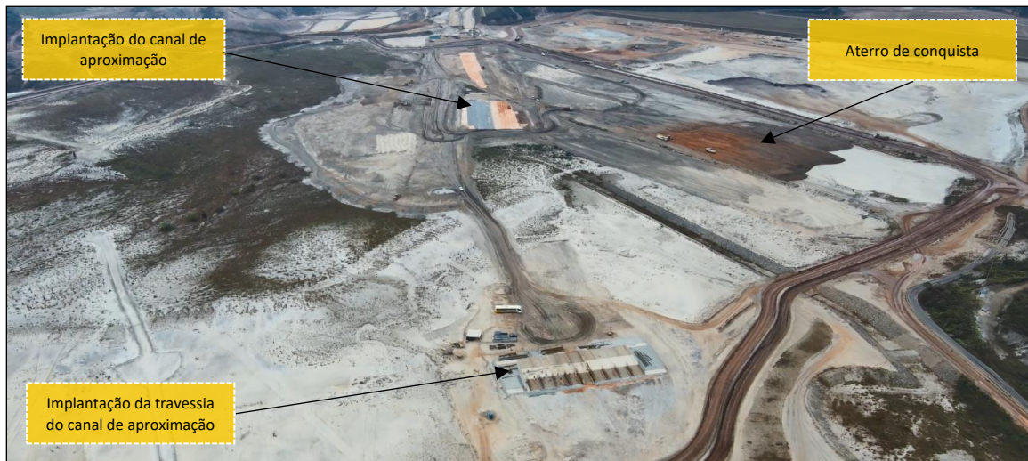
Foto 22 – Implantação do canal de aproximação e travessia de veículos
