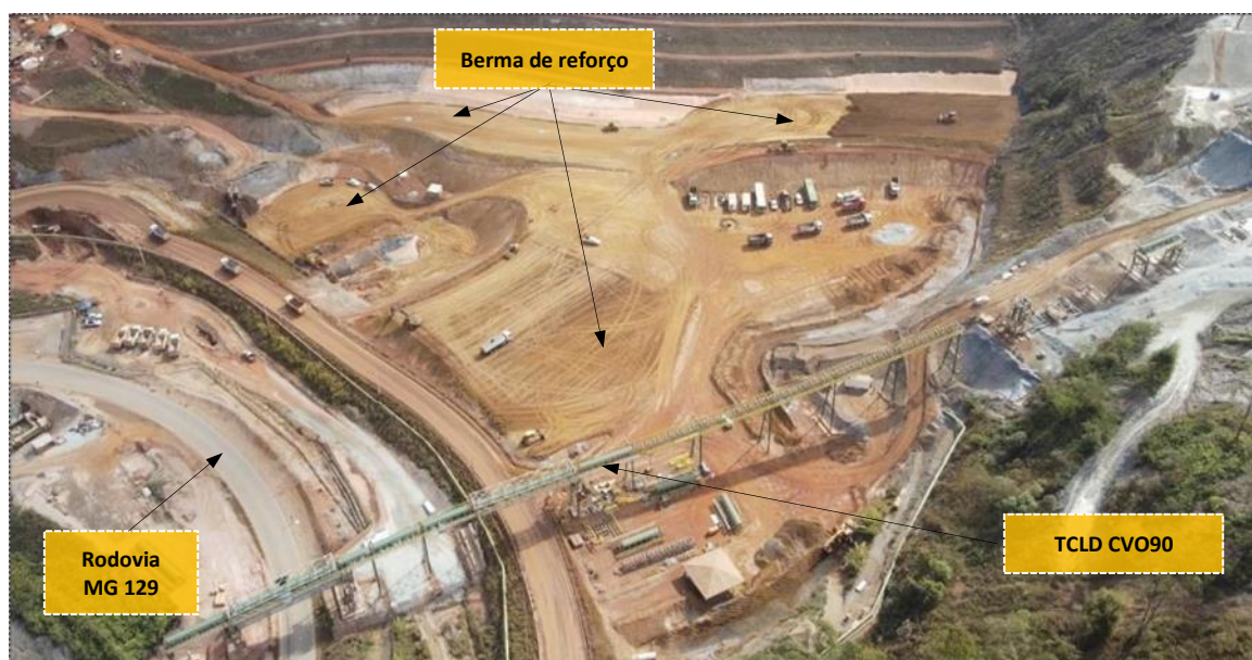
Foto 50: Execução de limpeza e aterro controlado da berma no pé da Cava de Germano
