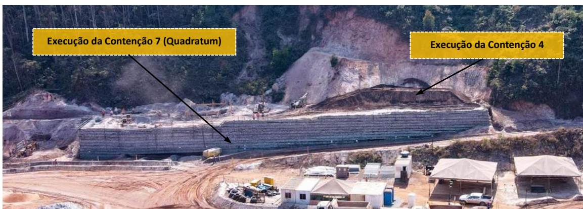
Foto 48: Execução da contenção 4 do transportador CV090 acima da contenção 7 (Quadratum)
