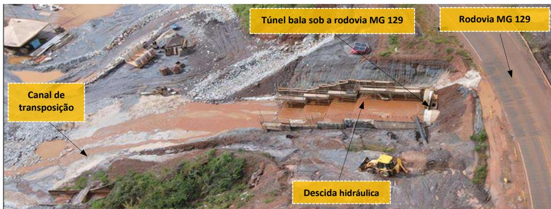
Foto 36: Descidas hidráulicas e canais de drenagens (obras em andamento) – Data 04/01/23
