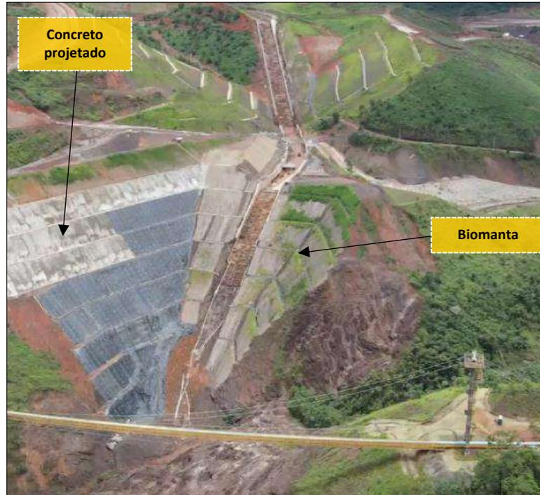
Na Figura 8 a seguir vê-se o emboque do canal principal. Nessa região foi instalada uma ensecadeira para proteção do trecho inicial do canal.
