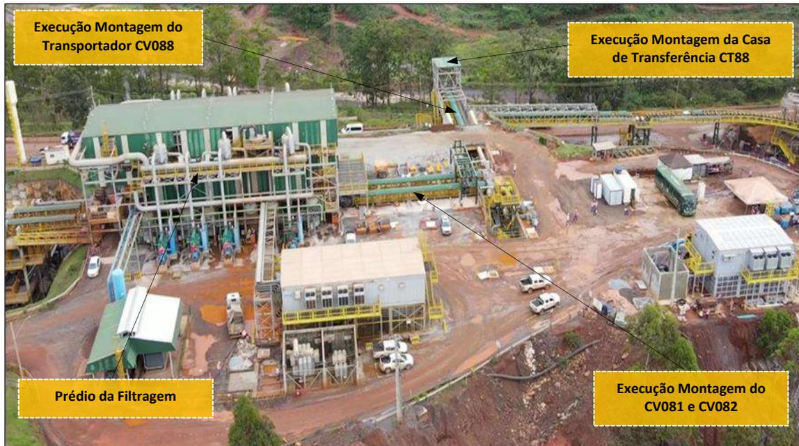
Foto 33: Montagem dos transportadores CV081, CV082, CV088 e casa de transferência CT088 – Data 04/01/23
