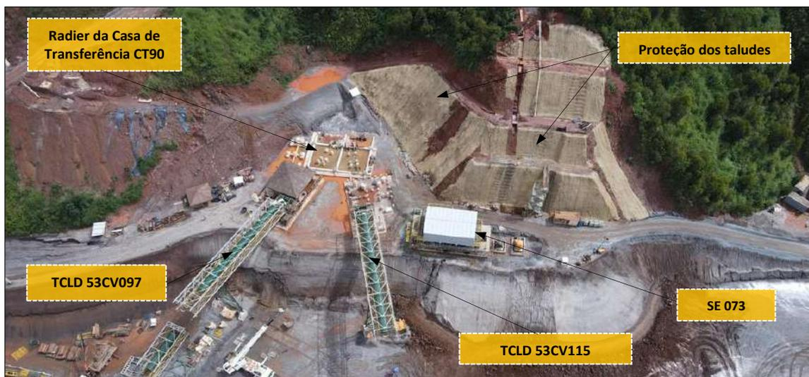
Foto 32: Montagens dos TCDs CV097, CV115 e SE073 na região do Pinheirinho em andamento – Data 04/01/23
