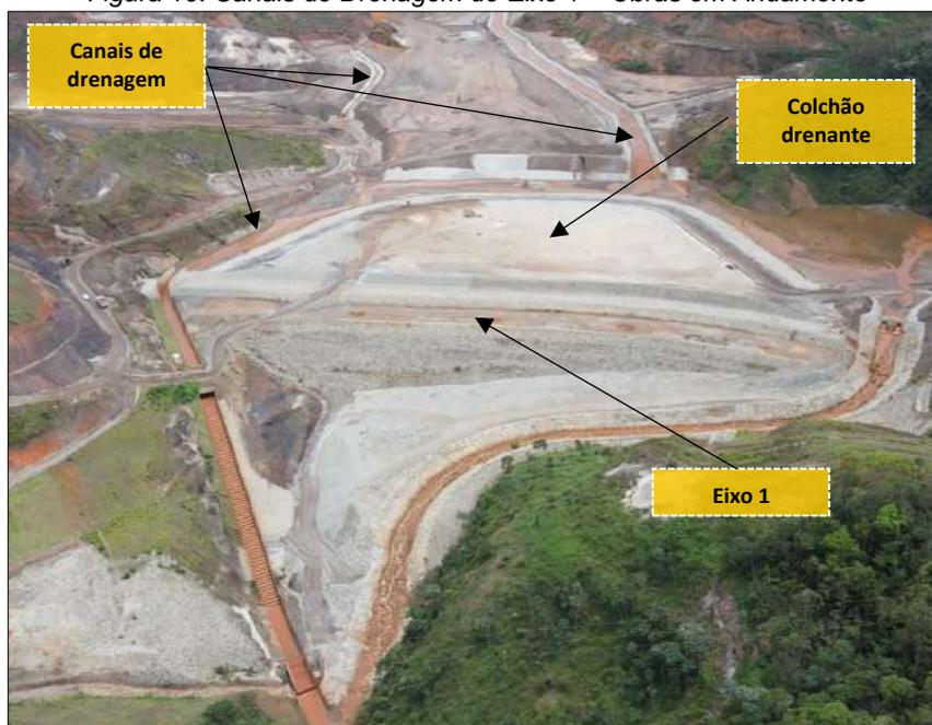
Na região do regrade encontra-se e execução as obras de implantação do sistema de canais superficiais (obras em andamento), conforme pode ser visto na figura 11 a seguir.
