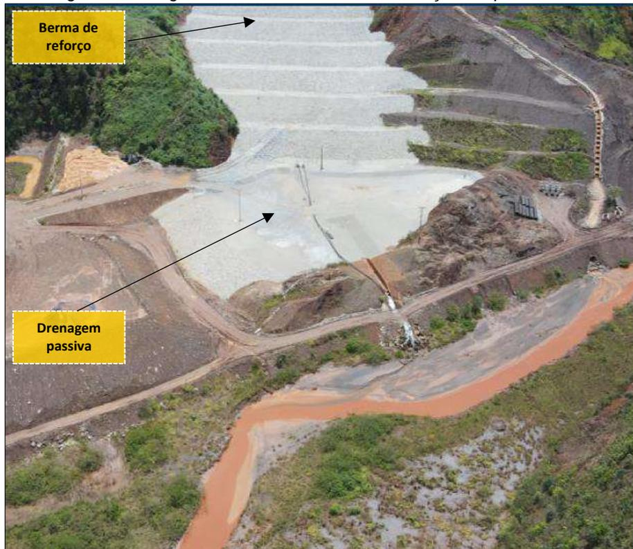
Na figura 5 pode-se observar a saída do sistema de bombeamento na região da drenagem passiva bem como o canal de drenagem da ombreira esquerda.
