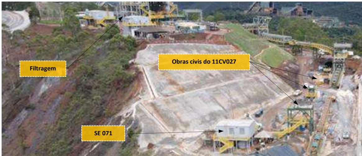
Foto 35: Obras civis e montagem do TCLD 11CV027 em andamento – Data 04/01/23
