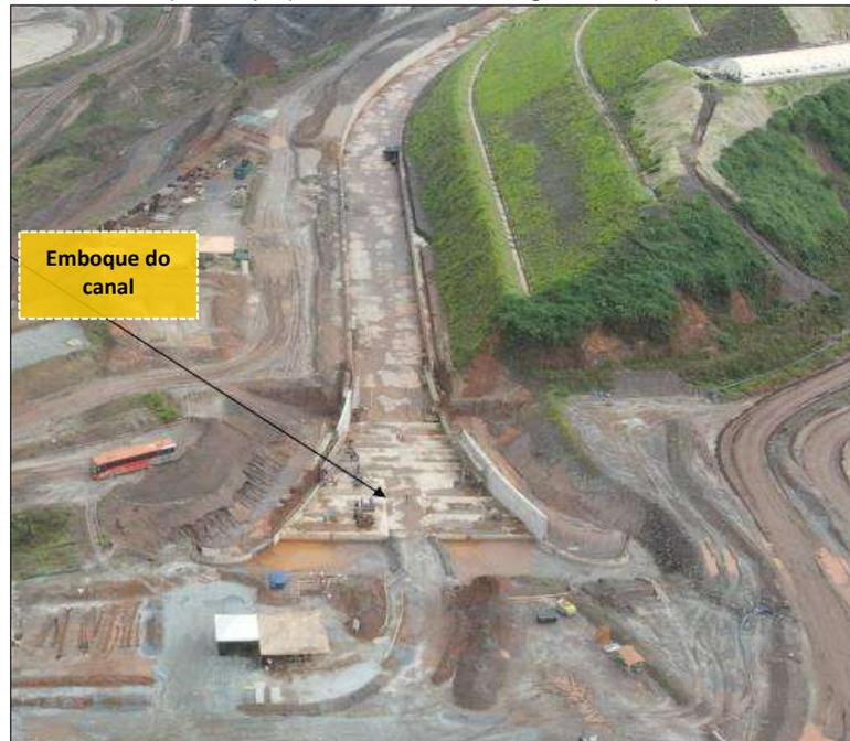
No setor de Sela, Tulipa e Selinha encontra-se em execução a obra do aterro compactado de descaracterização dessas estruturas, em sua etapa inicial. Juntamente com o aterro está prevista a instalação do sistema de drenagem superficial associado. A figura 9 a seguir, apresenta uma vista do aterro em execução. O sistema de drenagem superficial em questão descarregará seu fluxo nos canais já implantados na área a jusante (de Selinha e do Eixo 1).
