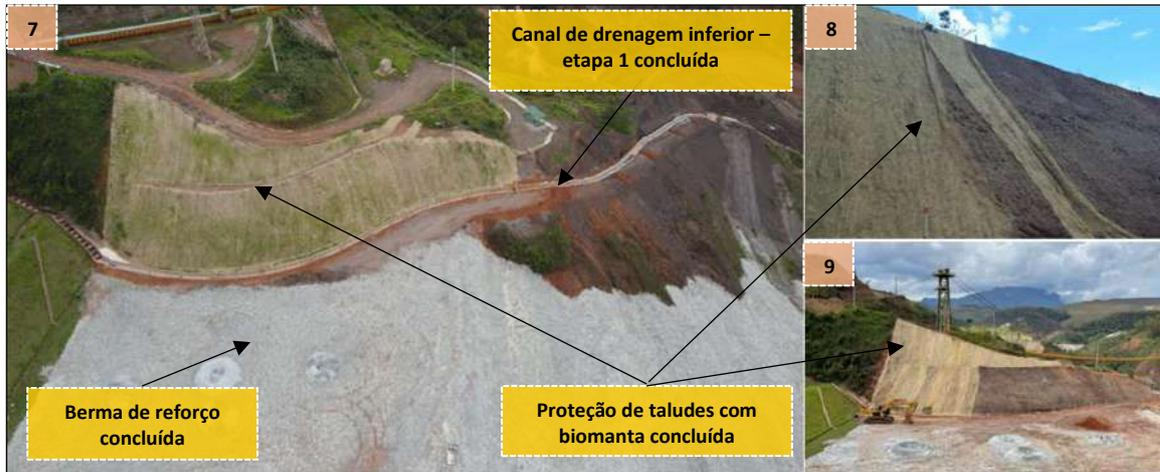
Foto 7: Vista da Berma de Reforço, proteção de taludes e canal drenagem ombreira esquerda – Data 04/01/23
