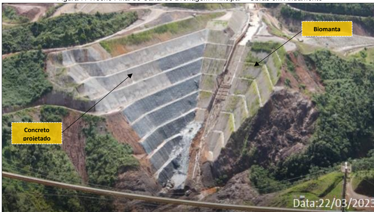
Figura 7: Trecho Final do Canal de Drenagem Principal – Obras em Andamento
