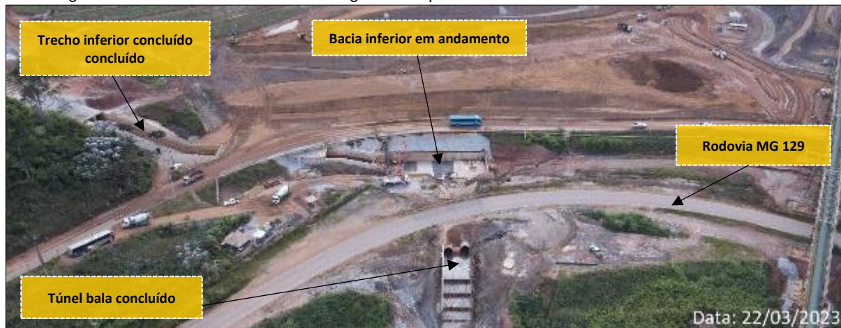
Figura 13: Vista Geral - Canal de Drenagem Principal da Cava do Germano – Obras em Andamento
