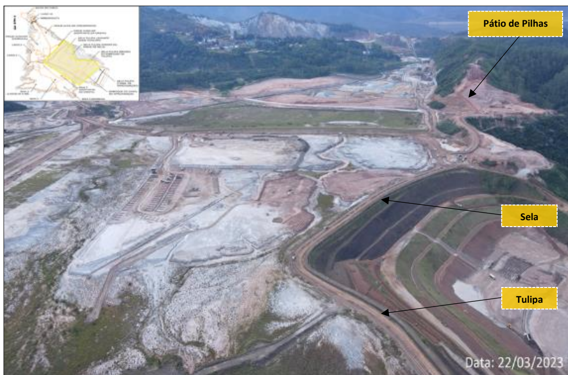
Foto 16: Região de Sela / Tulipa (Obras em Andamento)
