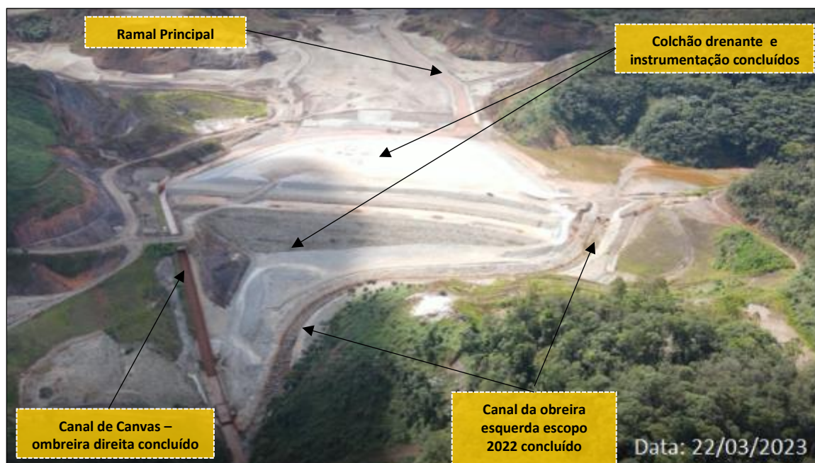
Foto 7: Vista do Eixo 1 Etapa 1 (Obras Concluídas)
