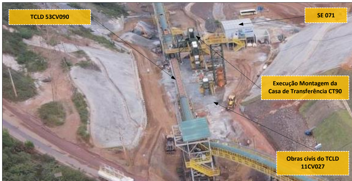
Foto 27: Obras Cíveis do TCLD 11CV027 e Montagem da CT090
