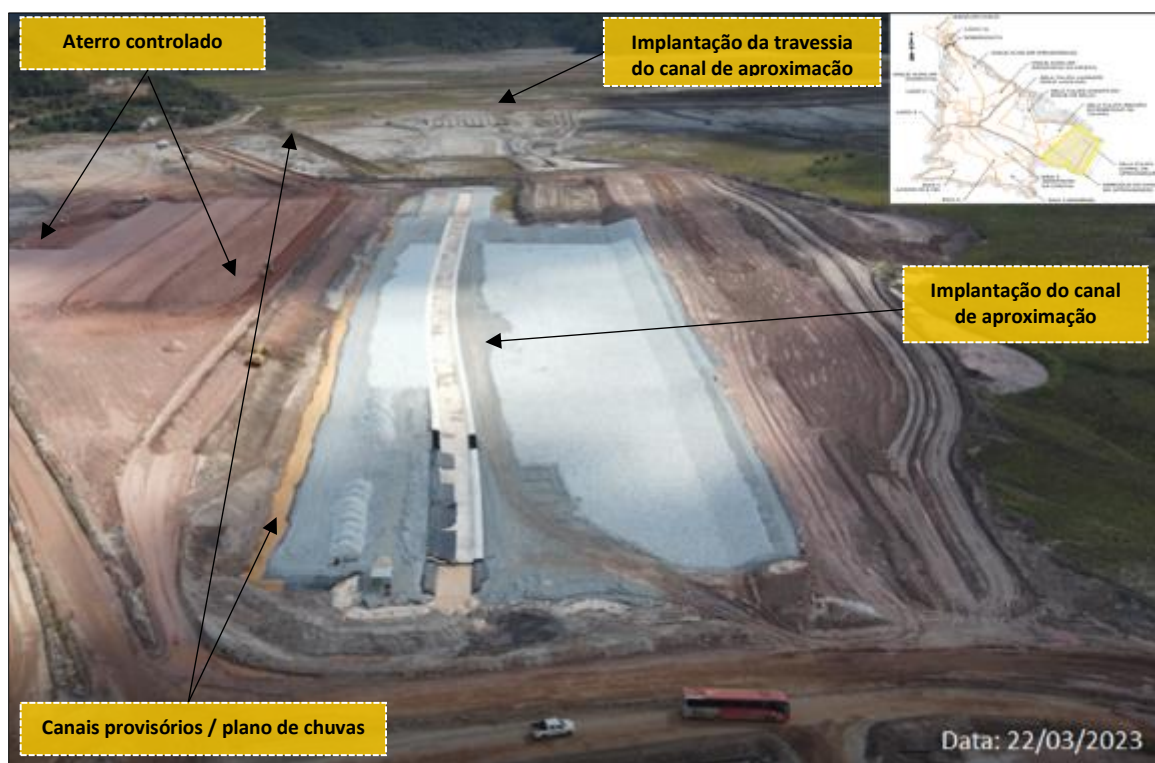
Foto 14: Canal de Aproximação (Obras em Andamento)
