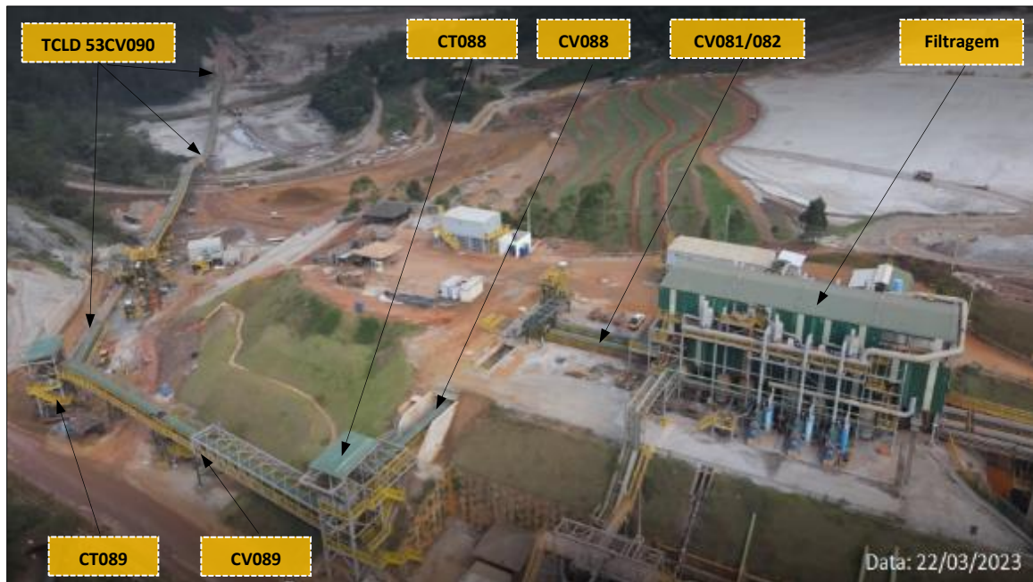
Foto 17: Montagem dos TCLDs 081,082, 088, 089 e 090 na Região da Filtragem / Cava
