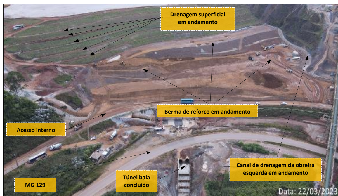
Foto 22: Berma de Reforço da Cava do Germano e Drenagens Superficiais (Obras em Andamento)
