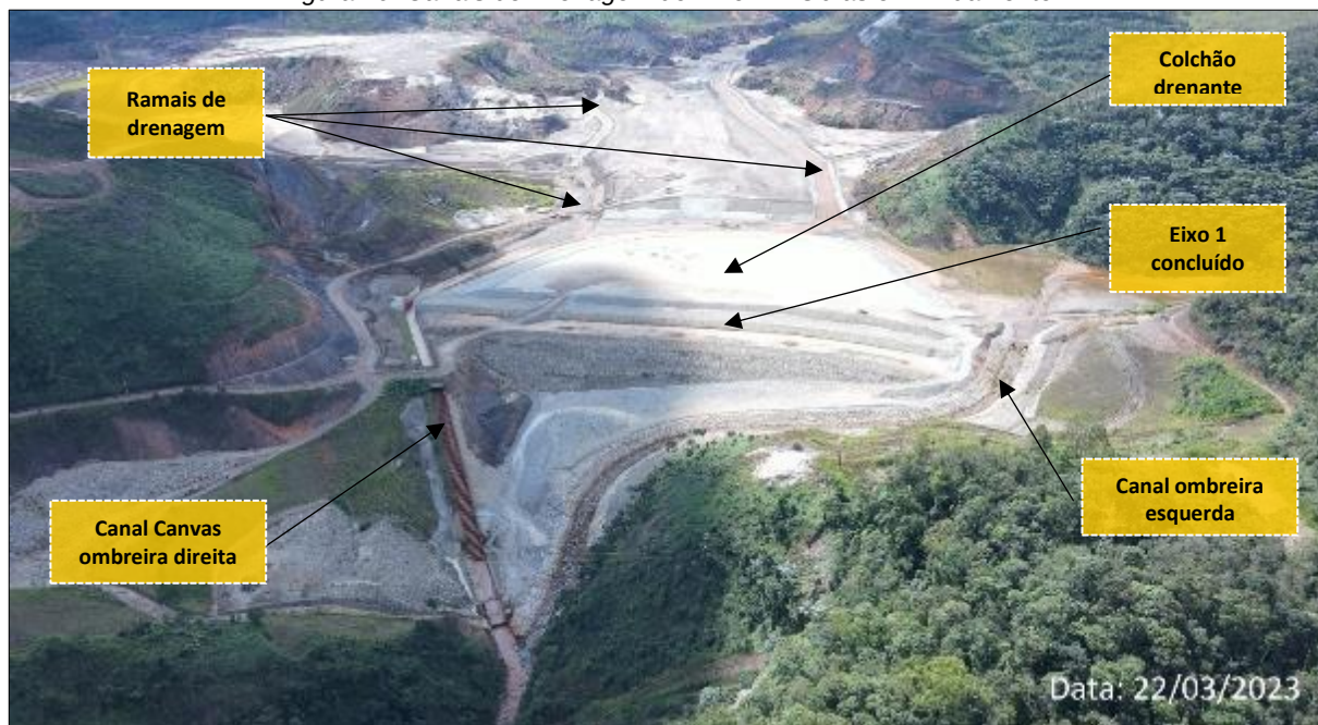
Figura 10: Canais de Drenagem do Eixo 1 – Obras em Andamento
