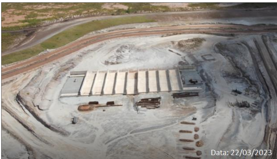
Foto 15: Travessia de Veículos (Obras em Andamento)
