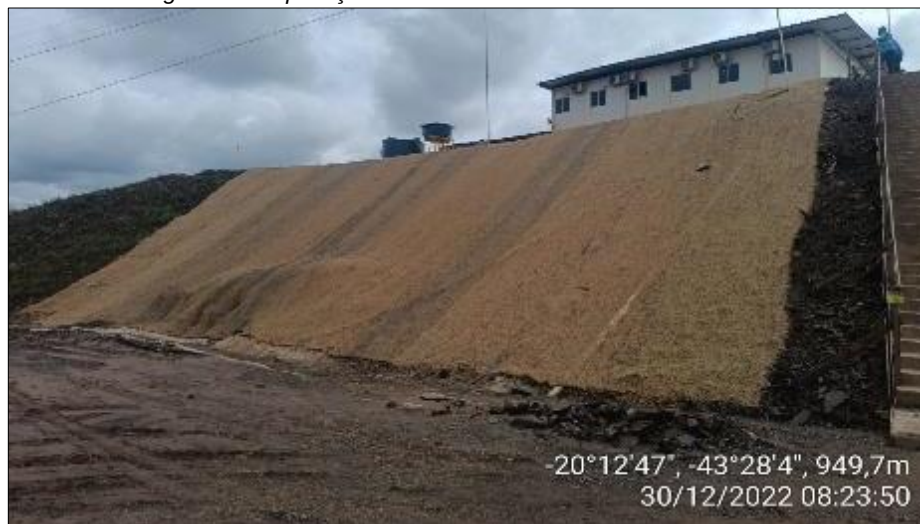
Figura 112: Aplicação de Biomanta no Pátio das Contratadas
