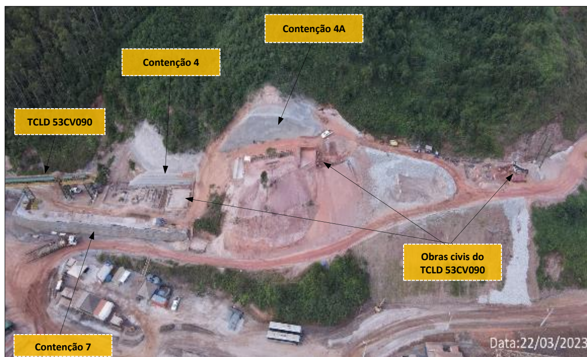
Foto 20: Montagem do TLD 53CV090 e Obras Civis na Região do Pinheirinho Em Andamento
