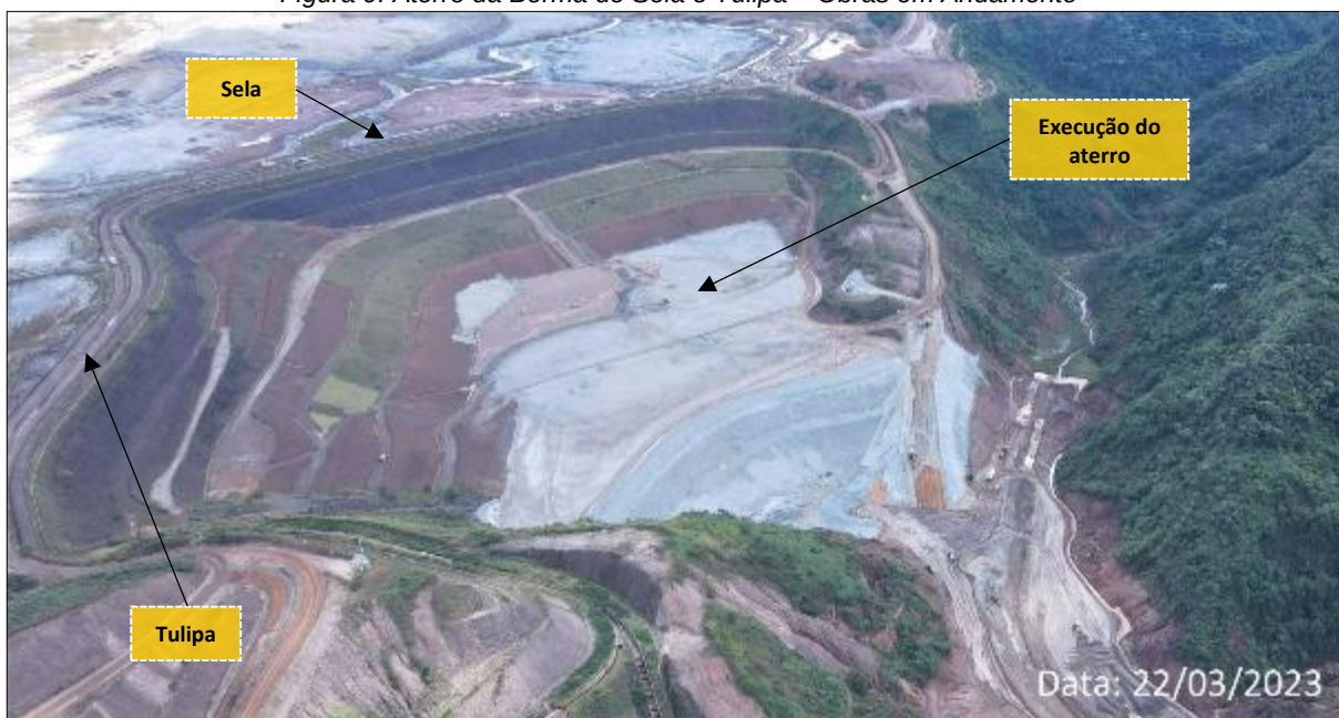
Figura 9: Aterro da Berma de Sela e Tulipa – Obras em Andamento
