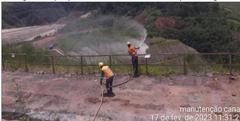
Figura 113: Aplicação de Hidrossemeadura no Canal Principal da Barragem
