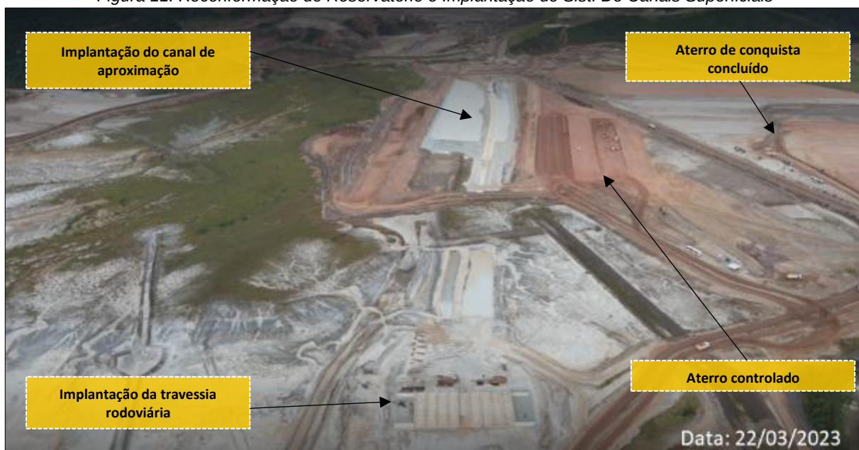
Figura 11: Reconformação do Reservatório e Implantação do Sist. De Canais Superficiais
