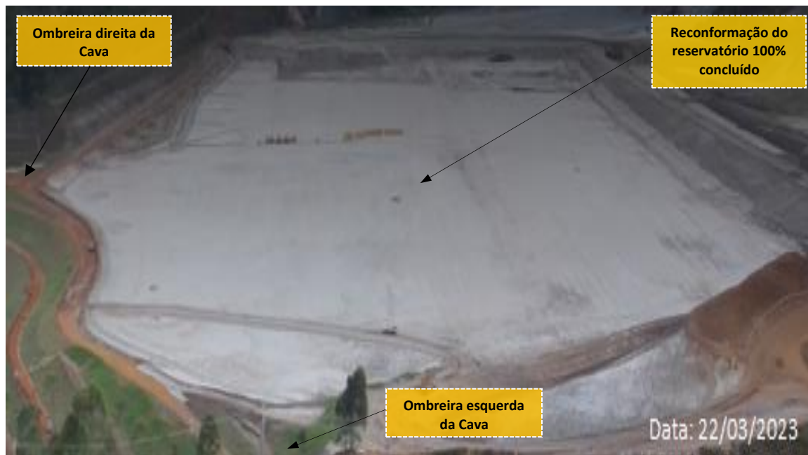
Foto 26: Reconformação da Cava (Obra Concluída)
