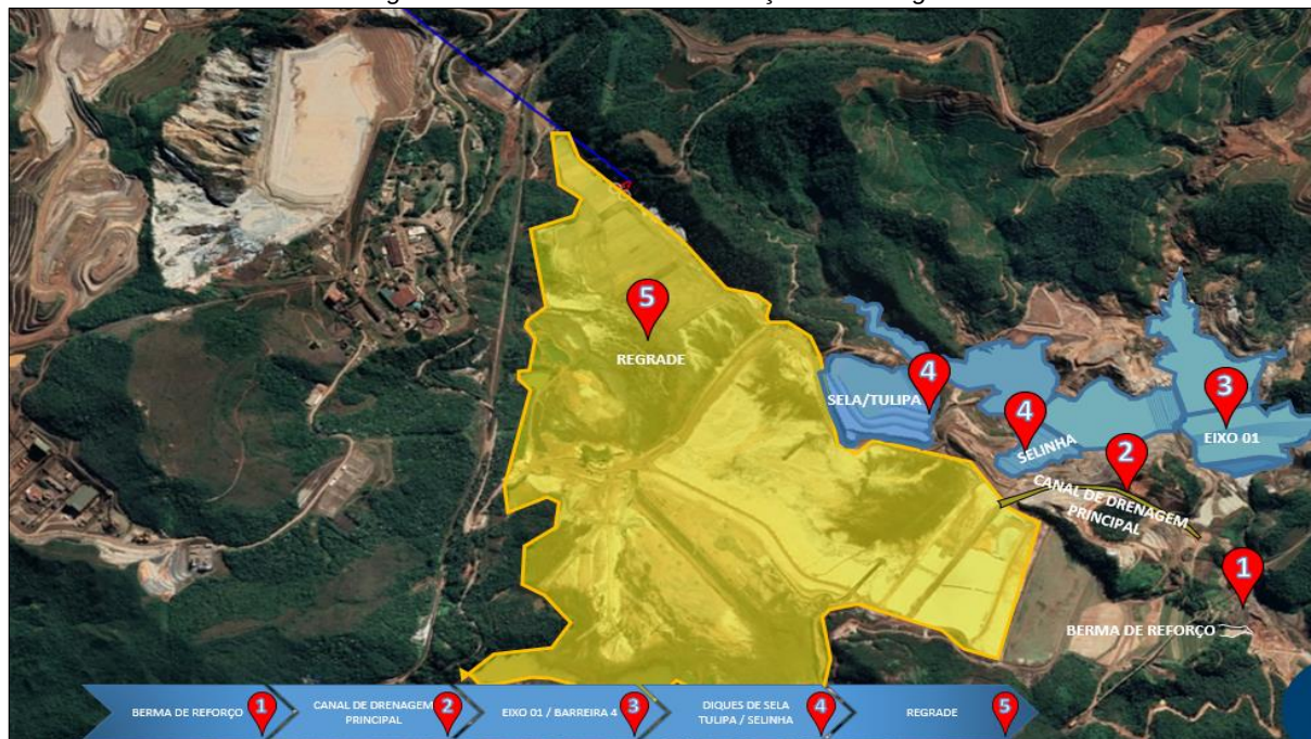
Figura 3: Obras da Descaracterização da Barragem
