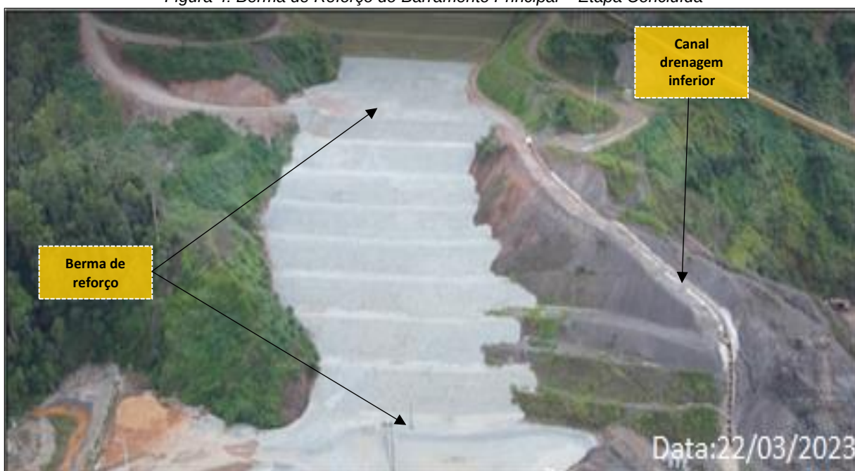
Figura 4: Berma de Reforço do Barramento Principal – Etapa Concluída
