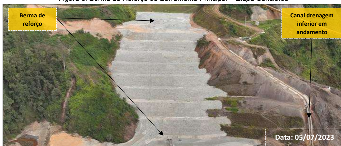
Figura 6: Berma de Reforço do Barramento Principal – Etapa Concluída
