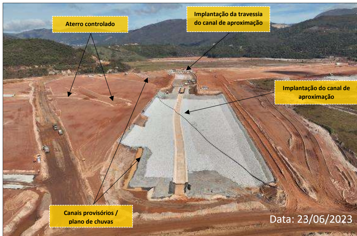
Foto 14: Canal de Aproximação (Obras em Andamento)
