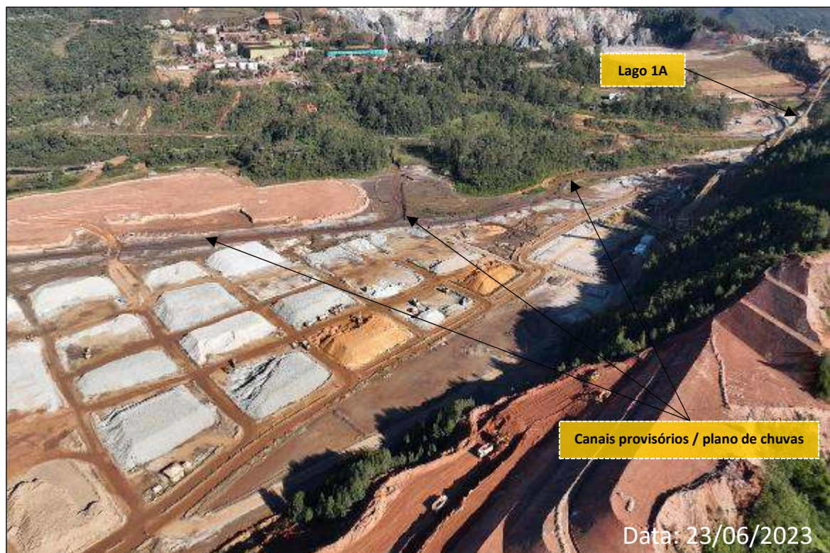
Foto 10: Regiões do Pinheirinho e Lagos 1 e 1A (Etapa 1 de Obras Concluídas)
