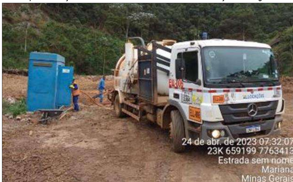
Figura 22: Limpeza e Sucção dos Banheiros Hidráulicos na Frente de Serviço da Barragem do Germano
