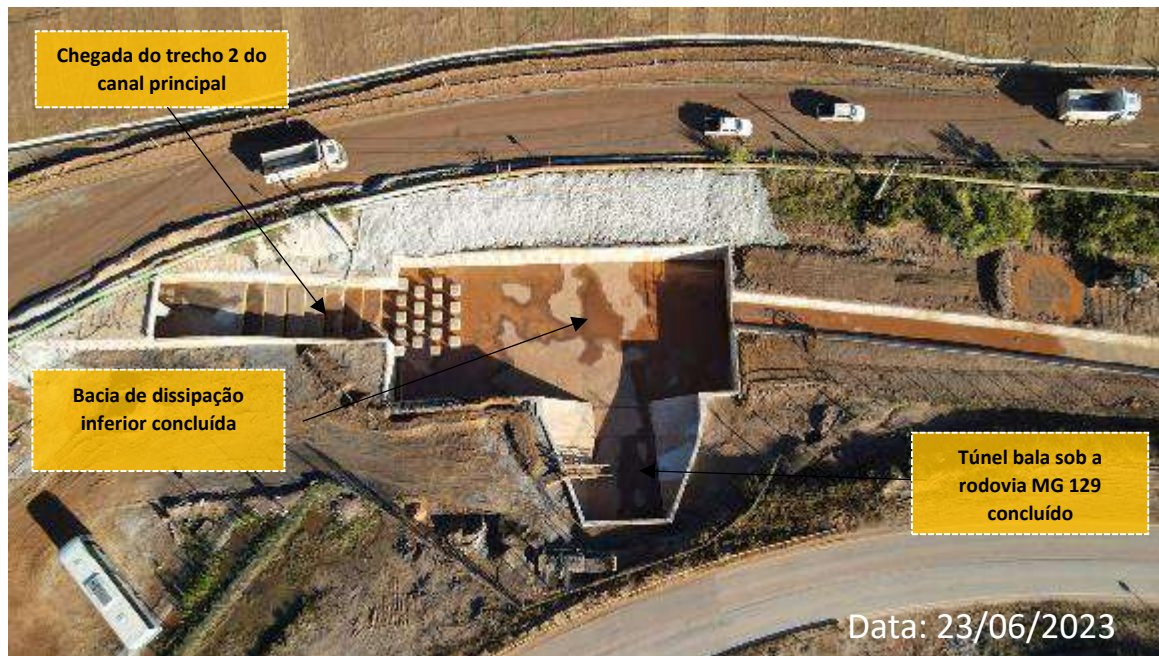
Foto 25: Bacia de Dissipação Inferior (Obras Concluídas)
