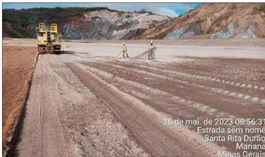
Figura 142: Aplicação de Hidrossemeadura no Regrade da Cava
