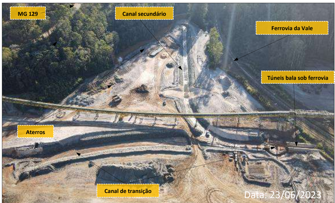
Foto 28: Aterros, Canal de Transposição e Canal Secundário (Obras em Andamento)
