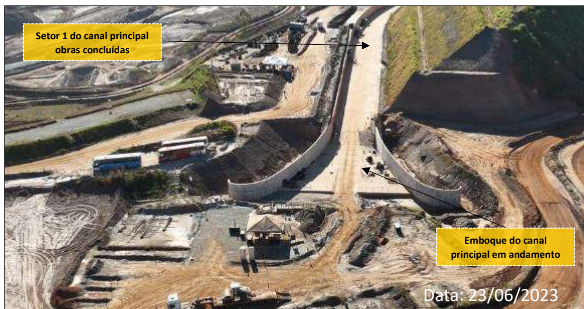
Foto 1: Obras Civas da Estrutura de Concreto do Emboque Em Andamento
