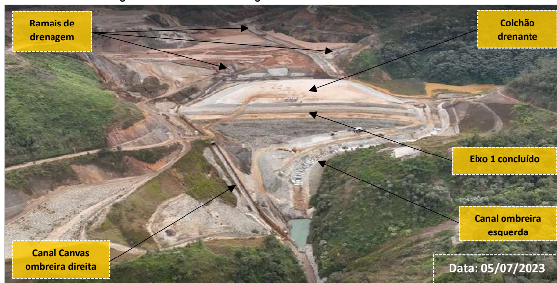
Figura 12: Canais de Drenagem do Eixo 1 – Obras em Andamento
