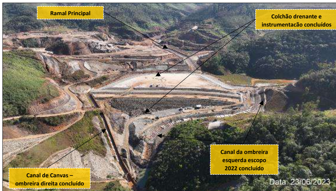
Foto 7: Vista do Eixo 1 Etapa 1 (Obras Concluídas)
