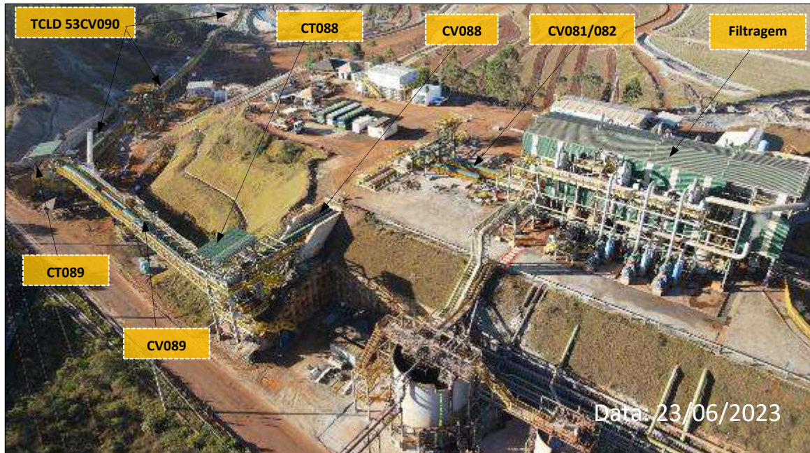
Foto 17: Montagem dos TCLDs 081,082, 088, 089 e 090 na Região da Filtragem / Cava
