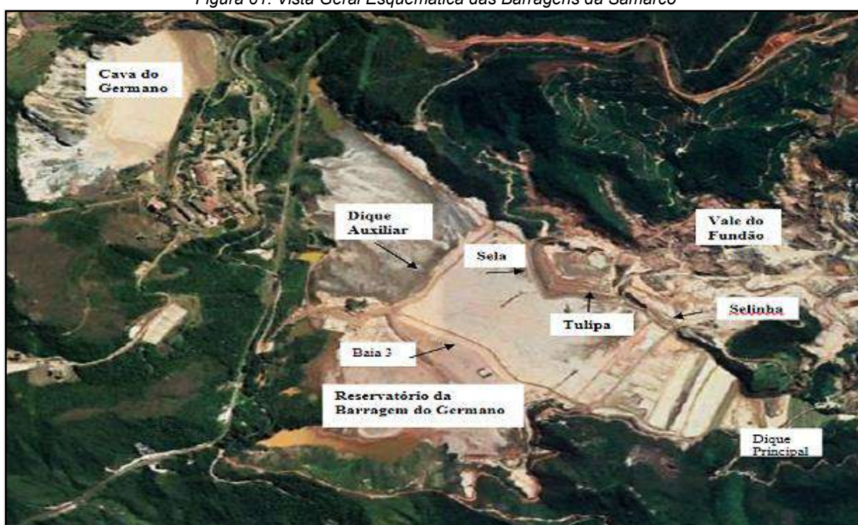
Figura 61: Vista Geral Esquemática das Barragens da Samarco
