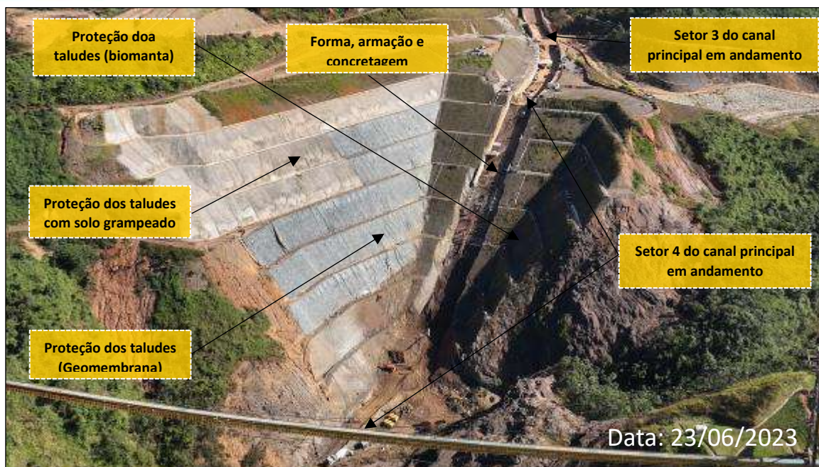
Foto 5: Vista do Setor 4 do Canal Principal – Terraplenagem e Proteções Em Andamento
