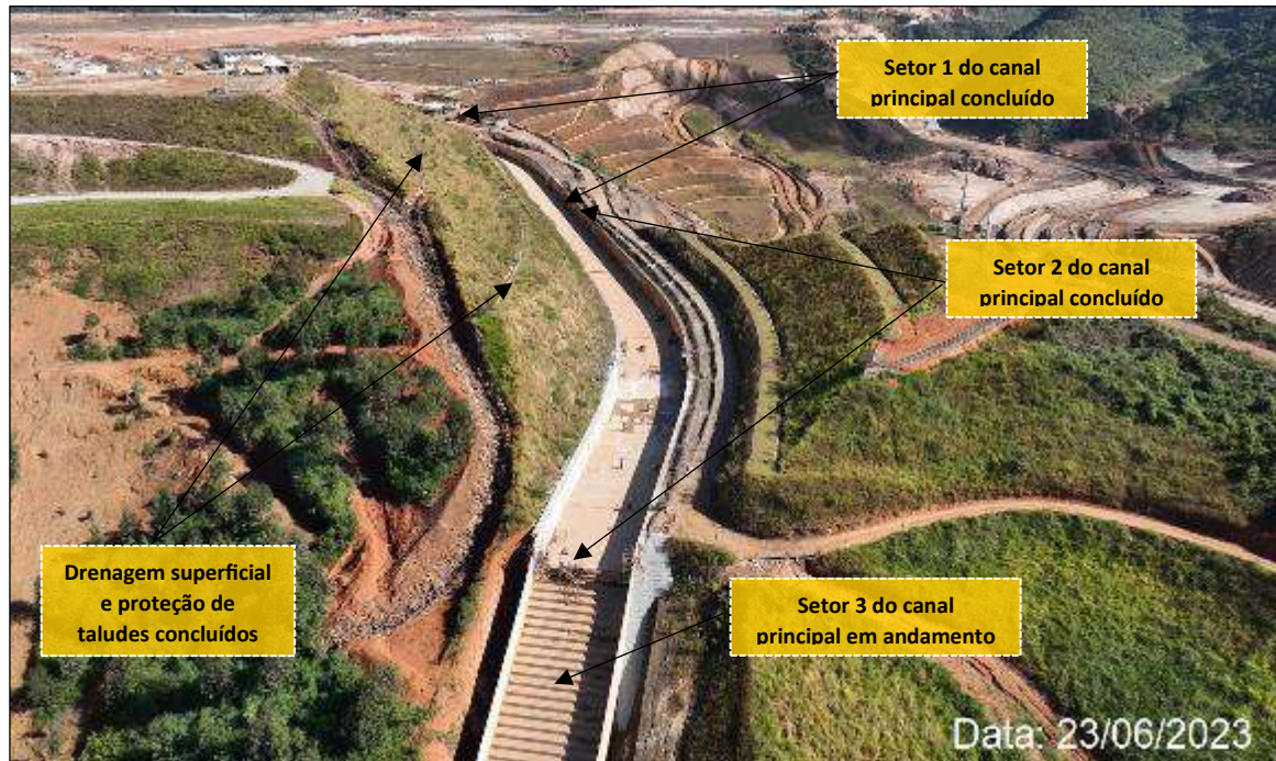
Foto 3: Vista do Setor 2 do Canal Principal (Obras Concluídas)
