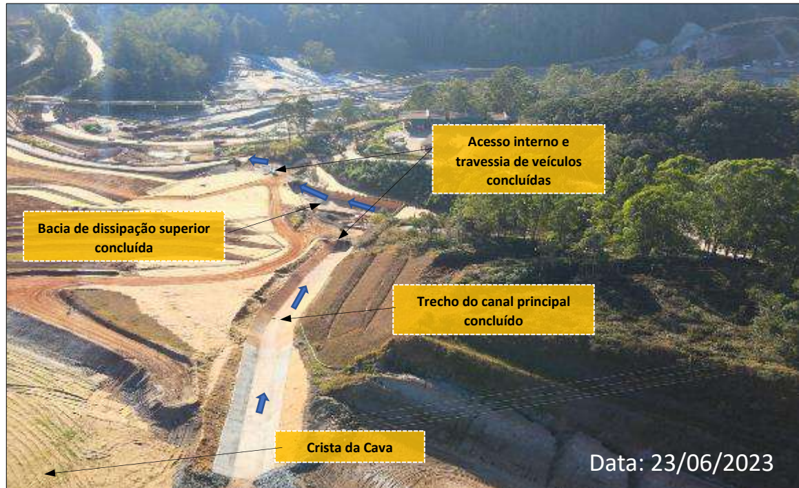
Foto 23: Trecho 1 – Entre o Emboque até a Bacia de Dissipação Superior (Obras Concluídas)
