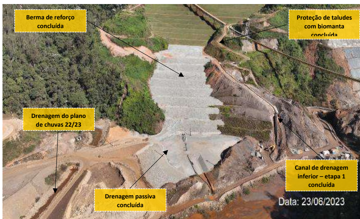
Foto 6: Vista da Berma de Reforço do Barramento Principal (Obras Concluídas)
