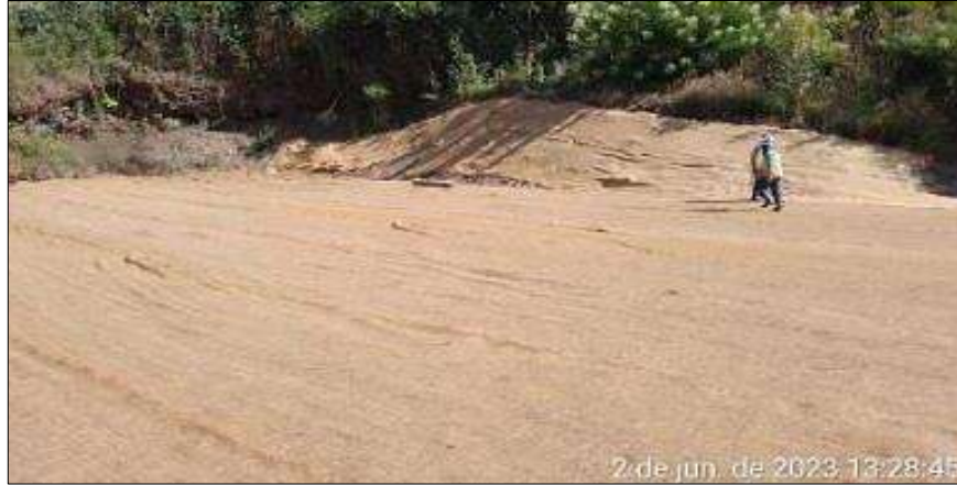
Figura 144: Aplicação de Hidrossemeadura na Ombreira Direita da Cava de Germano
