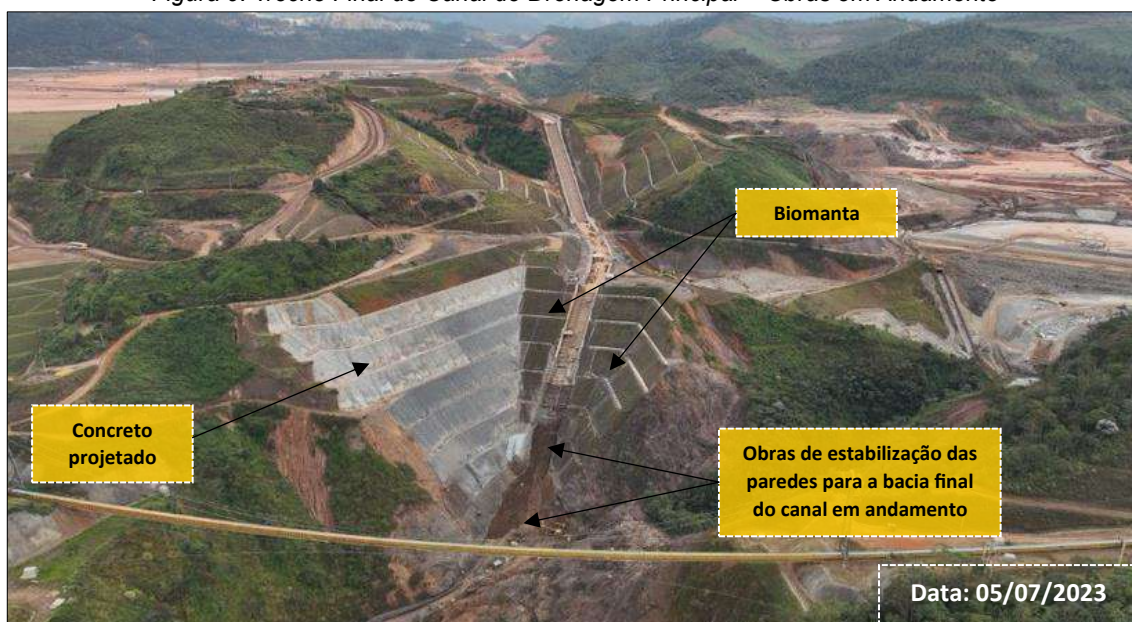
Figura 9: Trecho Final do Canal de Drenagem Principal – Obras em Andamento
