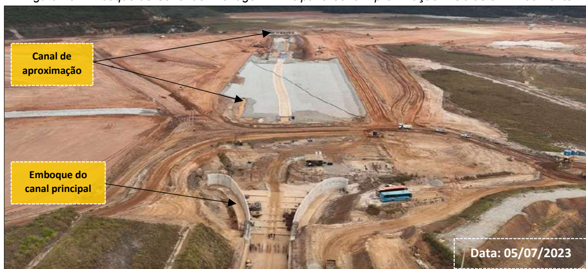
Figura 10: Emboque do Canal de Drenagem Principal e Canal Aproximação – Obras em Andamento
