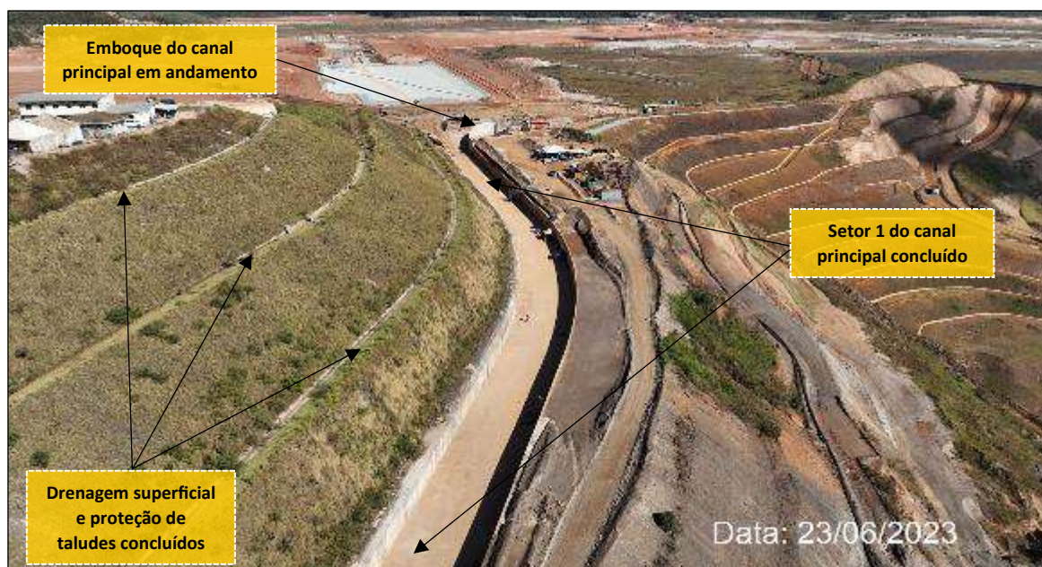
Foto 2: Vista do Setor 1 do Canal Principal (Obras Concluídas)
