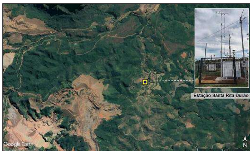
Figura 147: Estação Automática de Monitoramento da Samarco em Santa Rita Durão
