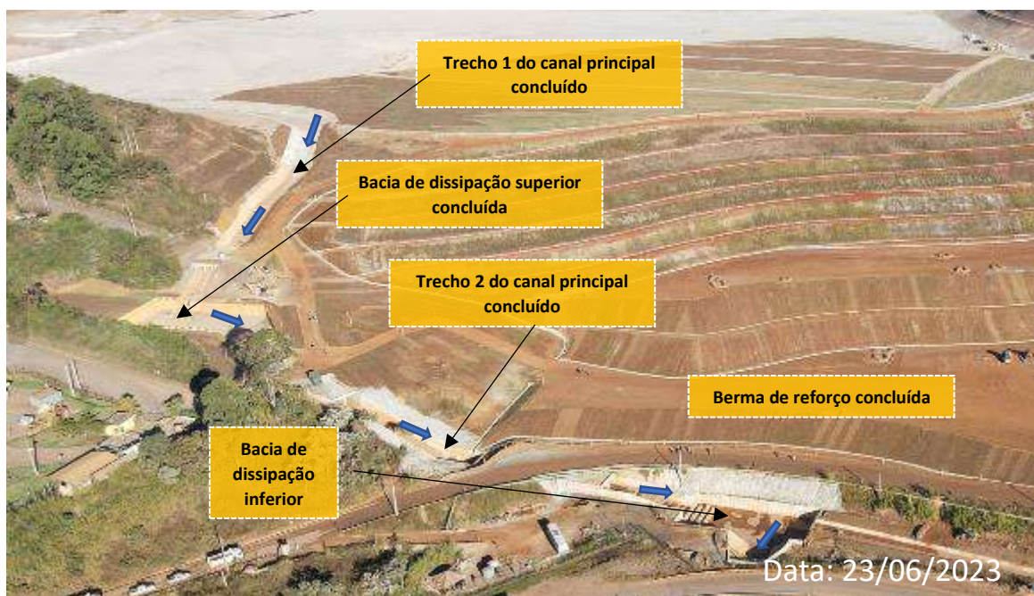
Foto 24: Trecho 2 – Entre Bacias de Dissipação Superior e Dissipação Inferior (Obras Concluídas)
