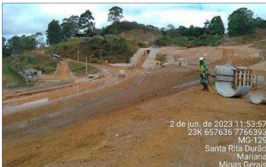
Figura 143: Aplicação de Biomanta na Berma de Reforço no Pé da Cava do Germano
