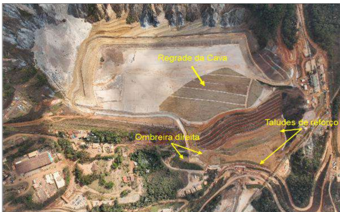
Figura 140: Vista dos Taludes do Canal Principal da Barragem
