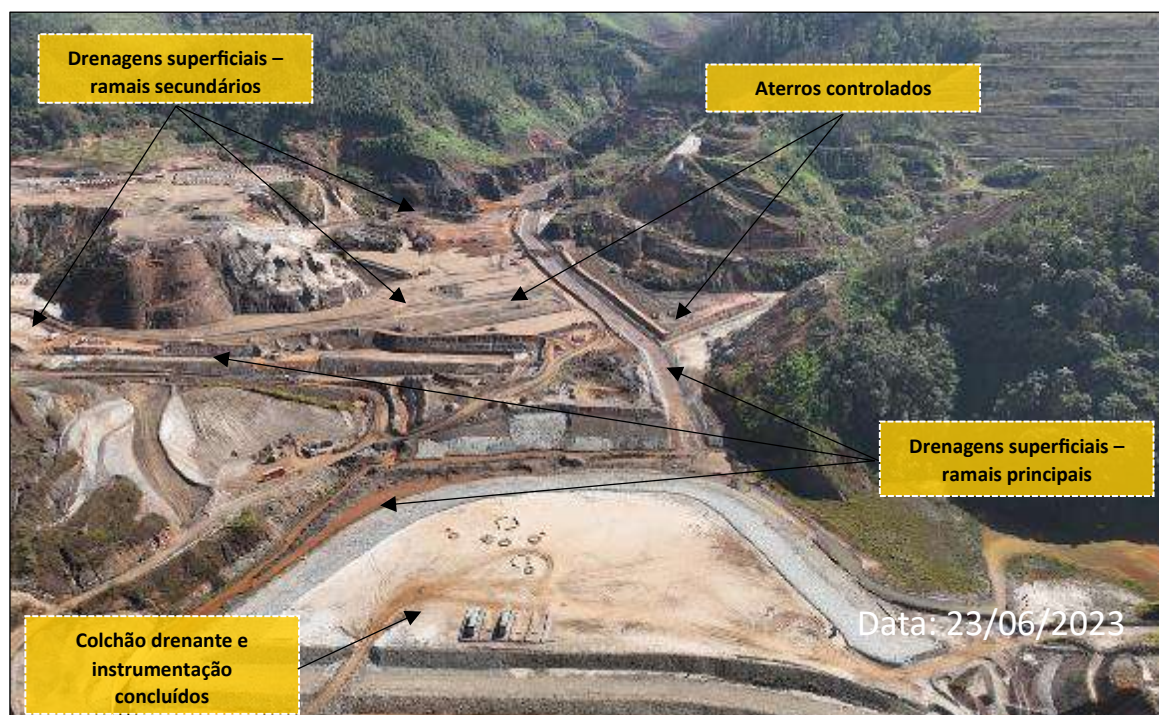
Foto 8: Vista das Obras do Eixo 1 Etapa 2 Em Andamento
