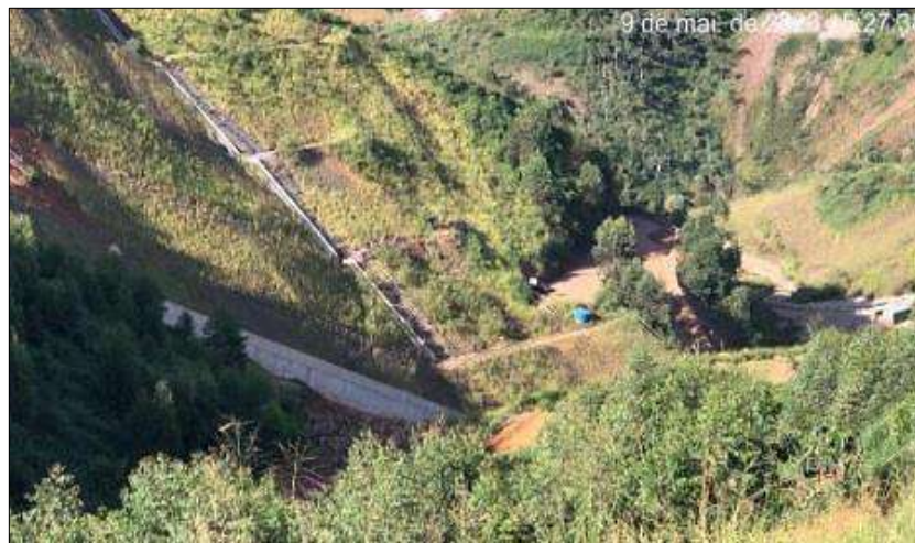
Figura 139: Vista dos Taludes do Canal Principal da Barragem
