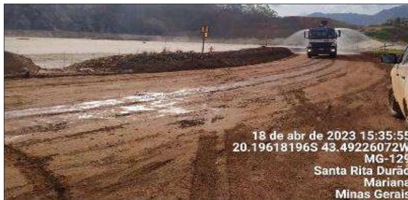
Figura 158: Umectação de Vias – Acesso à Cava de Germano
