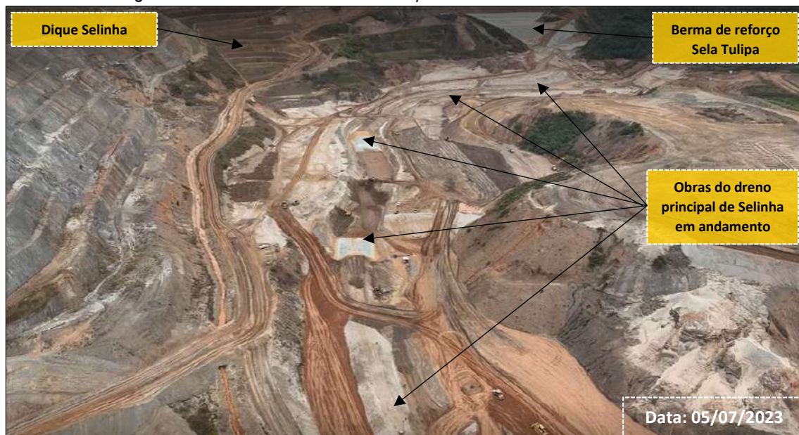
Figura 11: Aterro da Berma de Sela Tulipa e Selinha – Obras em Andamento
