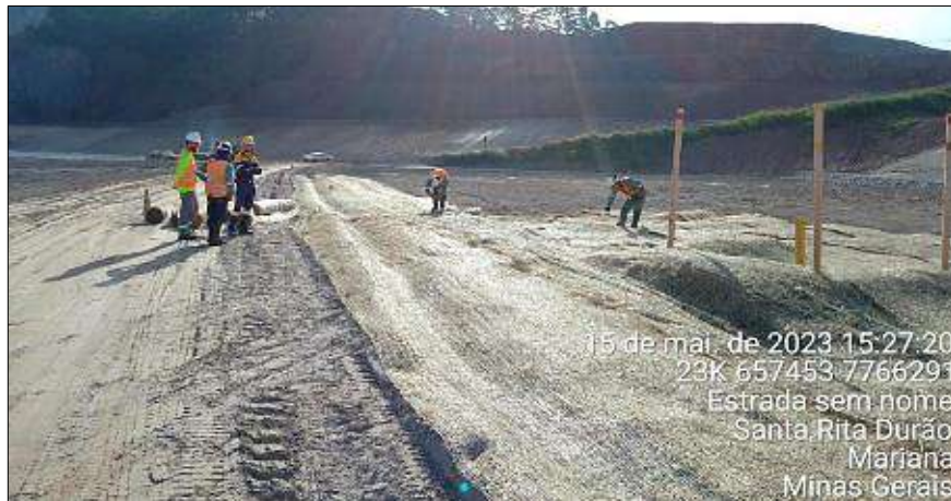
Figura 141: Aplicação de Biomanta no Regarde da Cava
