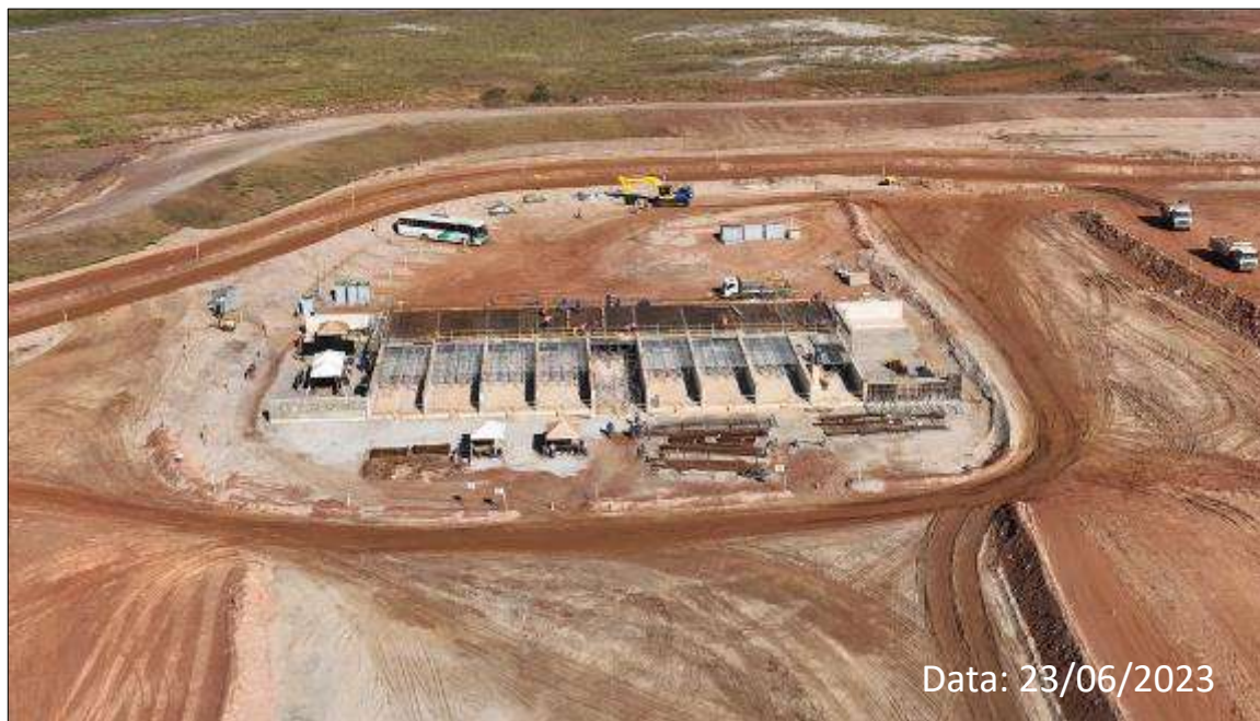
Foto 15: Travessia de Veículos (Obras em Andamento)
