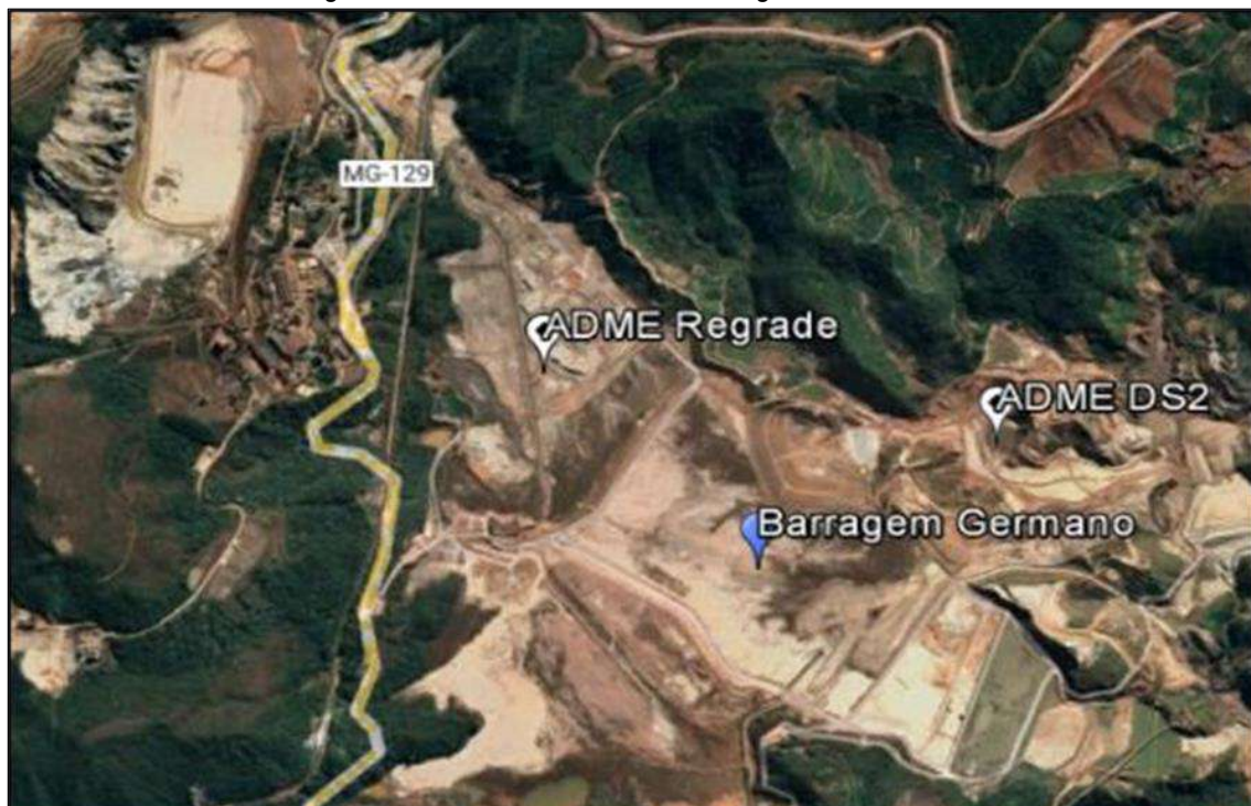
Figura 32: ADMEs das Obras na Barragem do Germano
