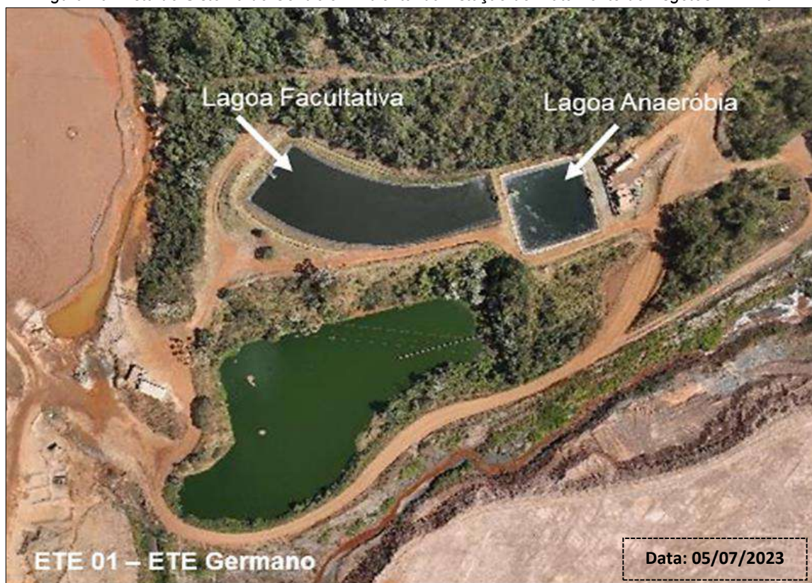
Figura 20: Vista do Sistema de Controle Ambiental da Estação de Tratamento de Esgotos - ETE 01
