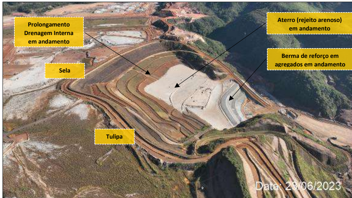
Foto 9: Visão Geral Berma de Reforço de Sela/Tulipa (Obras em Andamento)
