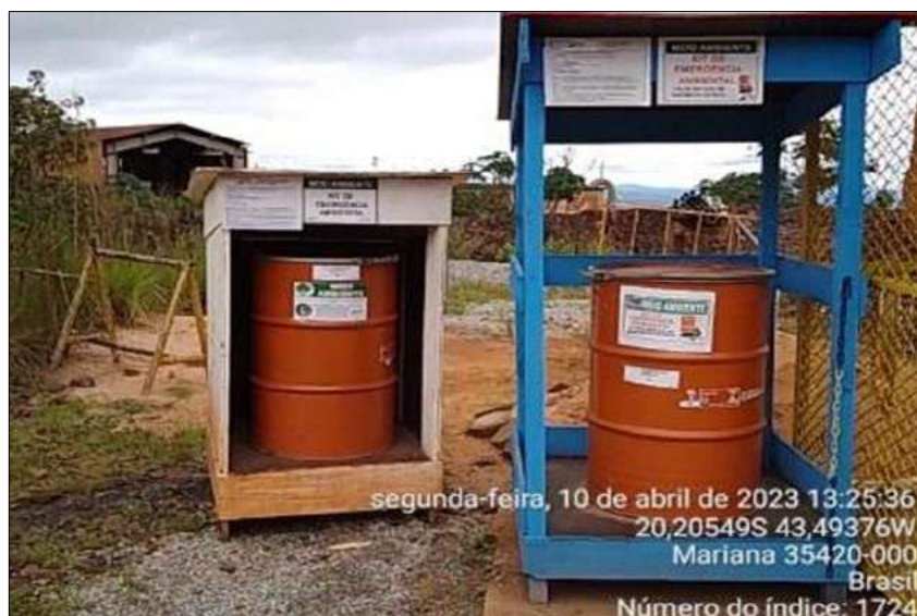
Figura 25: Kit de Emergência Ambiental na Frente de Serviço
