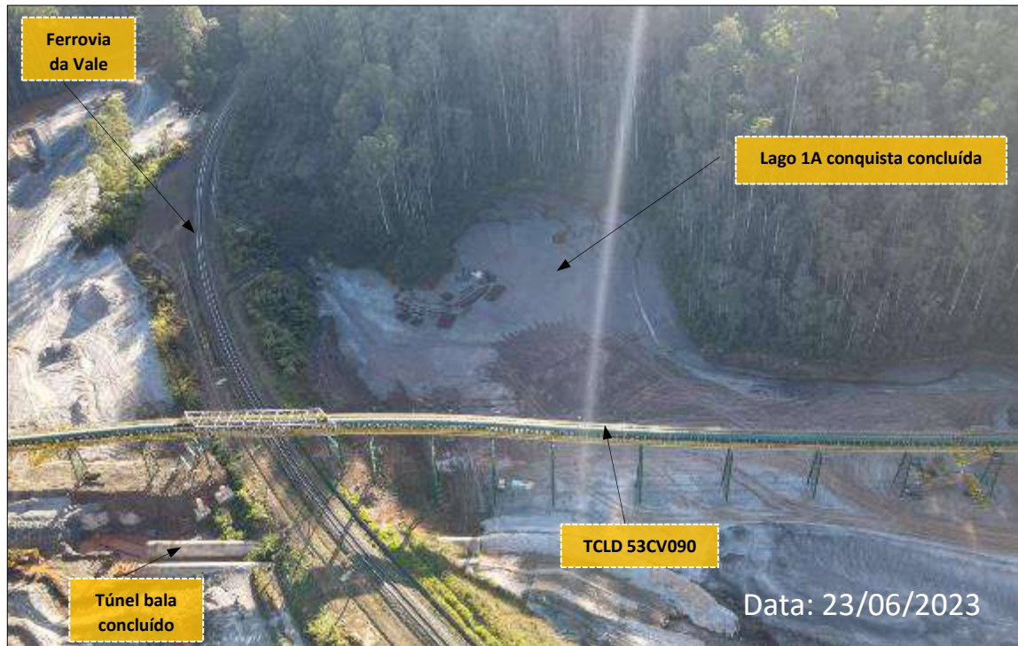
Foto 19: Montagem do TCLD 53CV090 na Região do Lago 1A
