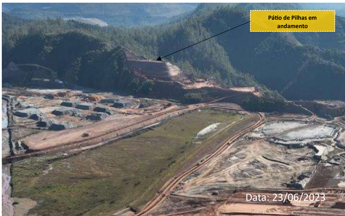
Foto 11: Região do Pátio de Pilhas (Obras em Andamento)
