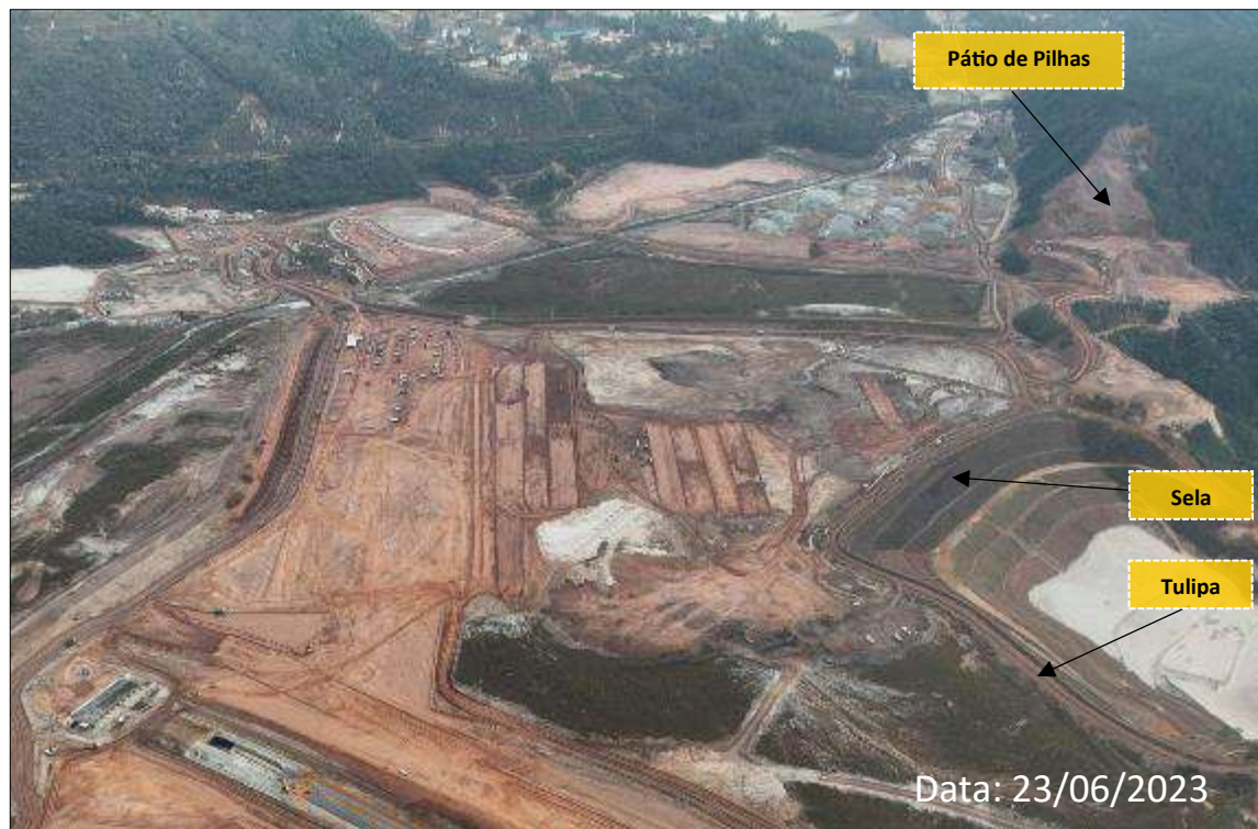
Foto 16: Região de Sela Tulipa (Obras em Andamento)
