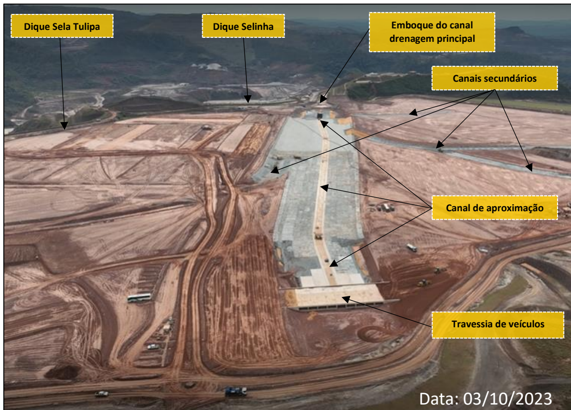
Foto 12: Região do Canal de Aproximação (Obras em Andamento)
