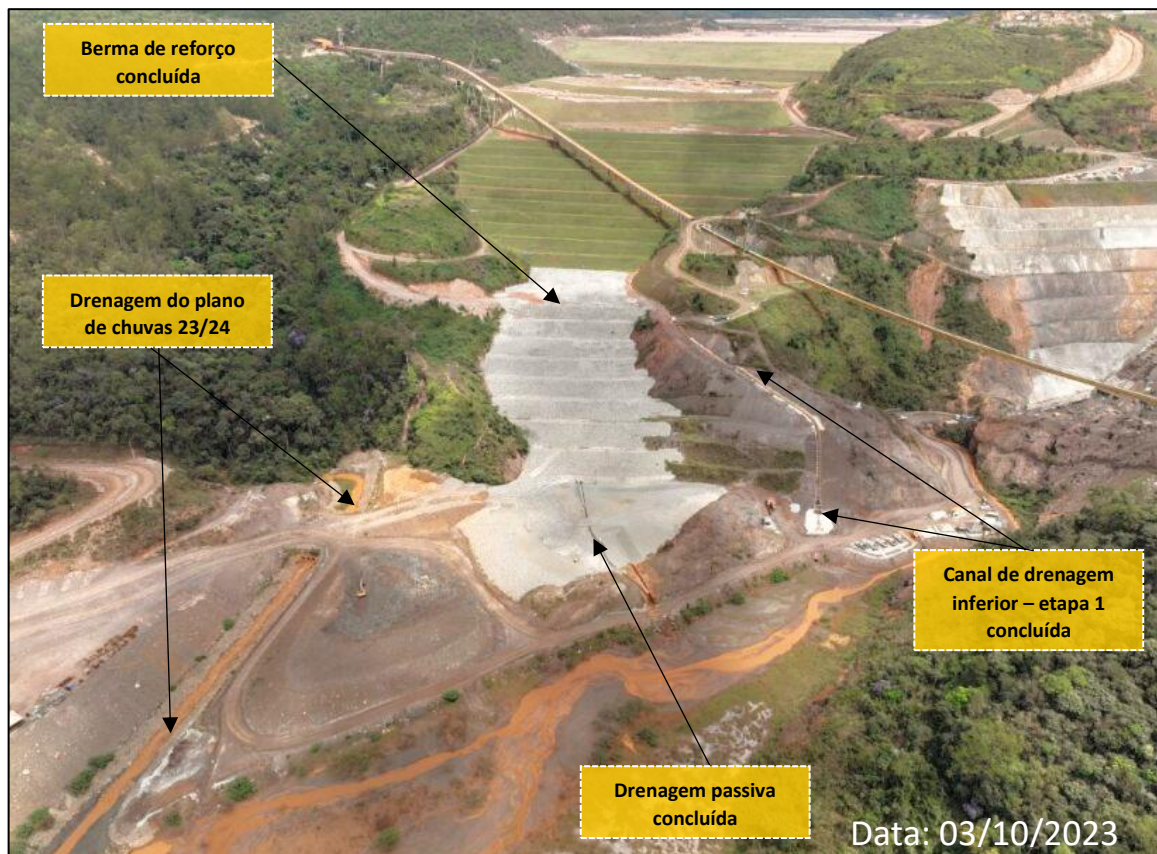
Foto 6: Vista da Berma de Reforço do Barramento Principal (Obras Concluídas)
