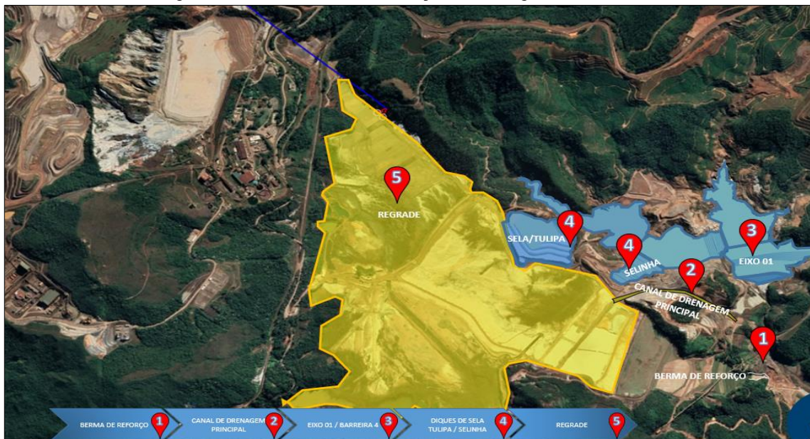
Figura 5: Obras de Descaracterização da Barragem do Germano
