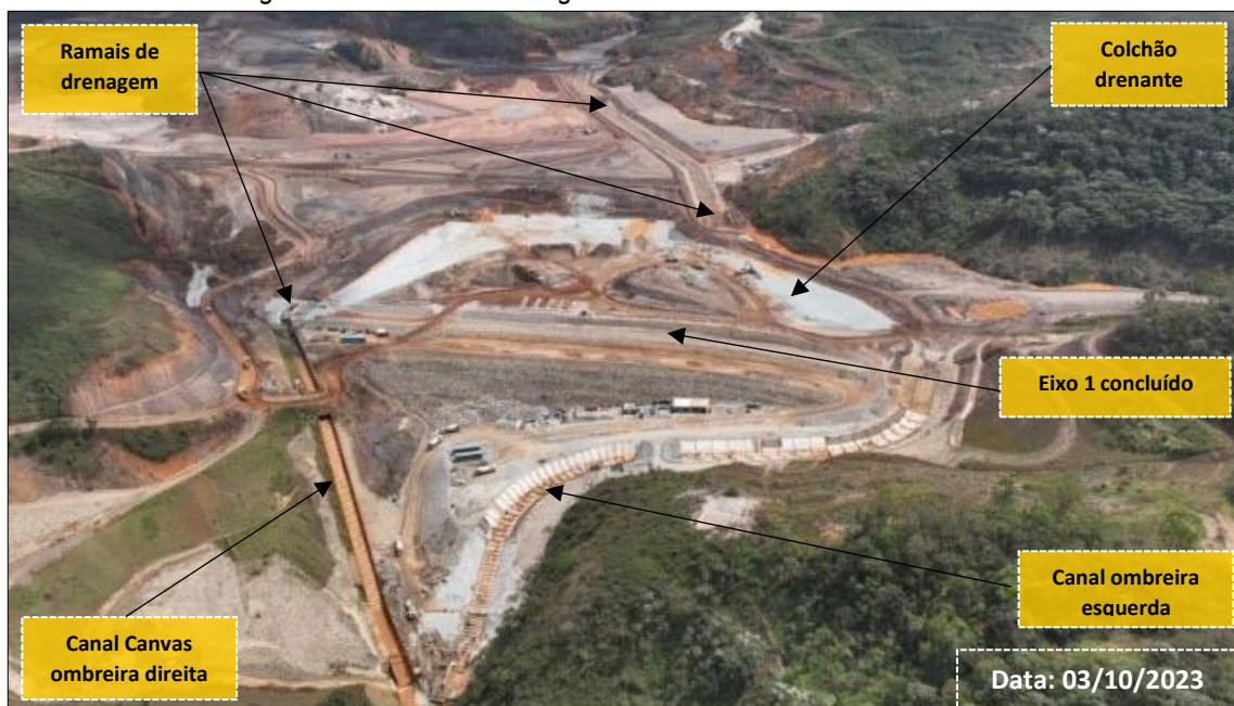
Figura 12: Canais de Drenagem do Eixo 1 – Obras em Andamento
