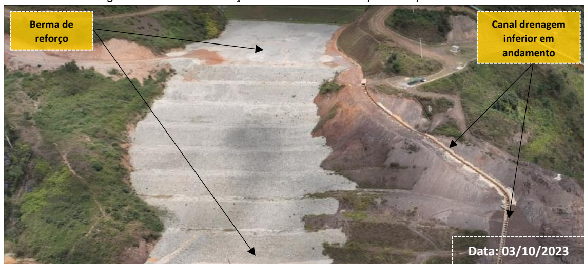
Figura 6: Berma de Reforço do Barramento Principal – Etapa Concluída
