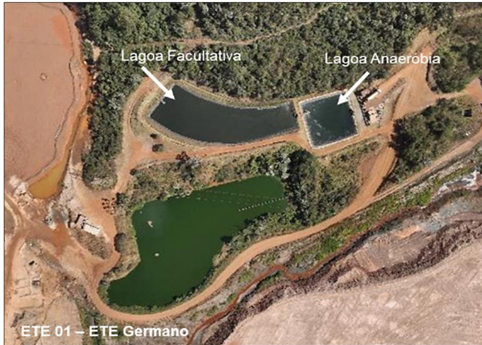
Figura 22: Vista do Sistema de Controle Ambiental da Estação de Tratamento de Esgotos - ETE 01
