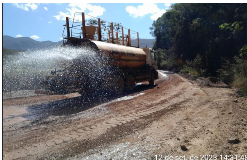
Figura 155: Umectação de vias na região da Cava de Germano
