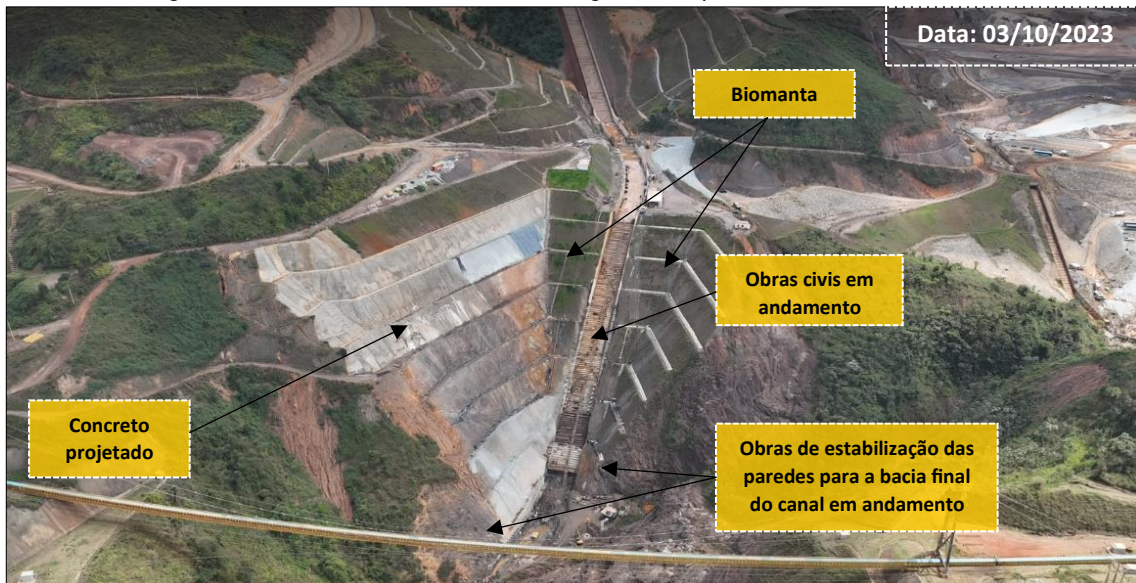
Figura 9: Trecho Final do Canal de Drenagem Principal – Obras em Andamento
