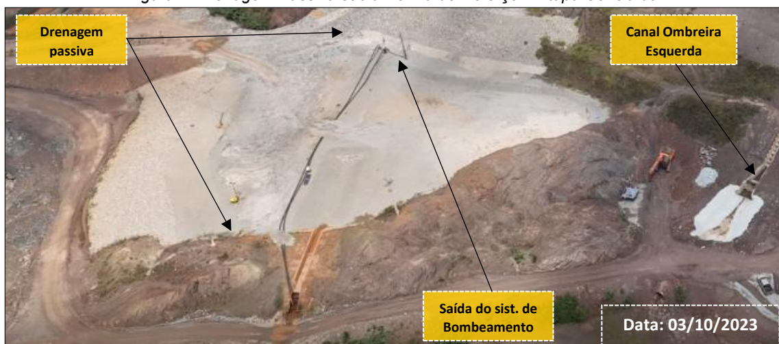
Figura 7: Drenagem Passiva sob a Berma de Reforço – Etapa Concluída
