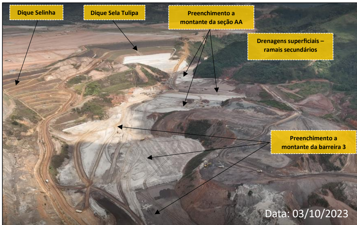
Foto 8: Vista das Obras do Vale do Fundão
