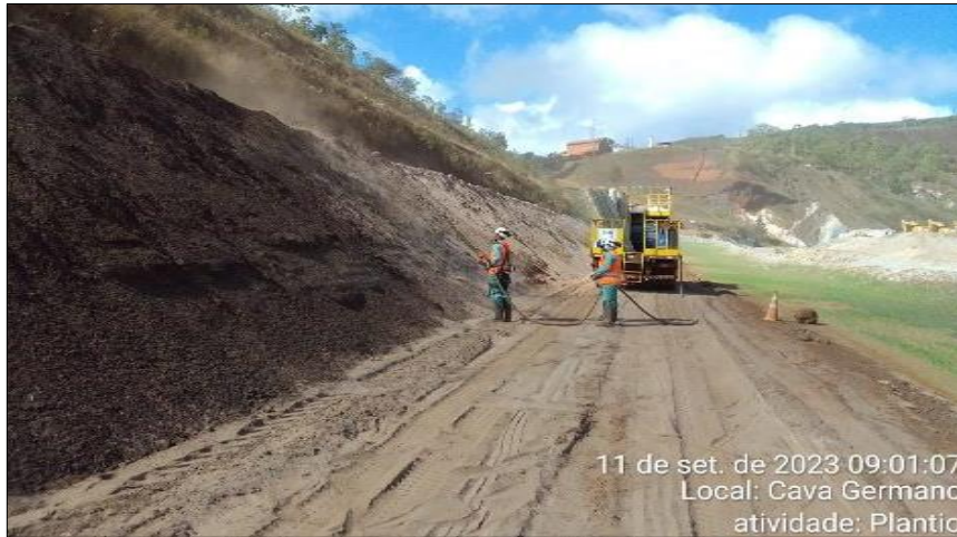
Figura 141: Aplicação de Hidrossemeadura na Região da Cava
