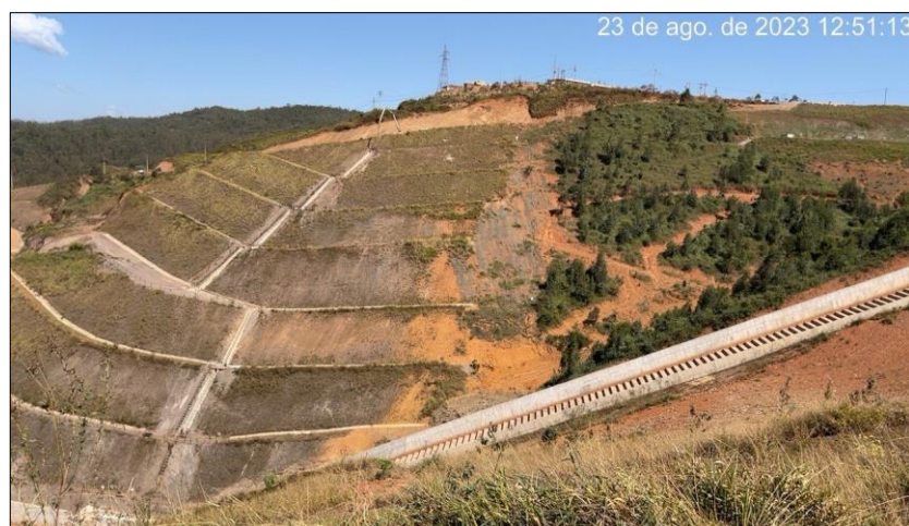
Figura 139: Vista dos Taludes do Canal Principal da Barragem
