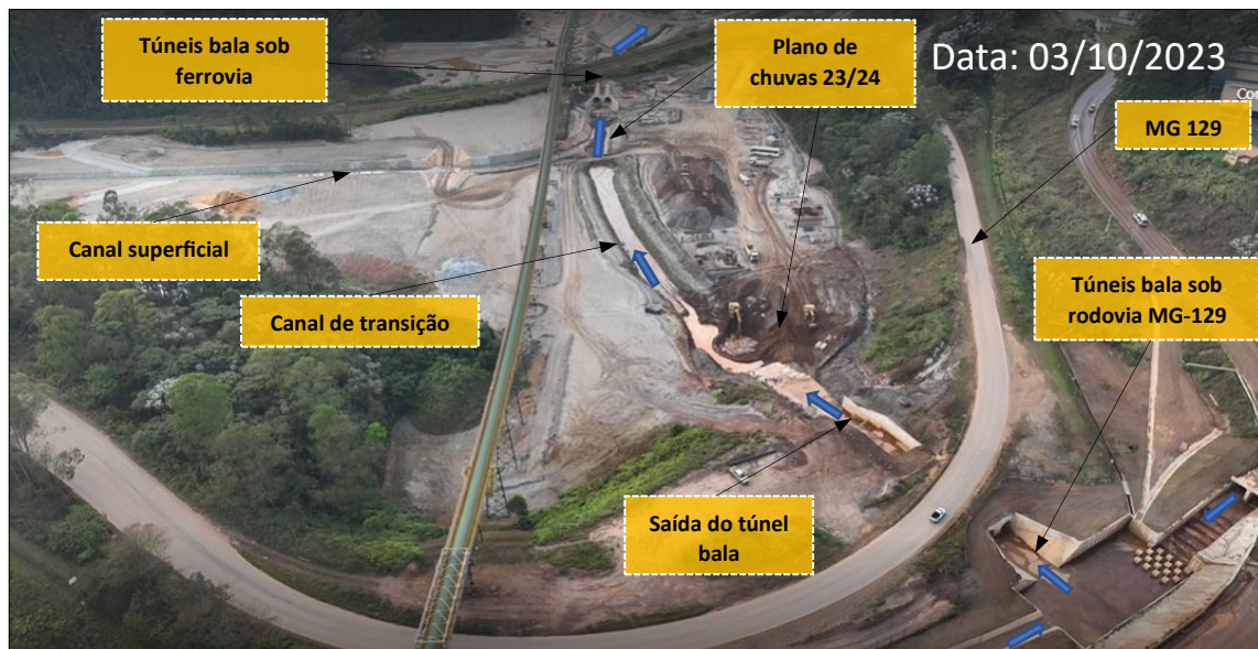
Foto 19: Canal de Transposição, Canal Superficial e Plano de Chuvas (Obras em Punch List)
