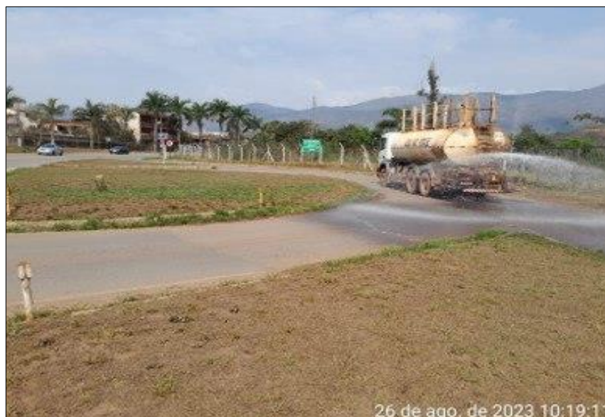
Figura 153: Umectação da rodovia MG-129
