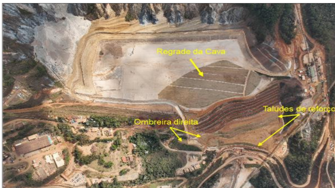
Figura 140: Vista dos Taludes do Canal Principal da Barragem
