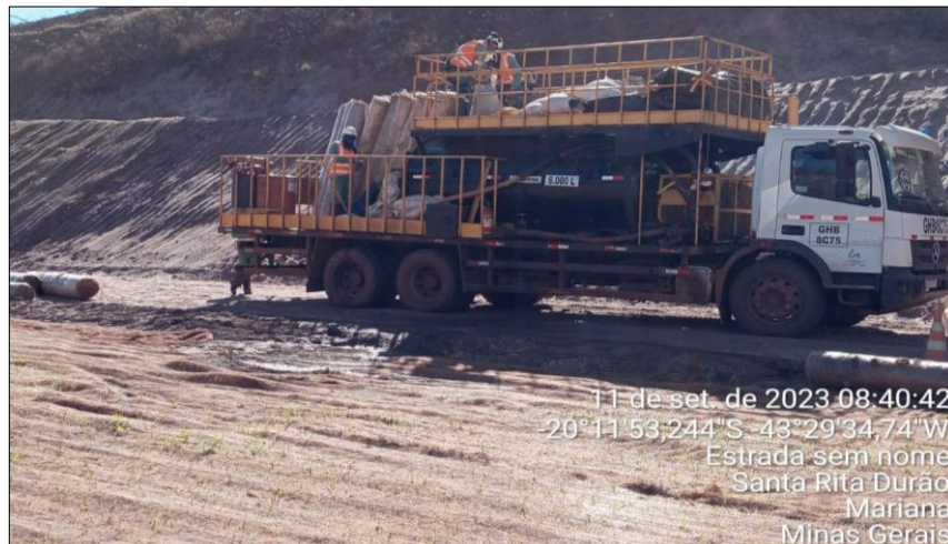
Figura 142: Aplicação de Biomanta na Região da Cava
