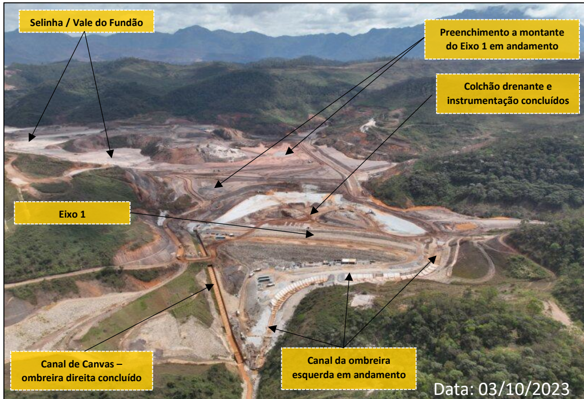
Foto 7: Vista do Eixo 1 – Obras de Preenchimento e Canal da Ombreira Esquerda em Andamento
