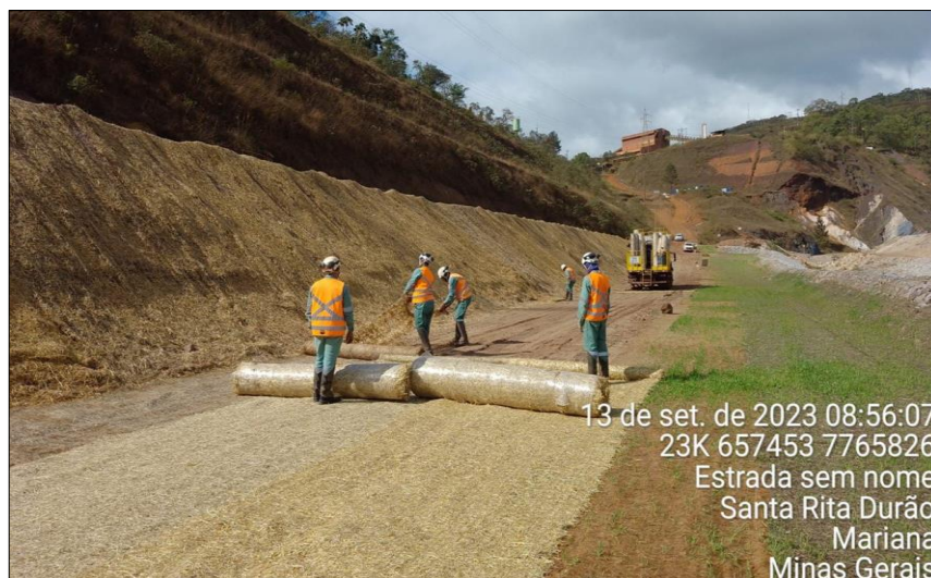
Figura 143: Aplicação de Biomanta na Região da Cava
