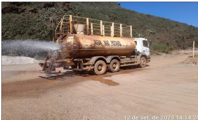
Figura 154: Umectação de vias na região da Barragem de Germano
