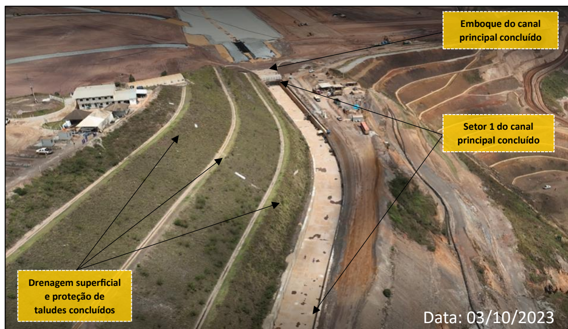
Foto 2: Vista do Setor 1 do Canal Principal (Obras Concluídas)
