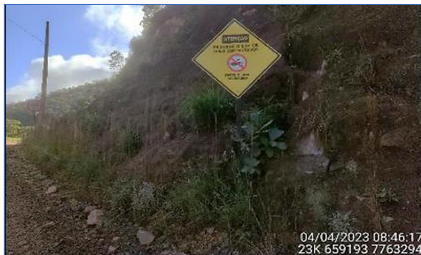
Figura 125: Sinalização – Acesso Restrito à Cavidade LOC-0149 e Proibição de Uso de Rolo Compactador
