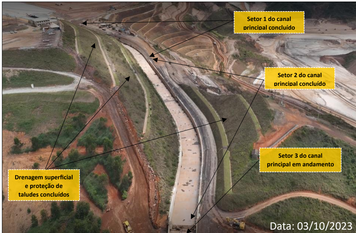
Foto 3: Vista do Setor 2 do Canal Principal (Obras Concluídas)
