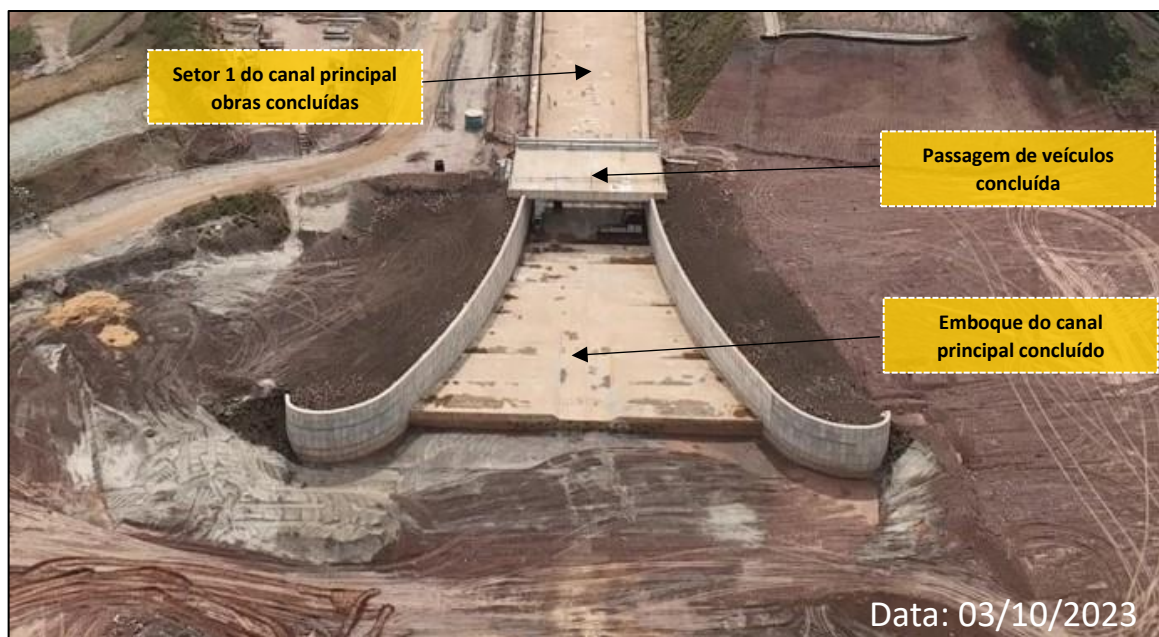
Foto 1: Emboque do Canal Principal (Obras Concluídas)
