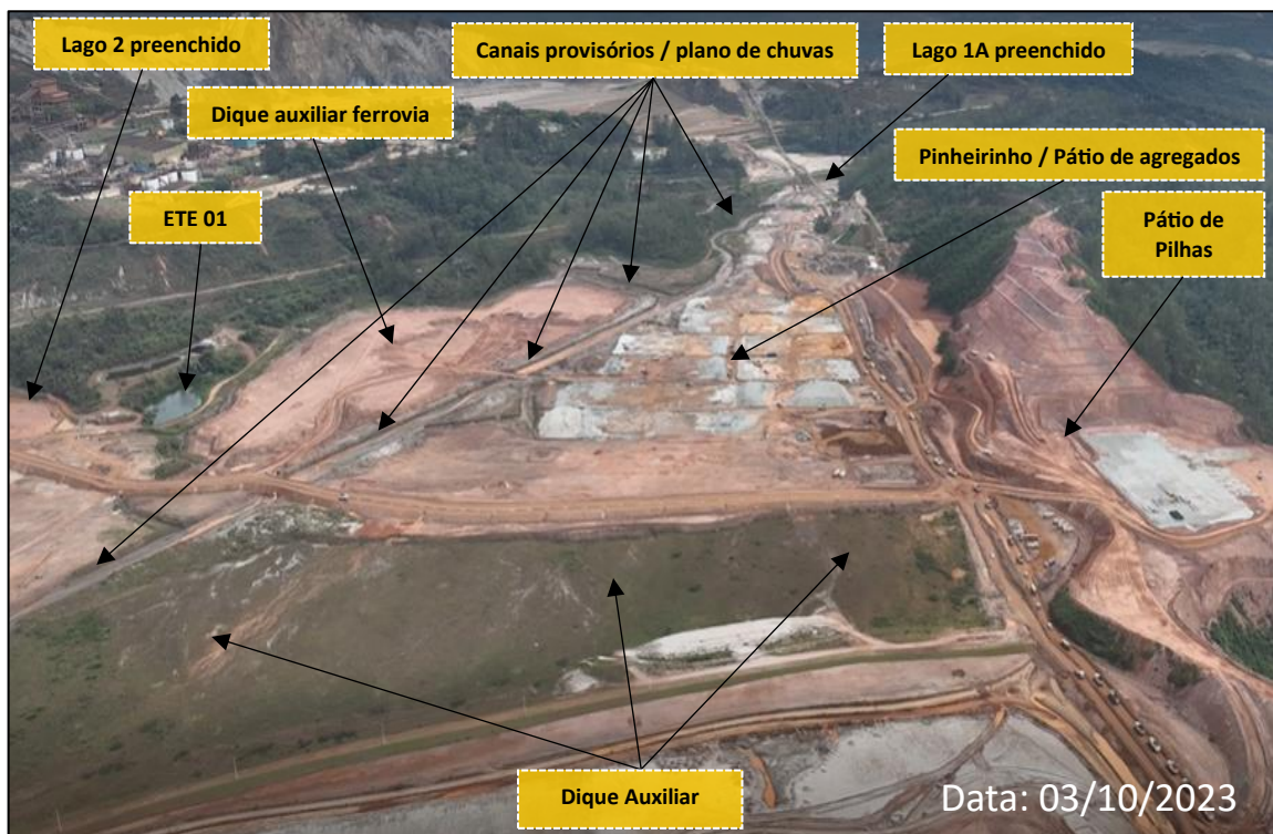
Foto 10: Regiões do Pinheirinho e Lagos 1, 1A e Dique Auxiliar da Ferrovia (Etapa 1 de Obras Concluídas)
