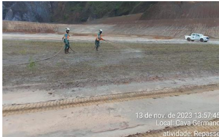
Figura 143: Ressemeio e Adubação de Cobertura (Repasse) na Região da Cava
