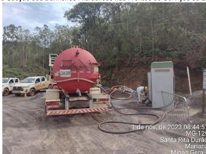
Figura 26: Limpeza e Sucção dos Banheiros Hidráulicos nas Frentes de Serviços da Barragem do Germano
