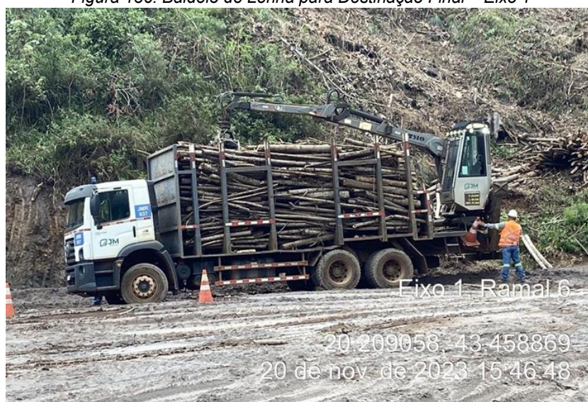
Figura 136: Baldeio de Lenha para Destinação Final – Eixo 1
