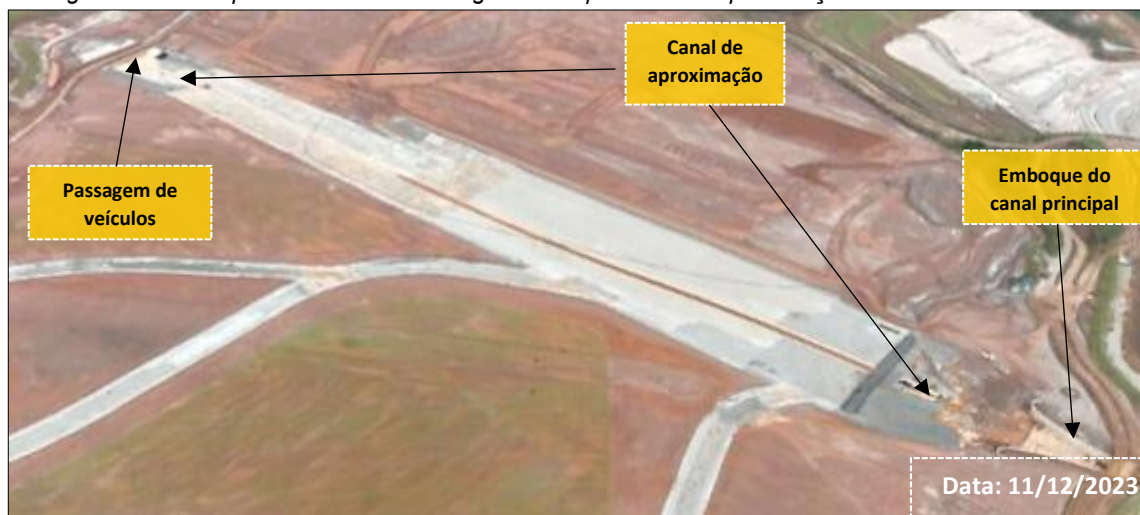
Figura 12: Emboque do Canal de Drenagem Principal e Canal Aproximação – Obras em Andamento
