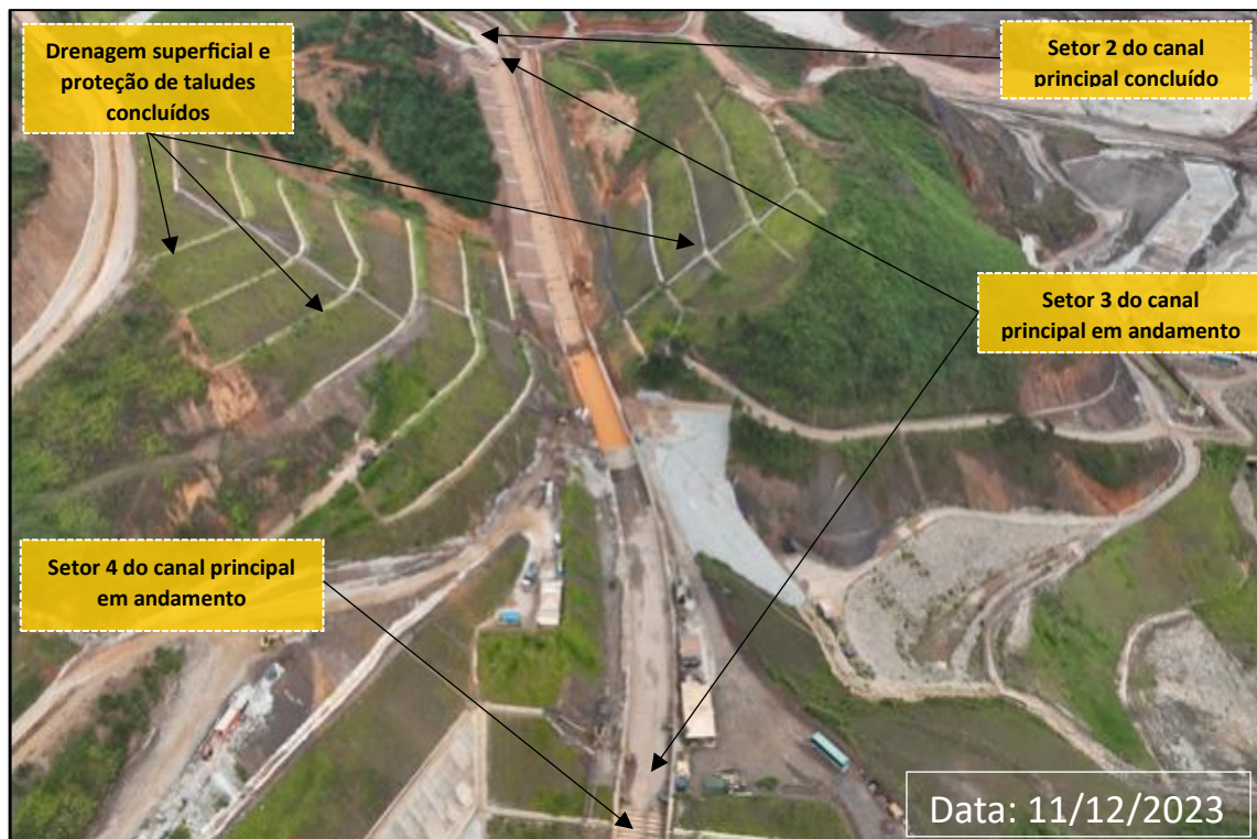
Foto 4: Vista do Setor 3 do Canal Principal – Paredes do Canal em Andamento
