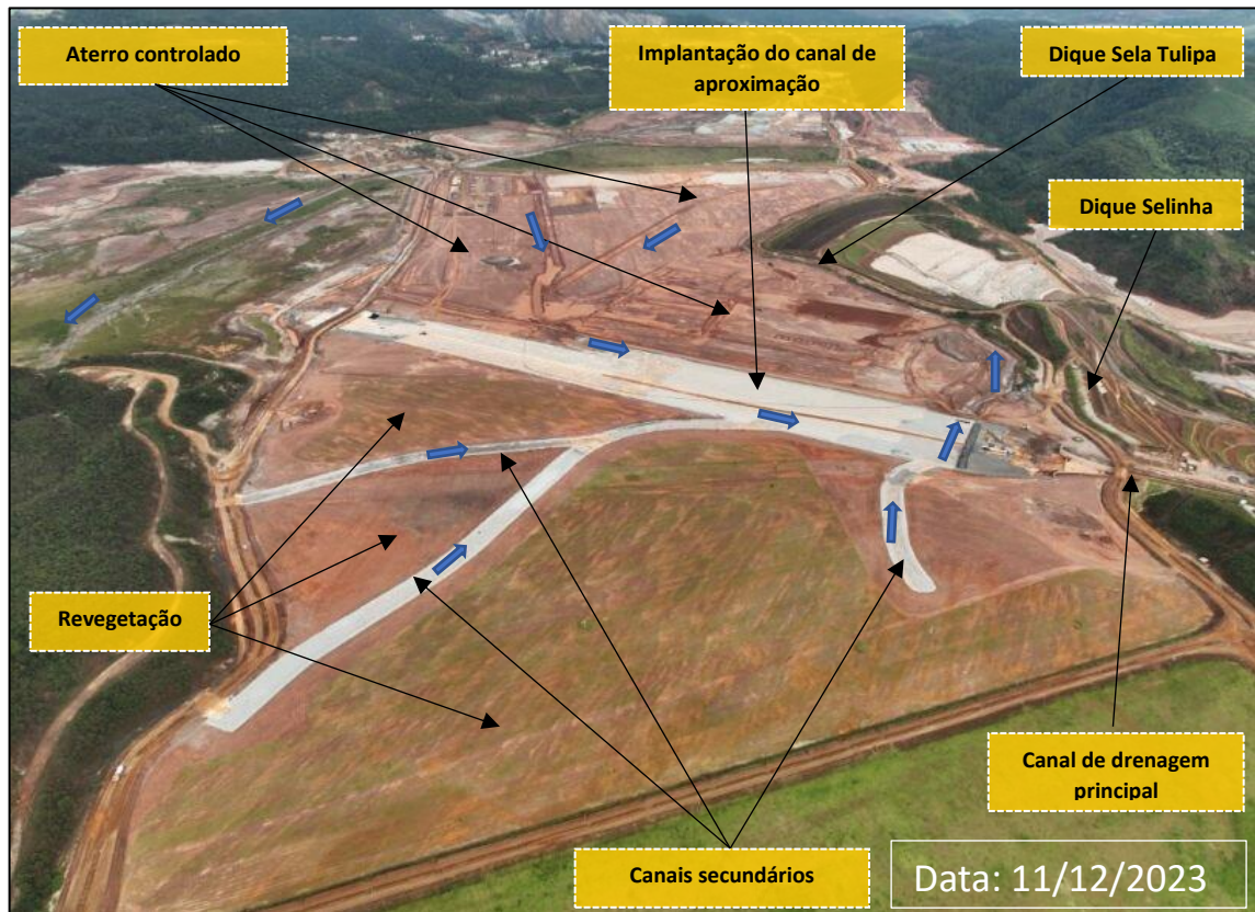
Foto 13: Regrade Regiões de Sela Tulipa e Canal de Aproximação (Obras em Andamento)
