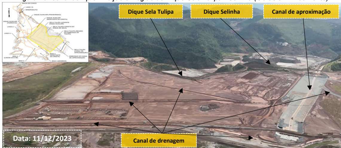
Figura 16: Canal de Aproximação e Região do Dique Sela Tulipa / Selinha (Obras em Andamento)
