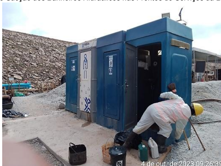
Figura 25: Limpeza e Sucção dos Banheiros Hidráulicos nas Frentes de Serviços da Barragem do Germano
