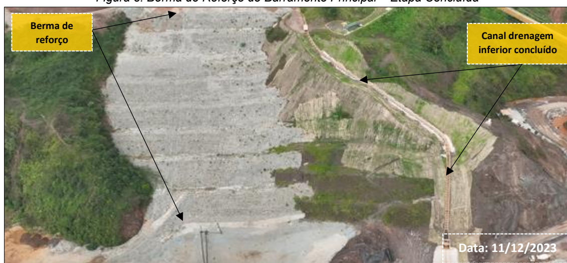
Figura 8: Berma de Reforço do Barramento Principal – Etapa Concluída
