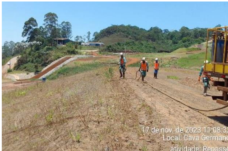
Figura 146: Ressemeio e Adubação de Cobertura (Repasse) na Região da Cava
