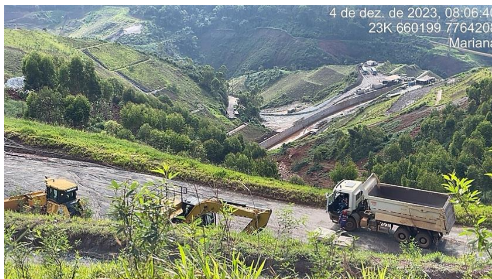
Figura 141: Vista dos Taludes do Canal Principal da Barragem
