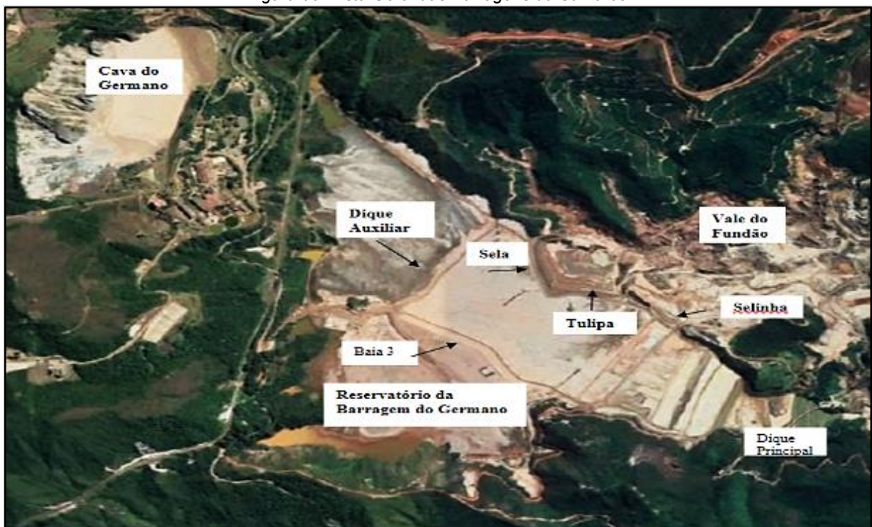
Figura 65: Vista Geral das Barragens da Samarco
