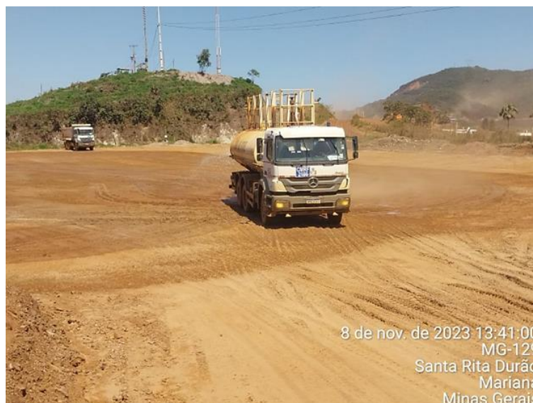
Figura 156: Umecção de Vias na Região da Barragem do Germano
