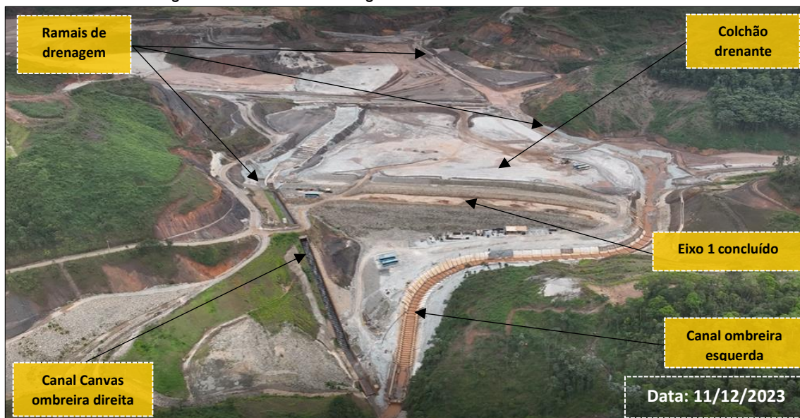
Figura 14: Canais de Drenagem do Eixo 1 – Obras em Andamento
