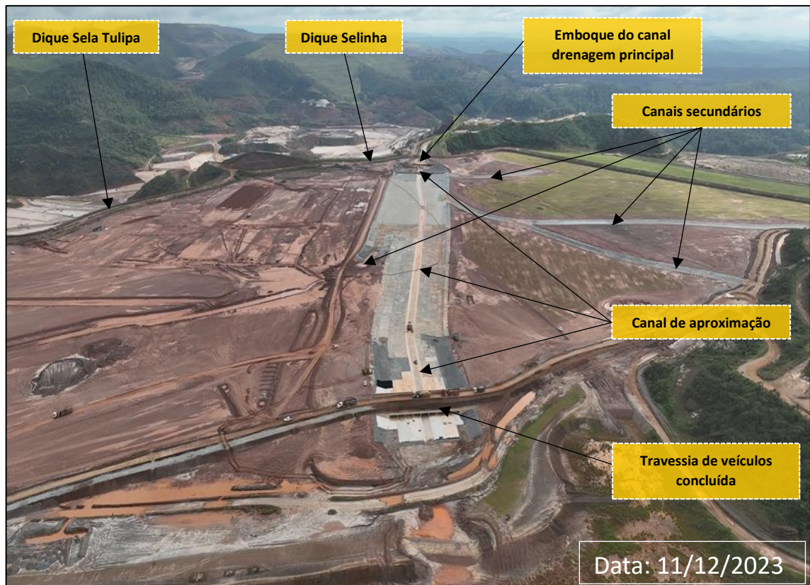
Foto 12: Região do Canal de Aproximação (Obras em Andamento)
