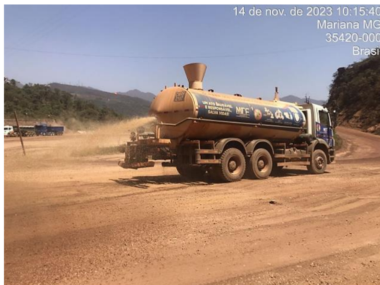
Figura 157: Umectação de Vias na Região da Barragem do Germano
