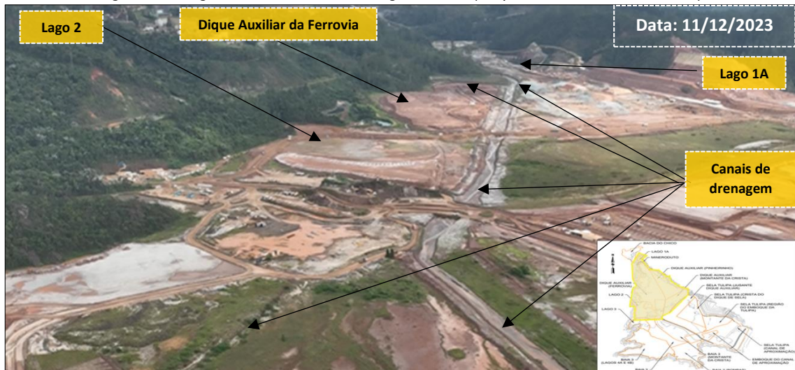
Figura 15: Regiões do Pinheirinho e Lagos 1 e 1A (Etapa 1 de Obras Concluídas)
