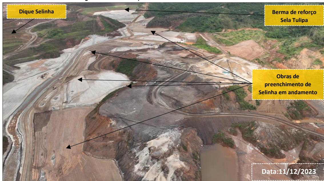
Figura 13: Sela Tulipa e Selinha – Obras em Andamento
