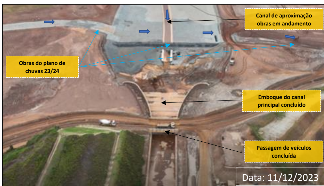
Foto 1: Emboque do Canal Principal (Obras Concluídas)
