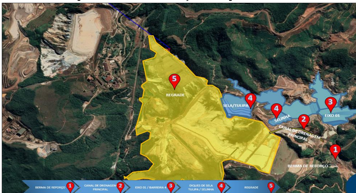
Figura 7: Obras de Descaracterização da Barragem do Germano
