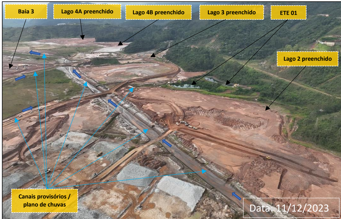
Foto 11: Região da Baía 3 e dos Lagos 2, 3, 4A e 4B (Obras em Andamento)
