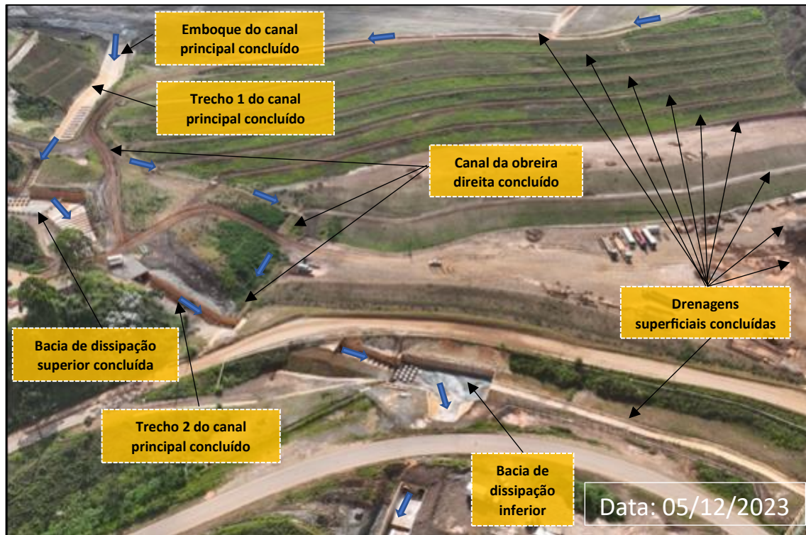
Foto 17: Canal Drenagem Principal, Canal Ombreira Direita e Drenagens Superficiais (Obras Concluídas)
