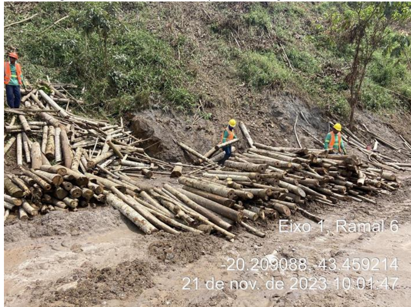
Figura 137: Baldeio de Lenha para Destinação Final – Eixo 1
