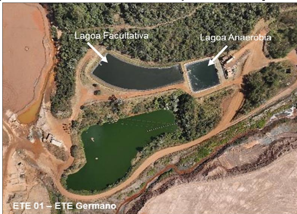
Figura 24: Vista do Sistema de Controle Ambiental da Estação de Tratamento de Esgotos - ETE 01
