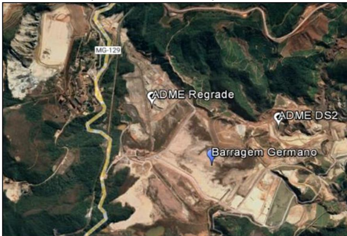
Figura 36: ADMEs das Obras na Barragem do Germano
