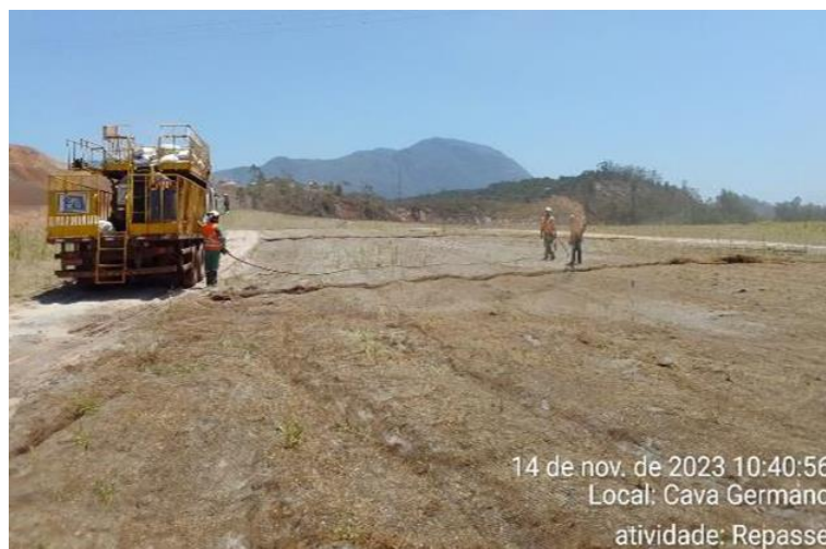
Figura 144: Ressemeio e Adubação de Cobertura (Repasse) na Região da Cava
