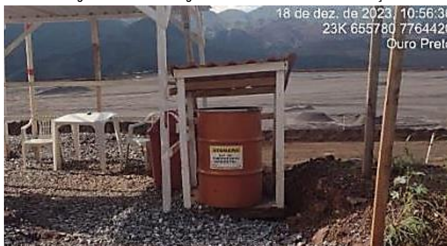
Figura 29: Kit de Emergência Ambiental na Frente de Serviço
