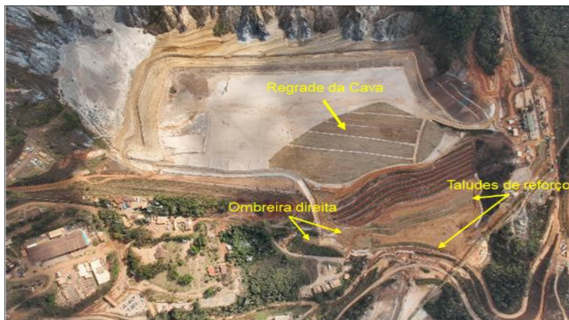
Figura 142: Vista dos Taludes do Canal Principal da Barragem
