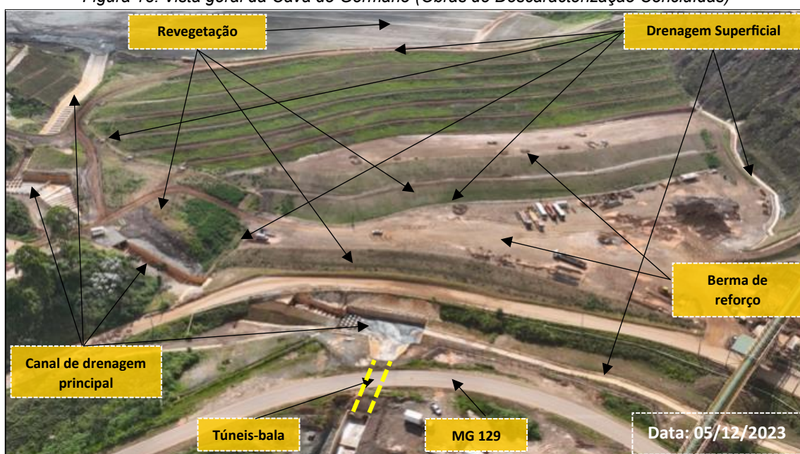
Figura 18: Vista geral da Cava do Germano (Obras de Descaracterização Concluídas)
