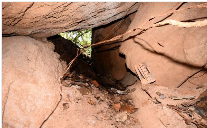
Figura 133: Monitoramento de Integridade Física Ponto de Fragilidade P3 da cavidade LOC-0291
