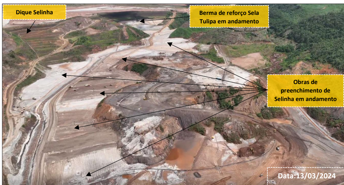
Figura 13: Região a Jusante de Sela Tulipa e Selinha – Obras em Andamento
