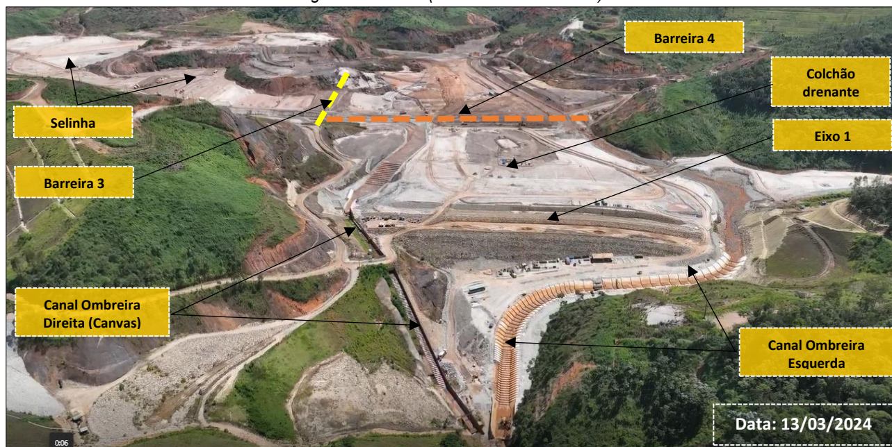
Figura 67: Eixo 1 (Obras Em Andamento)
