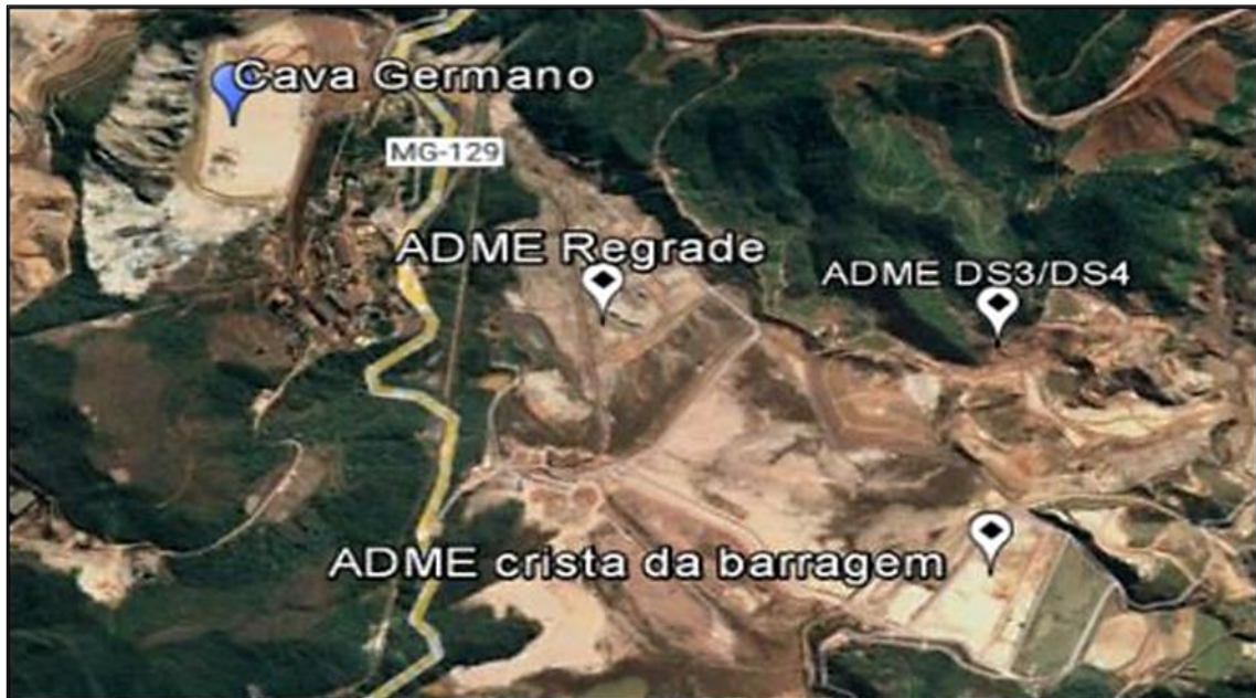
Figura 38: ADMEs das Obras na Cava do Germano
