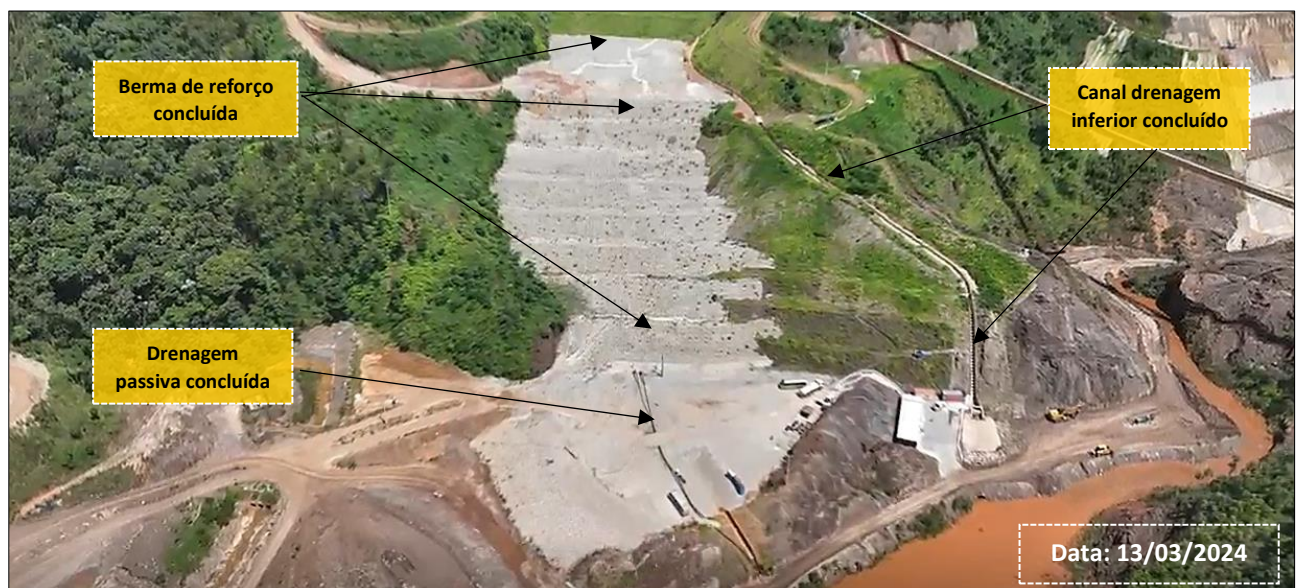
Figura 56: Berma de Reforço e Retaludamento do Barramento Principal – Etapas Concluídas
