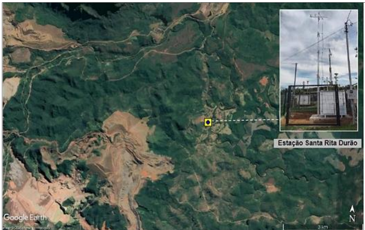
Figura 153: Estação Automática de Monitoramento da Samarco em Santa Rita Durão
