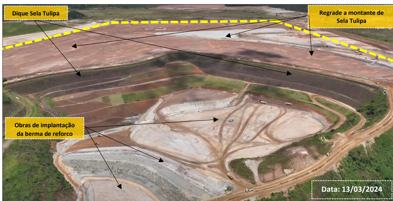
Figura 58: Dique Sela Tulipa – Implantação da Berma de Reforço e Regrade a Montante (Obras Em Andamento)
