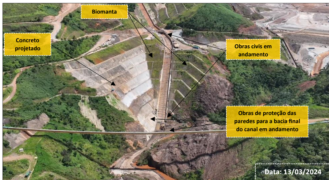
Figura 11: Trecho Final do Canal de Drenagem Principal – Obras em Andamento
