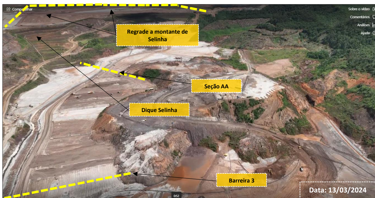
Figura 59: Dique Selinha – Preenchimento a Montante da Barreira 3 e Seção AA (Obras Em Andamento)
