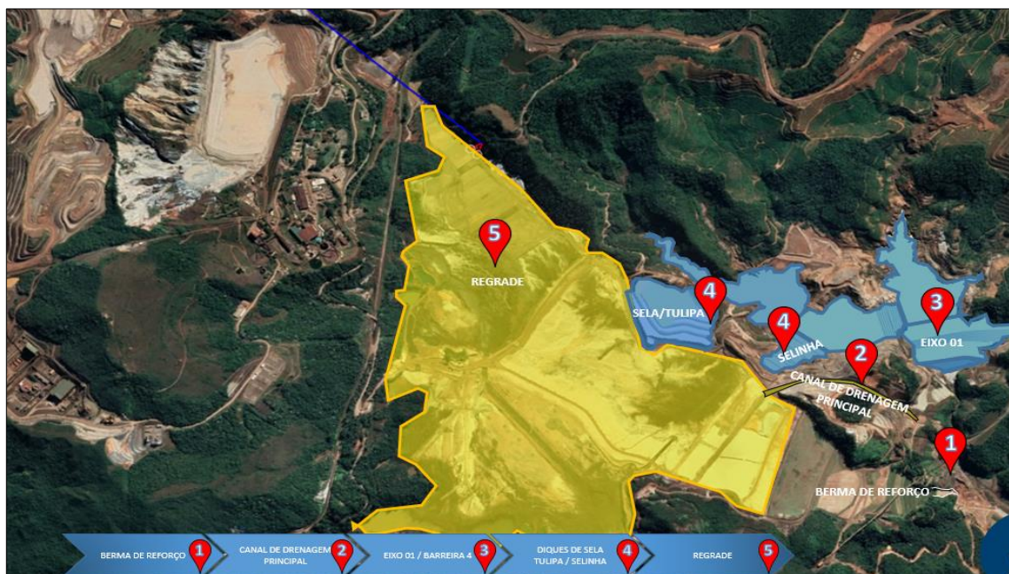
Figura 7: Obras de Descaracterização da Barragem do Germano
