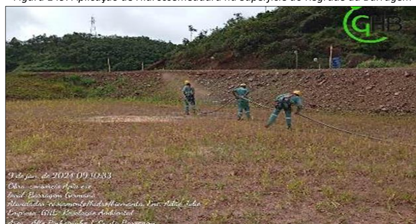
Figura 149: Aplicação de Hidrossemeadura na Superfície do Regrade da Barragem
