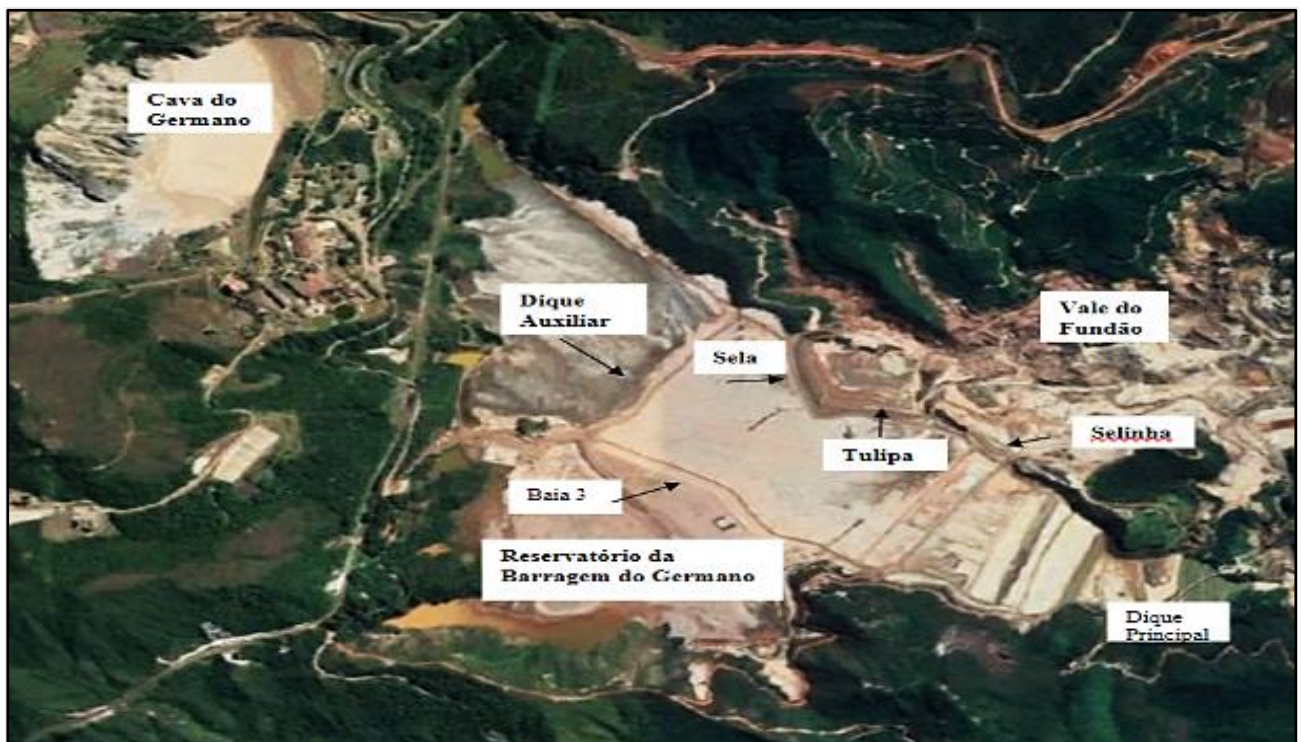
Figura 78: Vista Geral das Barragens da Samarco
