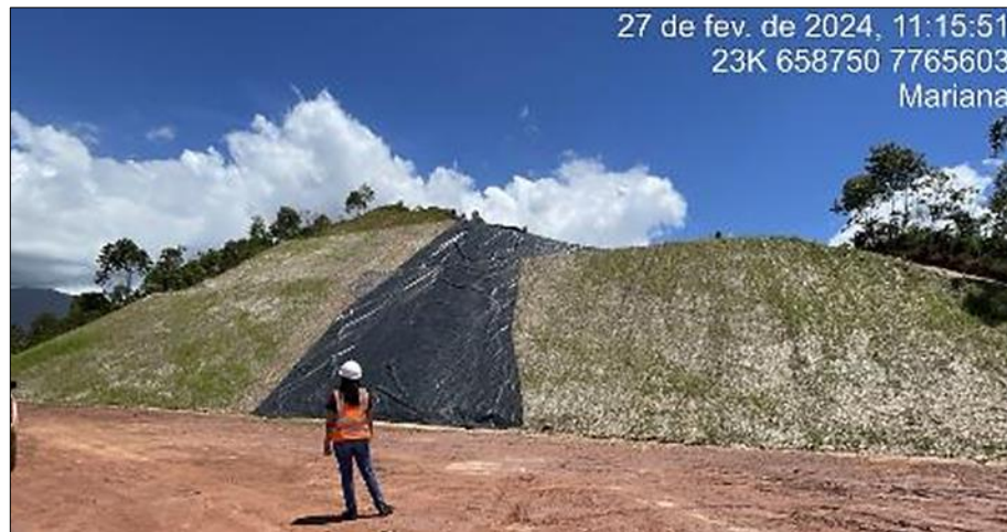
Figura 151: Avaliação dos Taludes do Canal de Drenagem Principal
