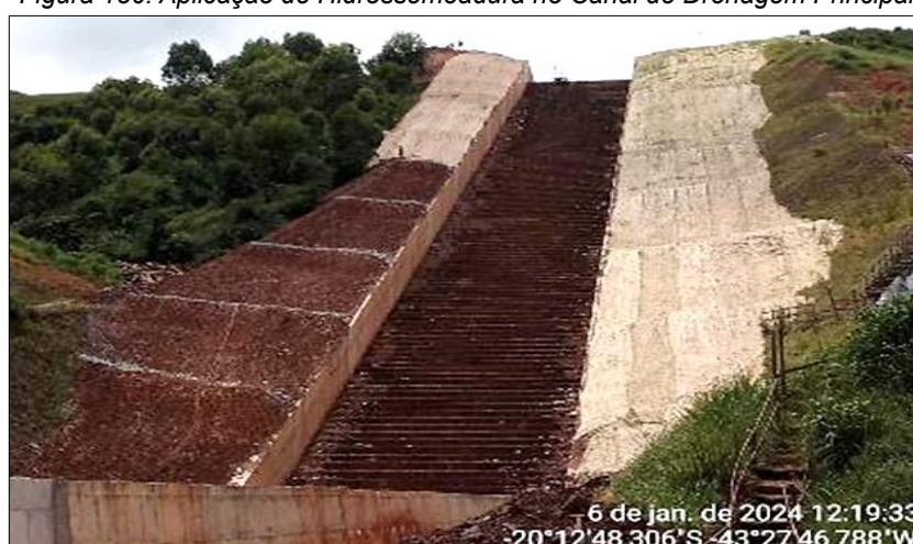
Figura 150: Aplicação de Hidrossemeadura no Canal de Drenagem Principal
