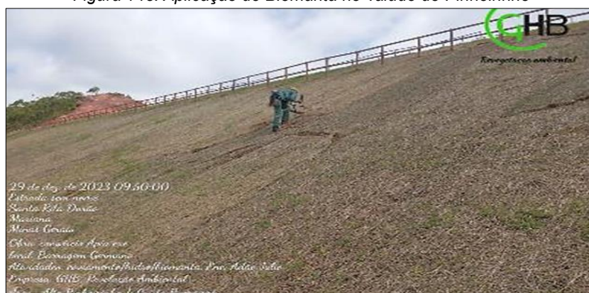
Figura 148: Aplicação de Biomanta no Talude do Pinheirinho
