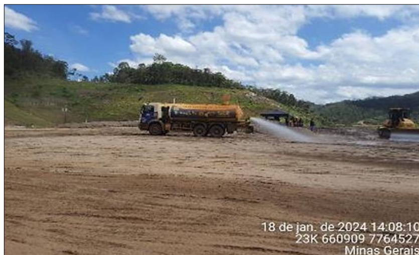
Figura 161: Umectação de Vias na Região dos Canteiros da Barragem do Germano
