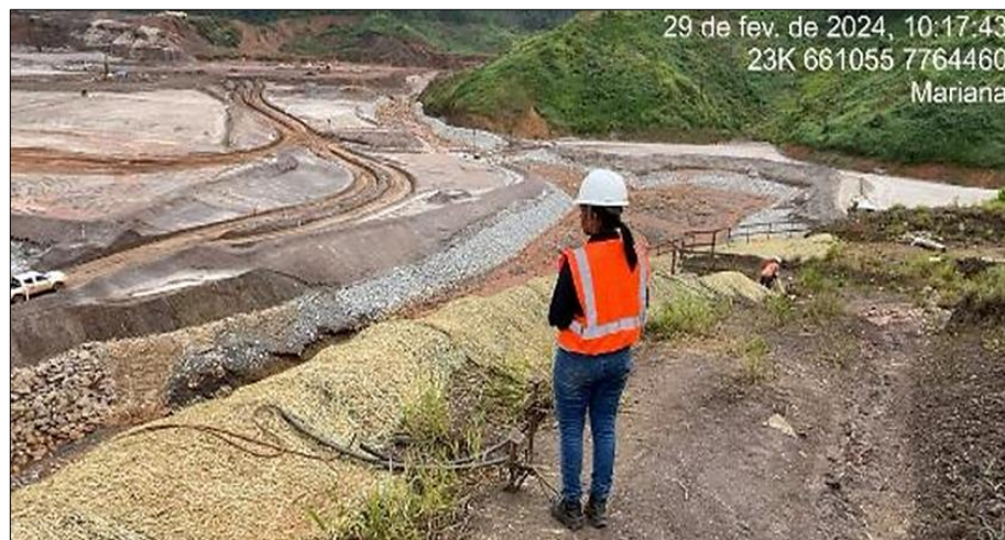
Figura 152: Avaliação dos Taludes na Região de Selinha
