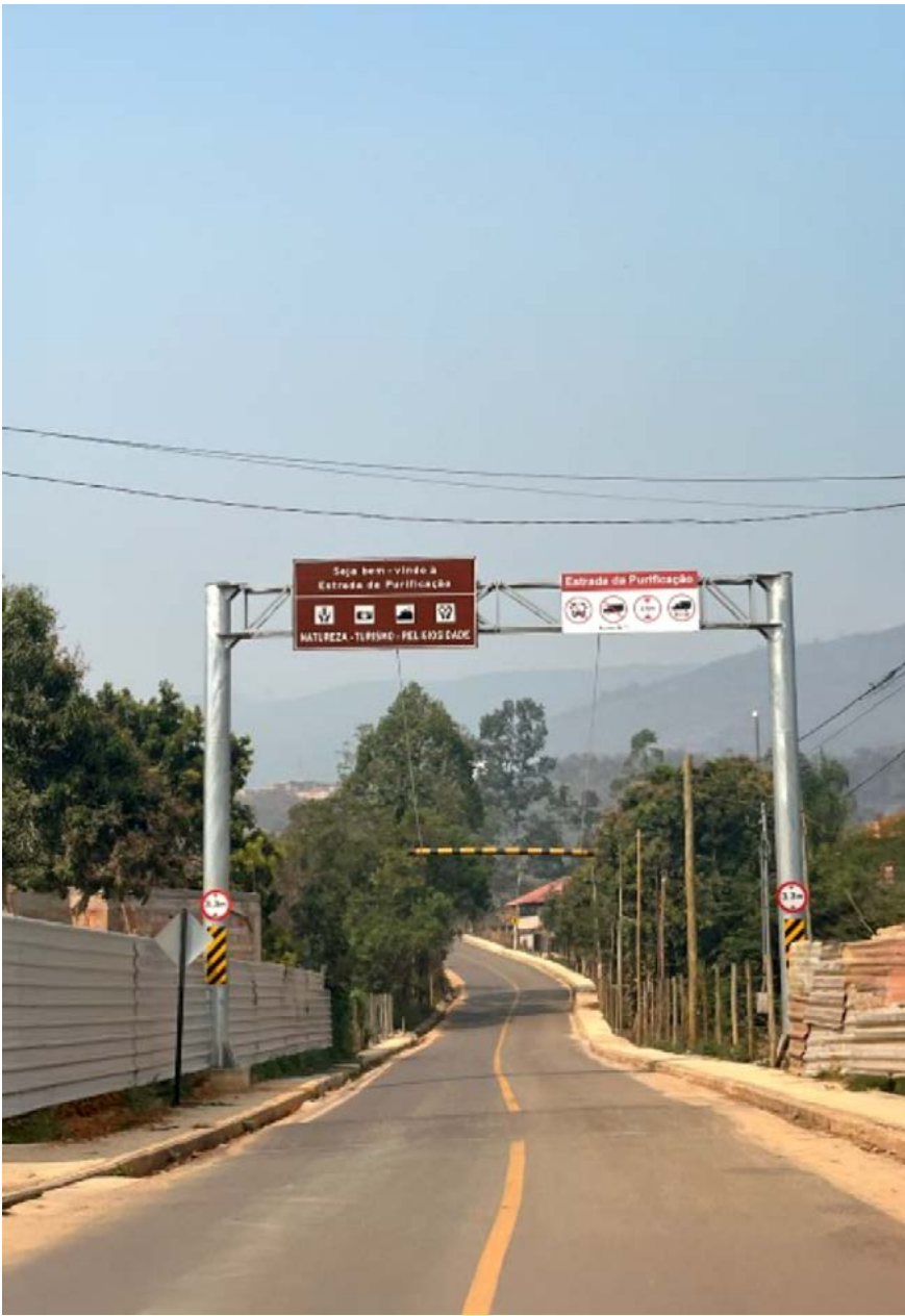
Estrada da Purificação – Ouro Preto – MG
