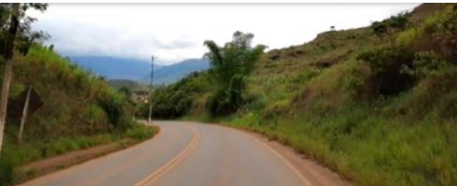
Rodovia MG-129 próxima a Antônio Pereira, em Ouro Preto - Fonte: BRANDT, 2022.
